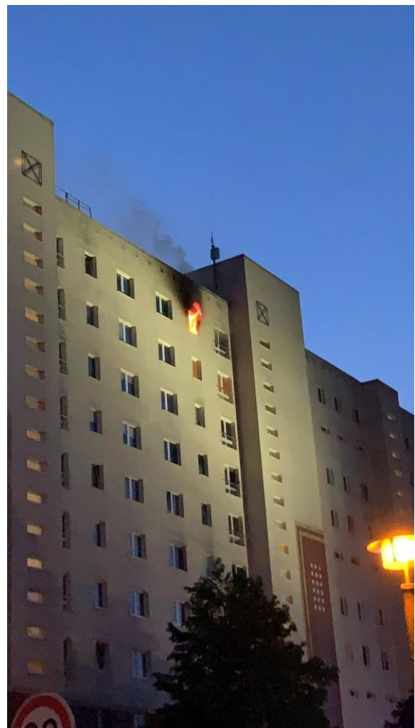
Abbildung 11 Ansicht des Brandgeschosses
