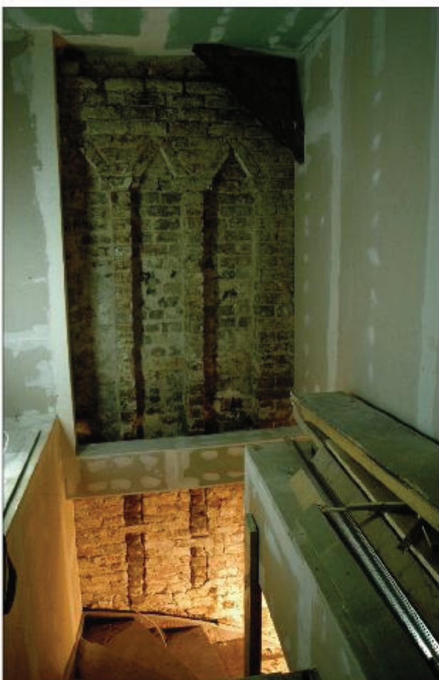
Abb. 5 Fischstraße 17. Im Treppenhaus des heutigen Gebäudes sind Teile des ehemals zum benachbarten Traufenhauses gehörenden monumentalen Seitengiebels erhalten geblieben. Die schlanken Blendenformen mit ihren spitzwinkligen Abschlüssen deuten auf eine Bauzeit um 1290 und finden sich auch im Greifswalder Kirchenbau wieder („Kalkhaus“ der Marienkirche). Foto: A. Lutze
