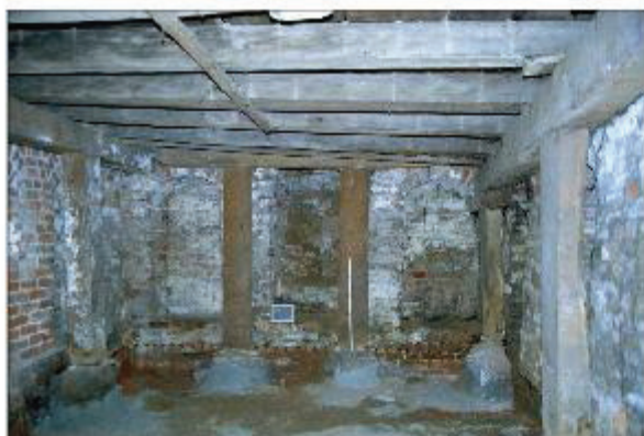
Abb. 8 Markt 13. Kamladenkeller, Blick nach Ost. Das Mauerwerk datiert in die 1. H. 14. Jh. Die Balkendecke wurde in vermutlich im 16. Jh. eingezogen. Foto: Ewald / Kaiser
