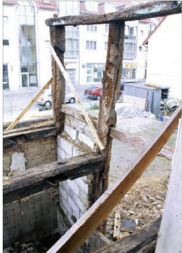
Abb. 8 Mühlenstraße 7. Reste eines um 1500 errichteten Fachwerkbaues an der Ecke Mühlenstraße / Brüggestraße. Zusammen mit den Deckenbalken über Erd- und Obergeschoss hatten sich Teile der zweigeschossigen Hoffassade in Form von Stielen, Riegeln sowie einer (im Bild nicht sichtbaren) Verschwertung zum abschließenden Rahm erhalten. Foto: Lutze
