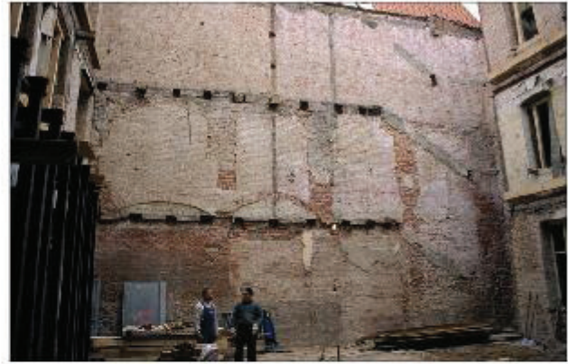
Abb. 2 Markt 24. Blick auf die grundstückstrennende Brandmauer zum Eckhaus Markt 25 mit den im 19. Jahrhundert zugesetzten typischen Nischengliederungen des ursprünglichen Baubestandes aus dem 15.Jh. Foto: Lutze
