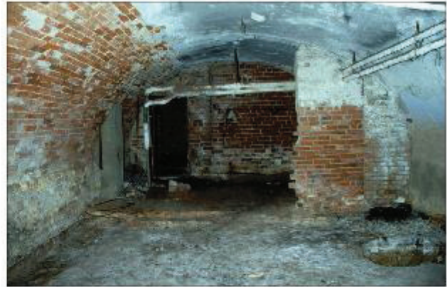
Abb. 6 Markt 13, Kellergewölbe von 1734. Ab etwa 1730 wurden bei Neubauten oder größeren Reparaturen immer häufiger die Kellergeschosse der betreffenden Häuser eingewölbt. Daß diese Entwicklung keineswegs selbstverständlich war, zeigt der Blick ins benachbarte Stralsund. Dort entstanden noch weit bis in das 18. Jahrhundert Balkendecken über den Kellern. Foto: Rütz
