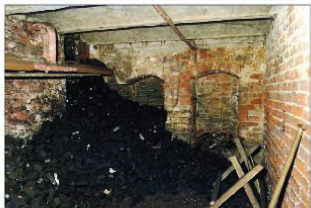
Abb. 2 Lange Str. 77. Mittelalterlicher Keller unter dem Haupthaus. Foto: flütz
