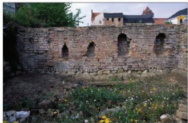
Abb. 3 Rakower Straße B. Eine der ältesten Backsteinmauern Greifswalds wurde vor dem Tiefgaragenneubau an der Rakower Straße erfaßt. Die Backsteinformate und -farbe sowie Gründungstechnik und Nischenformen ließen auf eine Entstehung um 1270 schließen. Foto: Lutze
