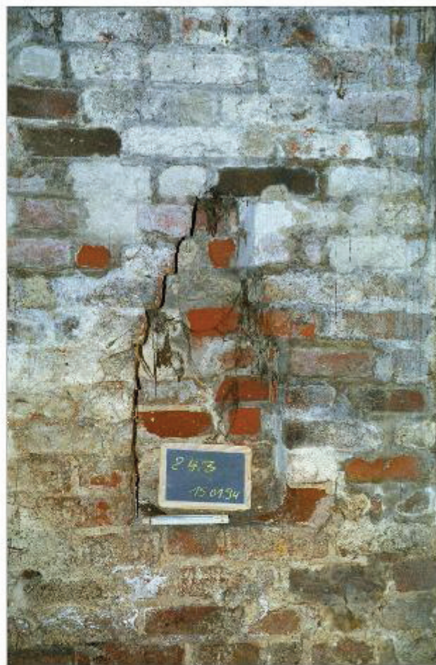
Abb. 7 Markt 13, Kamladenkeller, Detail Wand, mehrfach abgetreppte Nische, typische Nischenform des ausgehenden 13. Jhs. Foto: Ewald / Kaiser
