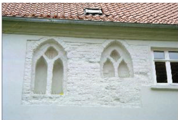
Abb. 1 Lange Str. 54. Seite zur Hunnenstrasse. Fassadendetail. Sichtenfenster mit gotischen Mauerresten. Foto: Musloff
