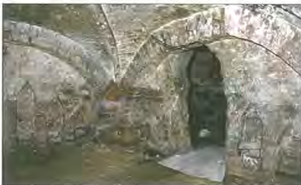
Abb. 12 Greifswald, Lange Straße 51. Blick auf die Nordwestecke des mittelalterlichen Kellerraumes. Die Wandflächen sind durch spitzwinklig geschlossene Nischen gegliedert. Rechts ist der Türdurchbruch für eine barocke Kellererweiterung sichtbar. Foto: T. Rütz
