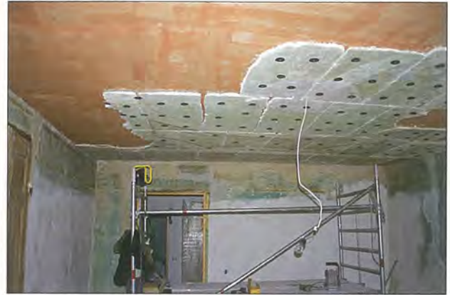
Abb. 14 Greifswald, Joh.- S.- Bach- Str. 20, OG, Raum 4, Wiederanbringung der Deckenplatten. Foto: C. Kohl, 1997
