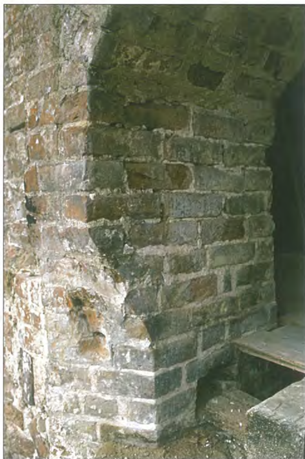
Abb. 10 Greifswald, Lange Straße 51. Blick auf den Übergang vom Pfeiler auf den Gurtbogen an der Südostseite des westlichen Freipfeilers. Zeichnung: T. Rütz
