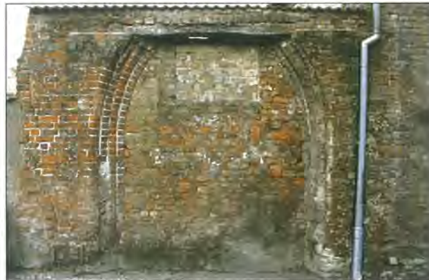
Abb. 2 Greifswald, Lange Straße 51. Das in barocker Zeit zugesetzte Ostportal vor der Sanierung. Blick von Osten. Foto T. Rütz
