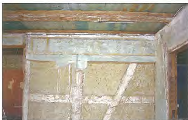
Abb. 12 Greifswald, Joh.- S.- Bach- Str. 20, OG, Raum 4, Zwischenwand, Ansicht nach Süd. Zustand während der Konservierungsarbeiten Foto: C. Kohl
