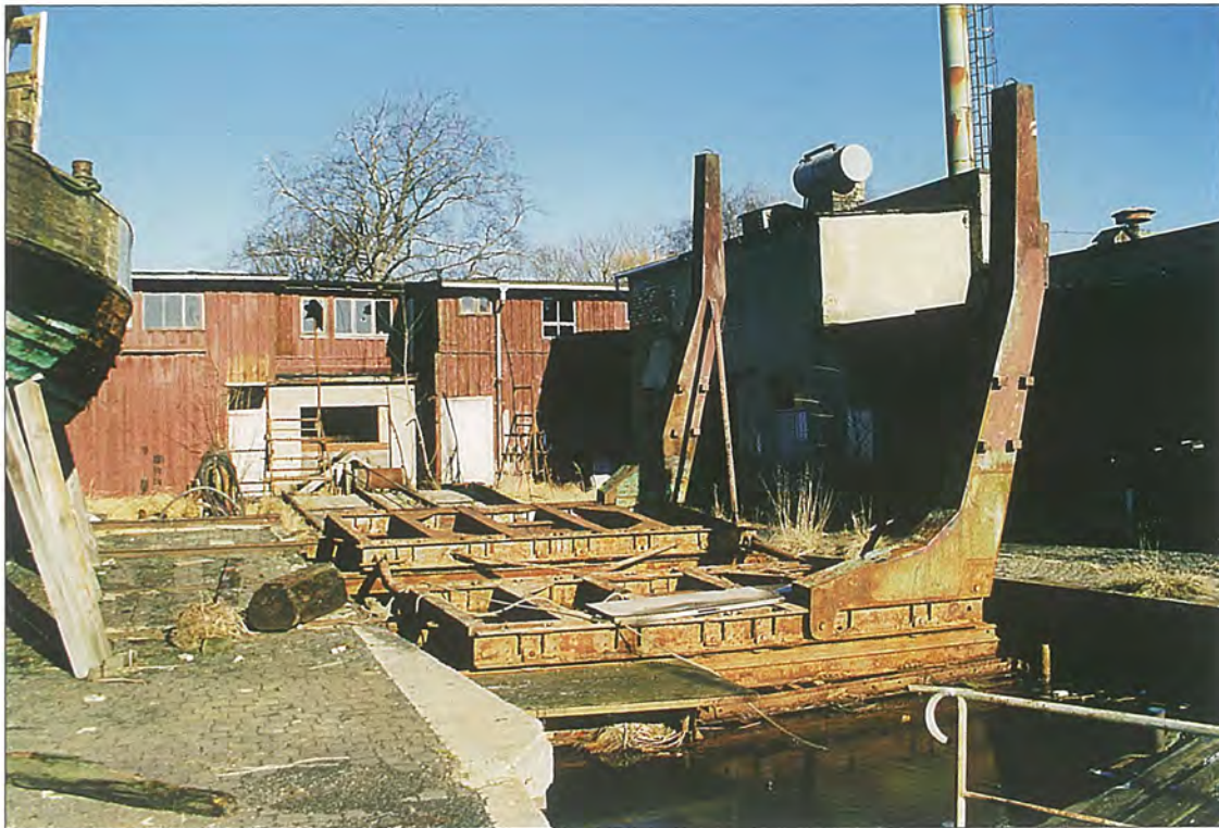
Abb. 4 Die Slipanlage der Werft, Zustand ca. 1996. Die heute noch vorhandene technische Ausrüstung wurde bei der Rekonstruktion der alten Patentslip in den Jahren 1961/62 eingebaut: hydraulisch angetriebene Slipwinde, Slipwagen (Tragfähigkeit 170 t), Queraussetzvorrichtung. Auch nach 1990 – bis zum Defekt der hydraulischen Steuerung der Slipwinde 1997 – sind dort Schiffe aufgeslipt worden, so der Schoner „Vorpommern“, der Besanwerer „Alfred“ und der Kutter „Vorwärts“. Im Hintergrund das noch unter Buchholz errichtete Gebäude der alten Tischlerei/Taklerei mit dem Windenraum in der Mitte. Am linken Bildrand aufgepalmt der 14,5-m-Kutter „Vorwärts“ (gebaut 1938 in Swinemünde). Am 5. November 2003 erfolgte unter Medienpräsenz die offizielle Wiederinbetriebnahme der reparierten Slipanlage, bereits einige Wochen zuvor hatte die restaurierte Technik mit dem Aufslipen des Kutters „Vorwärts“ den „inoffiziellen“ Testlauf bestanden. Foto: Jörg Scheffelke
