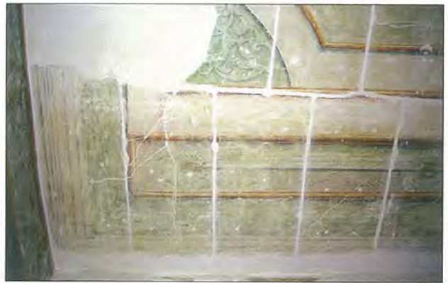
Abb. 15 Greifswald, Joh.- S.- Bach- Str. 20, OG, Raum 4, Zustand der wieder eingebauten Decke nach der Kittung der Fehlstellen, Foto: C. Kohl, 1997
