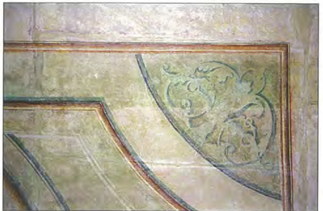
Abb. 16 Greifswald, Joh.- S.- Bach- Str. 20, OG, Raum 4, Detailaufnahme eines Deckenfeldes nach der Fertigstellung, einschließlich der Retusche. Foto: C. Kohl, 1997
