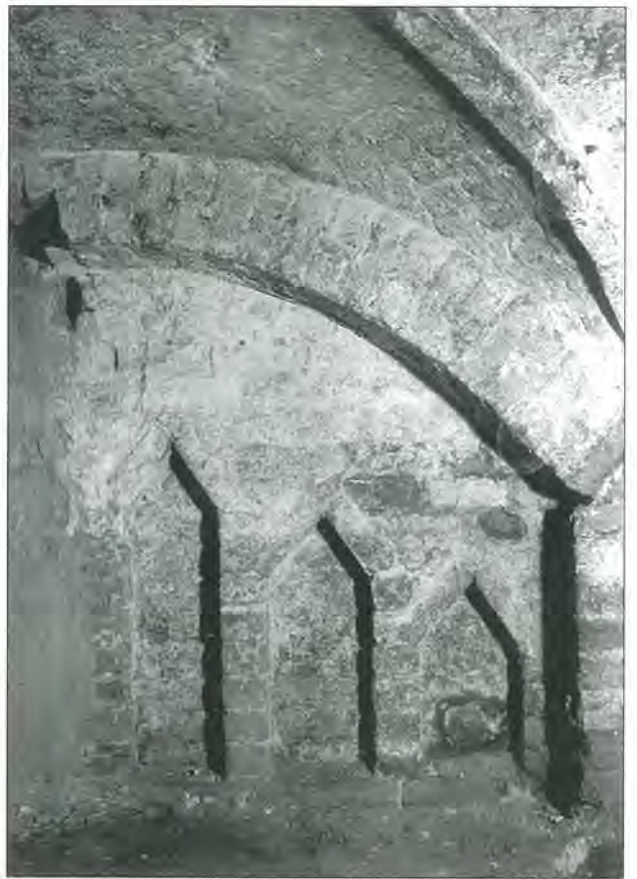
Abb. 12 Greifswald, Lange Straße 51, ehemalige Kirche des Heilig-Geist-Hospitals. Eingetiefter und kreuzbandrippengewölbter Raum im nordöstlichen Joch mit einer dem ansteigenden Schildbogenlauf folgenden Blendenreihung (hier innerhalb der westlichen Schildwand). Foto: T. Rütz
