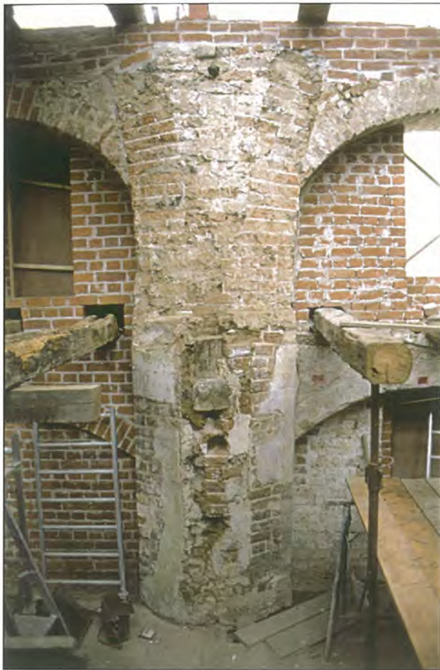
Abb. 8 Greifswald, Lange Straße 51. Der östliche Freipfeiler während der Sanierung. Oberhalb des polygonalen Pfeilers sind die unteren Partien der schiffstrennenden Scheidbögen erkennbar. Foto: T. Rütz
