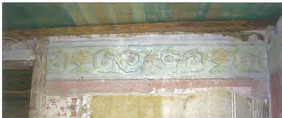
Abb. 11 Greifswald, Joh.- S.- Bach- Str. 20, OG, Raum 5, Zwischenwand, Ansicht nach Nord. Zustand während der Konservierungsarbeiten Foto: C. Kohl
