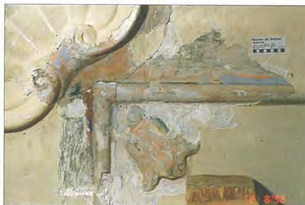
Abb. 6 Greifswald, Joh.- S.- Bach- Str. 20, EG, Raum 3, Decke. Befundsituation mit mehreren übereinanderliegenden Fassungen Foto: H.- H. Bär, 1996
