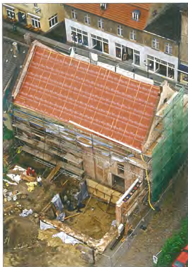
Abb. 13 Greifswald, Blick vom Turm der Nikolaikirche auf die Lange Straße 51 (2002). Erkennbar ist das freigelegte Südwandfundament der mittelalterlichen Backsteinhalle. Auf diesem Fundament wurde der 2002 neu errichtete Seitenflügel gegründet. Foto: T. Rütz
