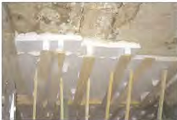
Abb. 10 Greifswald, Joh.-S.-Bach-Str. 20, Bergung des Malputzes der Decke im nördlichen Raum im OG. Foto: C. Kohl
