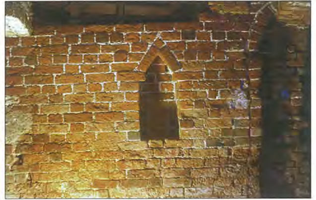
Abb. 14 Greifswald, Markt 13, Kellergeschoss. Mauernische in der im hinteren Kellerbereich gelegenen Quermauer von ca. 1290/1295. Foto: A. Lutze
