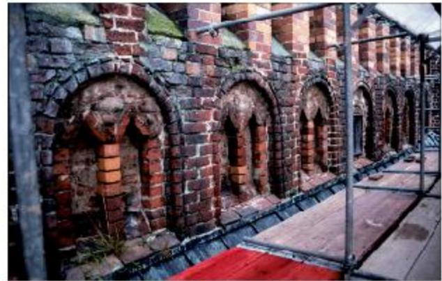
**Abb. 9** Greifswald, St. Nikolai, mittlerer Turmabschnitt, Südseite. Die rundbogig geschlossenen Blenden der unteren Zone zeigen an den Kanten eine Stabprofilierung, innerhalb der Blendrückflächen sind schmale und mit Winkelsturz schließende Blendpaare ausgeführt. Die Gesamtgestaltung erinnert an Biforienfolgen romanischer Kirchen- und Burgenbauten. Foto: A. Lutze (2001)
