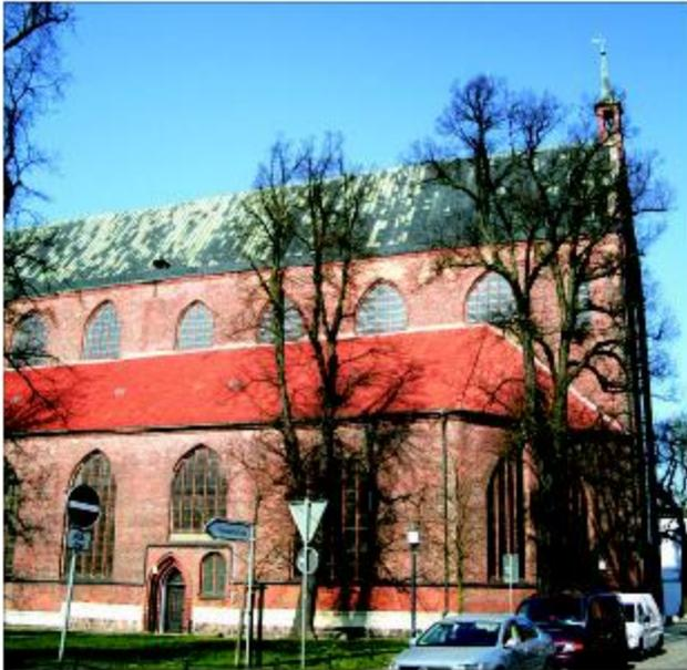
**Abb. 6** Greifswald, St. Nikolai. Nach einer Planänderung entstand um 1385/90 der heutige Chorbau mit basilikalem Aufriss, der dreischiffige Grundriss wurde vom älteren Hallenlanghaus übernommen. Foto: D. Brandt (2007)
