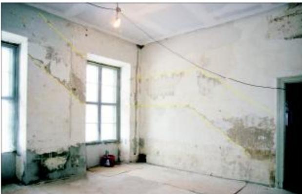
**Abb. 11** Greifswald, Domstraße 11, Blick nach Nordosten in das ehemalige Haupttreppenhaus im ersten Obergeschoss. Während der Sanierungsarbeiten war der Abdruck der Treppenkonstruktion erkennbar (gelb markiert). Foto: T. Rütz (2005)
