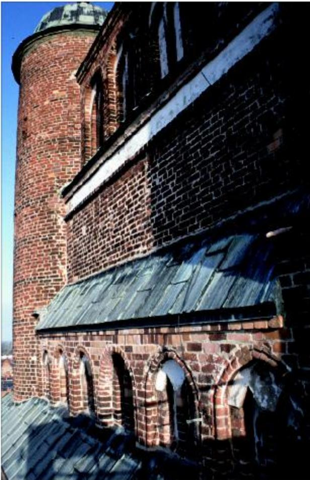
**Abb. 8** Greifswald, St. Nikolai, mittlerer Turmabschnitt, Westseite, von Südwesten. Der gestufte dreizonige Aufbau des mittleren Turmabschnittes ist nach der Mitte des 15. Jahrhunderts entstanden. Innerhalb der runden Ecktürme führen massive Treppenaufgänge vom Turminnenen zu einem hinter der letzten Zone angelegten Umgang, der um den zunächst auf rechteckigem Grundriss begonnenen dritten Turmabschnitt führte. Foto: A. Lutze (2001)
