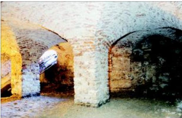
**Abb. 7** Greifswald, Domstraße 11, Blick in den östlichen Kellerbereich während der Sanierung. Das Kellergeschoss des barocken Kollegiengebäudes ist mit Ausnahme des nicht unterkellerten Mittelteils vollständig gewölbt. Die Bereiche unter dem ehemaligen Archiv auf der Ostseite und unterhalb der kleinen Hörsäle im Westen wurden mit Kreuzgratgewölben ausgestattet. Foto: T. Rütz (2004)
