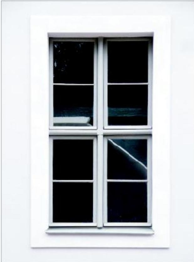
**Abb. 9** Greifswald, Domstraße 11. Im Erdgeschoss des Ostgiebels sind zwei ursprüngliche Fensterkonstruktionen des 18. Jahrhunderts erhalten geblieben. Die Fensterflügel waren ursprünglich kleinteiliger gesprosst (mit sechs Glastafeln je Fensterflügel) und wurden in den 1830er Jahren in ihre heutige Form umgebaut. Foto: T. Rütz (2006)
