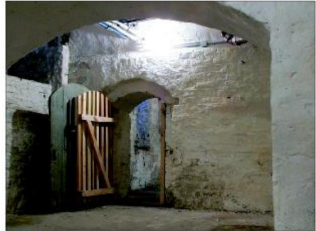
**Abb. 17** Greifswald, Domstraße 22, Seitensflügelkeller. Die Laibung der Tür zum südlichen der drei unter dem Seitenflügel vorhandenen gewölbten Kellerräume ist einfach gestuft. Foto: D. Brandt (2005)
