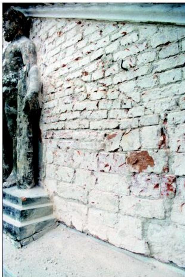
**Abb. 6** Greifswald, Domstraße 11, Nordfassade nach Südosten. Neben den „Wilden Männern“ aus Kalkstuck war im Giebeldreieck eine ältere Ausmauerung erkennbar. Hier waren bis in die 1830er Jahre die Halterfiguren für den schwedischen Wappenschild eingemauert. Foto: T. Rütz (2004)
