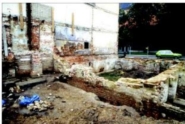
**Abb. 14** Greifswald, Domstraße 22/23, Überblick über die im Jahre 1995 freigelegten Mauerwerksbefunde des Kellergeschosses von Domstraße 23, von Südosten. Oben links ist die gemeinsame und im Spätmittelalter (15. Jahrhundert) verlängerte bzw. ab dem Erdgeschoss erneuerte Brandmauer zum Nachbargrundstück Domstraße 22 (links mit zwei zeitgleich auf dem Grundstück Nr. 23 fundamentierten Stützpfählern) zu erkennen. Foto: A. Lutze (1995)
