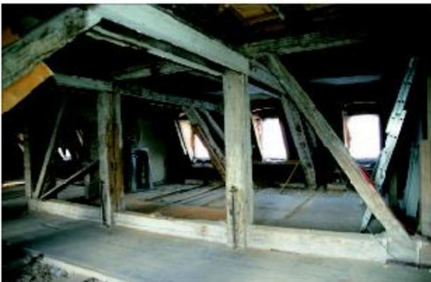
**Abb. 19** Greifswald, Domstraße 11. Oberhalb der kleinen Hörsäle ist ebenfalls ein Hängewerk zur Entlastung der Deckenbalken eingebaut. Hier war auch einer der beiden im Dachgeschoss befindlichen Karzer untergebracht. Foto: T. Rütz (2005)
