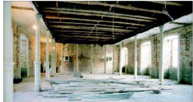
**Abb. 15** Greifswald, Domstraße 11. Der ehemalige große Hörsaal unterhalb der heutigen Aula erhielt in den 1880er Jahren eiserne Unterzüge, die durch eine umlaufende Reihe gusseiserner Säulen getragen werden. Während der Umgestaltung war ein Blick in die barocke Deckenkonstruktion möglich. Blick nach Osten. Foto: T. Rütz (2005)
