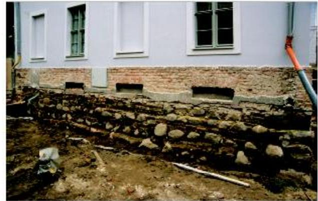
**Abb. 3** Greifswald, Domstraße 11, Blick auf den Westgiebel. Die Baufuge zwischen dem renaissancezeitlichen Kellermauerwerk und dem barocken Neubau (Fuge gelb) war nur schwer zu erkennen, da in beiden Bauphasen Abbruchmaterial wiederverwendet wurde. Foto: T. Rütz (2005)
