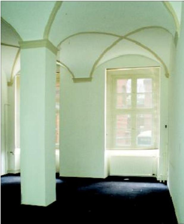
**Abb. 10** Greifswald, Domstraße 11. Oberhalb des Kellers sind nur die barocken Archivräume mit einem massiven Gewölbe ausgestattet. Blick nach Süden. Foto: T. Rütz (2004)
