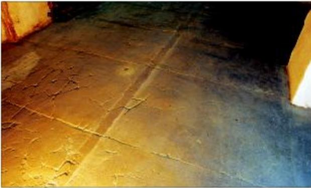
**Abb. 18** Greifswald, Domstraße 11. Im Instrumentensaal blieben Teile des ursprünglichen Fußbodens erhalten. Er besteht aus einem 2 cm dicken Gipsestrich mit darunter liegendem Mörtelbett, welches direkt auf eine Holzschalung aufgebracht wurde. Da der Gips schnell aushärtete, wurde er in 0,9 - 1,1 m breiten Abschnitten eingebracht, die erkennbar geblieben sind. Foto: T. Rütz (2004)
