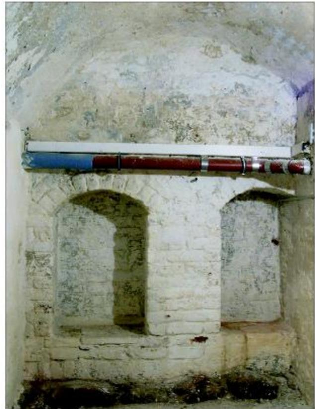
**Abb. 18** Greifswald, Domstraße 22, Seitensflügelkeller. Im nördlichen, wie auch in den beiden anderen Kellern existieren senkrecht zum First des Seitenflügels orientierte Tonnengewölbe, die vermutlich schon im Mittelalter entstanden. Foto: D. Brandt (2005)
