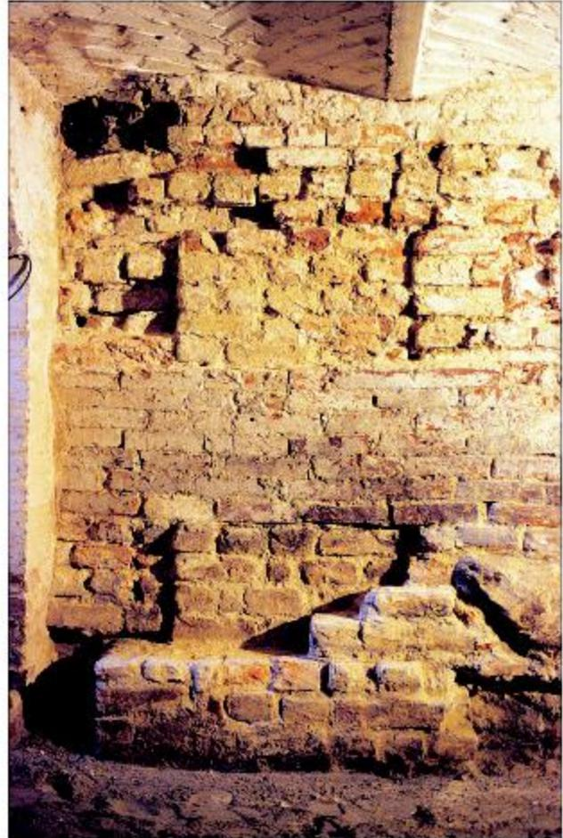
**Abb. 5** Greifswald, Domstraße 11. Im östlichen Teil des heutigen Kellers blieb der Rest eines Pfeilers des Ernestinums erhalten. Er bildete die Fundamentierung für eine der drei Stützen des großen Hörsaals im Erdgeschoss. Blick nach Westen. Foto: T. Rütz (2004)
