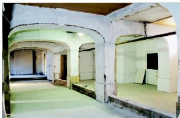
**Abb. 17** Greifswald, Domstraße 11. Im Dachgeschoss befand sich direkt über der ehemaligen Bibliothek ein Raum, in dem physikalische Instrumente aufbewahrt und präsentiert wurden (so genannter Instrumentensaal). Hinter der korbogigen Verkleidung liegt eine Hängewerkkonstruktion zur mittigen Befestigung der ehemaligen Bibliotheksdecke. Dieser Raum war nur während der Baumaßnahme in seiner ursprünglichen Größe wahrnehmbar. Blick nach Osten. Foto: T. Rütz (2004)
