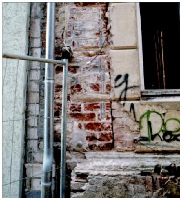
**Abb. 15** Greifswald, Domstraße 22, Fassade. Bei Putzarbeiten wurde auf der Ostseite ein schmaler Streifen der mittelalterlichen Giebelmauer aufgedeckt. Die hier vorhandene, aus kleinteilig profilierten Formsteinen gemauerte Laibung gehörte wahrscheinlich zu einer Portal- oder Fensteröffnung. Foto: A. Lutze (1998)
