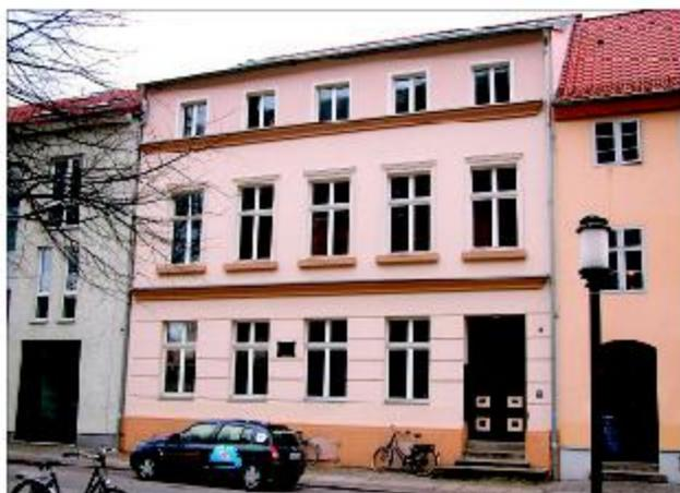
**Abb. 13** Greifswald, Domstraße 22. Die gegenwärtige Fassadengliederung geht im Wesentlichen auf einen Umbau von 1842 zurück, bei dem aus dem Giebel- ein breitgelagertes Traufenhaus wurde. Foto: D. Brandt (2005)
