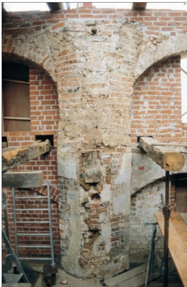
**Abb. 6** Östlicher Freipfeiler der mittelalterlichen Backsteinhalle mit den steil ansetzenden unteren Partien der schiffstrennenden Scheidbögen
