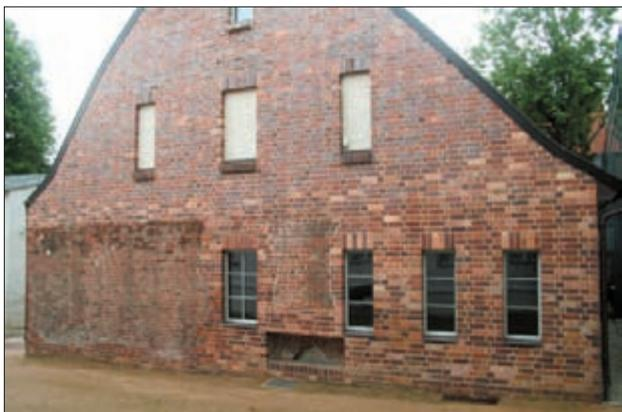
**Abb. 8** Nordmauer des „Konventshaus“ mit Resten der mittelalterlichen Chorsüdmauer einschließlich eines ursprünglichen Zuganges
