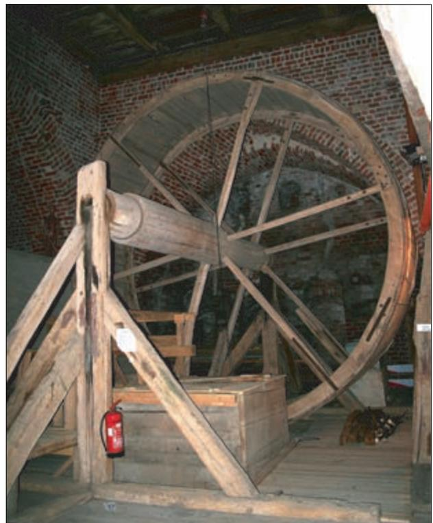
**Abb. 3** Laufrad eines Baulastenaufzuges im Turmmittelgeschoss aus der zweiten Hälfte des 15. Jahrhunderts
