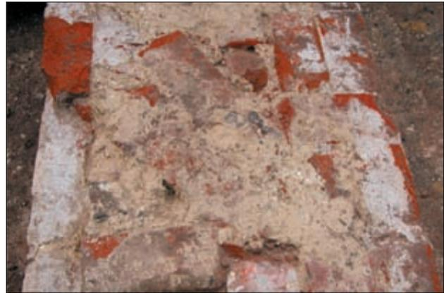
**Abb. 6** Steinbeckerstraße 1, Rest einer Rückfassade der Zeit um 1300, Aufsicht mit deutlicher Unterscheidung von Kern- und Schalenmörtel
