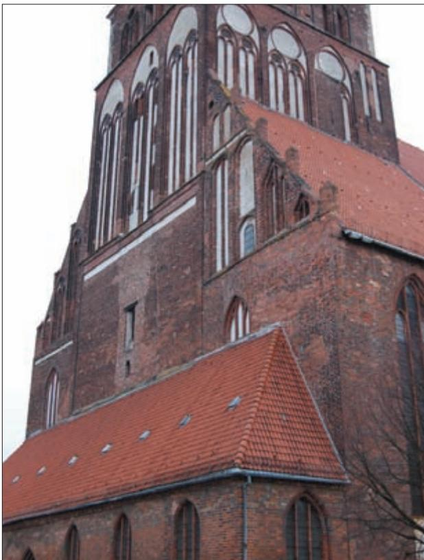
**Abb. 5** St. Marien: Der zwischen 1280 und 1480 errichtete Bau besteht fast vollständig aus rotem Backstein. Erst im Traufbereich der um 1450 angefügten Westvorhalle kamen gelbliche Steine zum Einsatz.
