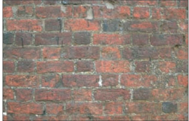
**Abb. 7** Äußere Mauerschale des „Fangenturms“ (um 1270/1280): Der für die Bauzeit sonst untypische Wechselverband ist grundrissbedingt.
