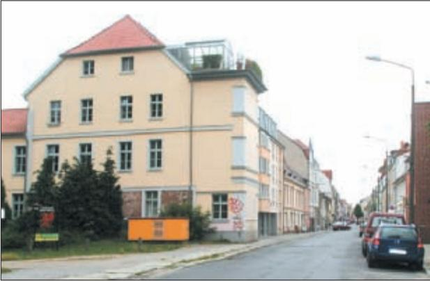
**Abb. 5** Westfassade des Gebäudes Lange Straße 2: Im Erdgeschoss ist die ehemalige Feldseite der mittelalterlichen Stadtmauer zu erkennen.
