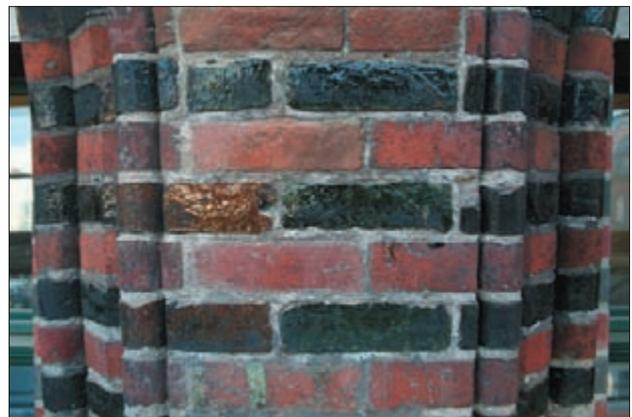
Abb. 3 Vorderfassade: Die unterschiedlichen Glasurfarben lockern das Verbandsbild der backsteinsichtigen Fassade zusätzlich auf.
