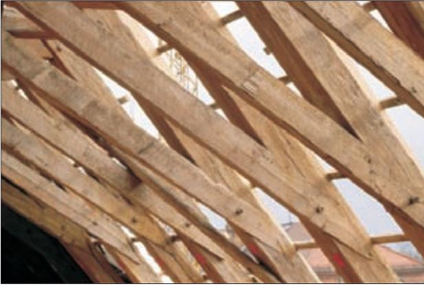
**Abb. 5** Schwalbenschwanzförmige Anblattungen der Kreuzstreben an die Sparren des mittelalterlichen Langhausdachwerkes
