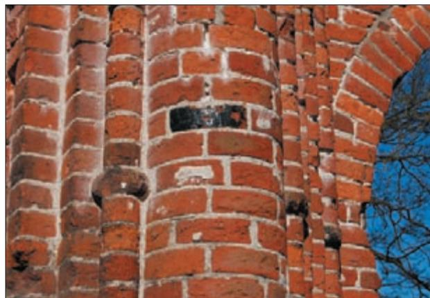
**Abb. 8** Klostersruine Eldena, Kirchenostteile, nordwestlicher Vierungspfeiler der Zeit um 1240 mit einem einzelnen, dunkelgrün glasierten Backstein, einem der ältesten Glasurnachweise in der Klosteranlage
