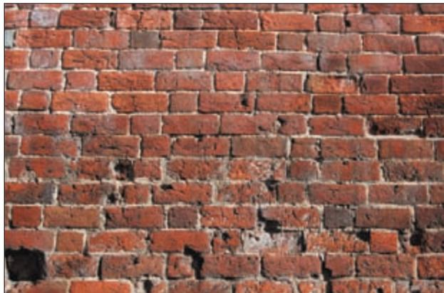
**Abb. 4** Klostruine Eldena, im Wendischen Verband gemauerte südliche Schale der Chorsüdmauer aus der Zeit um 1210/1215
