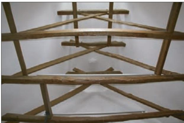
**Abb. 3** Sanierte Gebinde der spätmittelalterlichen Dachkonstruktion über dem heutigen Treppenhaus im westlichen Gebäudeteil
