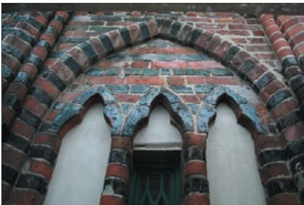
Abb. 1 Vorderfassade, Dreiergruppe im ersten Dachgeschoss mit Maßwerkabschlüssen aus glasierten Formsteinen
