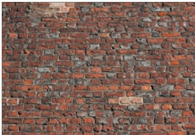
**Abb. 7** St. Marien, südliche Turmseitenkapellen, Teilbereich der um 1400 mit zahlreichen tiefroten bzw. sogar überfeuerten Backsteinen ausgeführten äußeren Mauerschale der südlichen Umfassungsmauer
