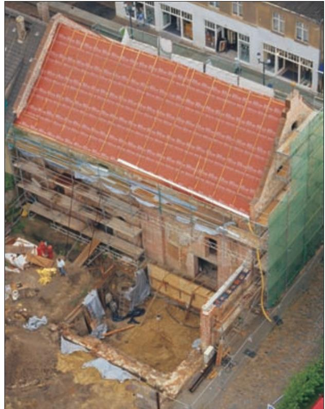
**Abb. 2** Grundstück Lange Straße 51 mit dem freigelegten Fundament der Südmauer der mittelalterlichen Backsteinhalle
