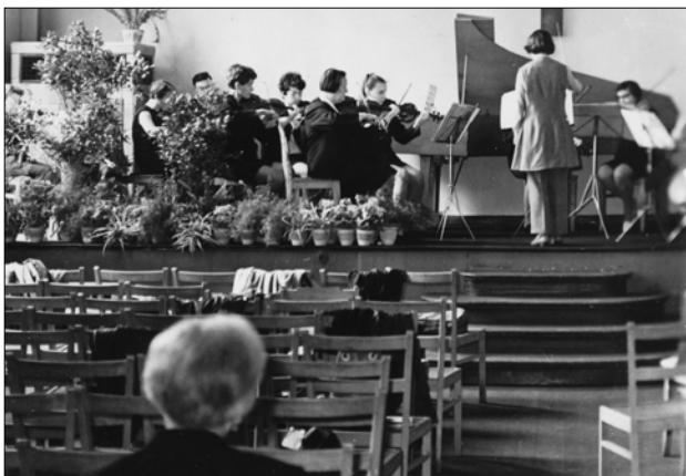
Abb. 16 Greifswald, Lutherhof. Saal von innen. Probe auf der Bühne mit Saskia Pflugbeil. Die Bühne befand sich genau über einer ursprünglich angelegten Teilunterkellerung im östlichen Bereich des Saals. Sie entstand vermutlich ebenfalls zur Errichtungszeit 1900/1901. Blick nach Osten. Foto: A. Gramatzki (vor Juni 1974), Privatsammlung A. Pflugbeil
