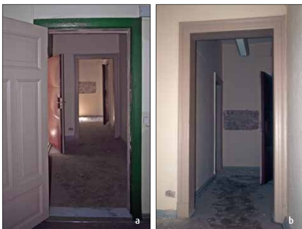
Abb. 15 Greifswald, Baderstraße 24. Erdgeschoss im südlichen Teil des ehemaligen Polizeigefängnisses (vgl. Abb. 10). Blick nach Süden auf den Eingang und in den Flur der ehemaligen Wohnung (a) sowie auf den Zugang in den ursprünglich großen südwestlichen Raum (b). Die vordere Tür ist nachträglich umgebaut worden. Fotos: D. Brandt (2017)
