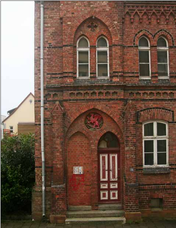
Abb. 9 Greifswald, Baderstraße 24. Vorderfassade des ehemaligen Polizeigefängnisses. Durch das einstige Doppelportal im Mittelrisalit wurden die beiden baulich und funktional getrennten Gebäudehälften separat erschlossen. Der Nordteil des Hauses ist Anfang der 1960er Jahre abgebrochen worden. Blick nach Osten. Foto: D. Brandt (2017)
