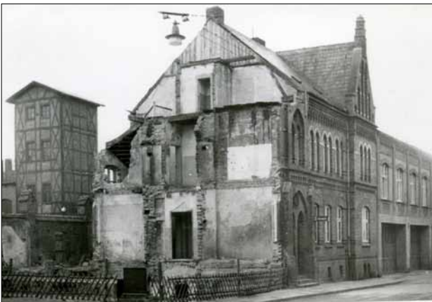
Abb. 25 Greifswald, Baderstraße 24. Blick nach Südosten auf den Rest des ehemaligen Polizeigefängnisses nach dem Abbruch des nördlichen Gebäudeteils Anfang der 1960er Jahre. Foto: A. Krabbe
