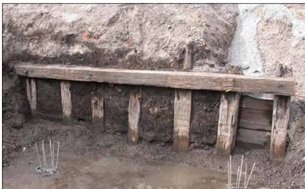
Abb. 15 Stralsund, Parkhaus Fährwall. Uferbefestigung eines ehemaligen Hafenbeckens. Die Konstruktion aus Pfählen und landseitig angeschlagenen Bohlen datierte in die Zeit um 1747/1748. Blick nach Nordwesten auf die einstige Wasserseite. Foto: J. Ansorge (2010)
