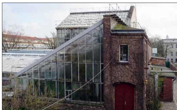
Abb. 24 Greifswald, Münterstraße 2. Nordwestlicher Bereich des ab 1884 errichteten Gewächshauskomplexes. Das Bild zeigt rechts den schmalen rückwärtigen Backsteinbau, in dem die Heizanlage sowie Geräteräume und zeitweise auch eine Dienstwohnung für den Heizer untergebracht waren. Blick nach Südosten. Foto: T. Weiß (2017)
