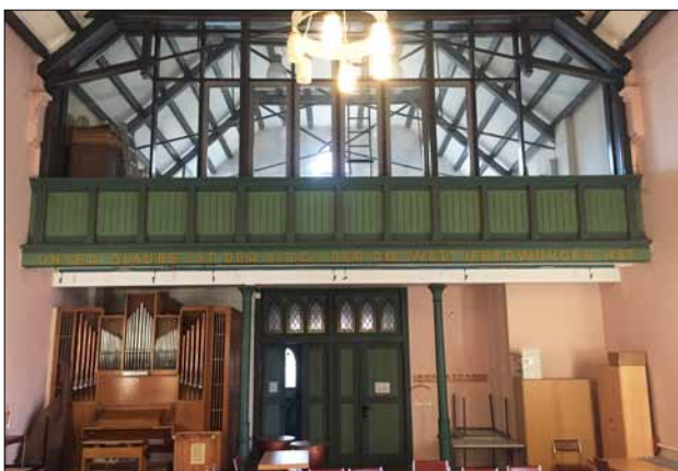
Abb. 10 Greifswald, Lutherhof. Saal von innen. Im westlichen Bereich des Gebäudes ist auf einer Empore ein kleinerer Raum für separate Veranstaltungen eingerichtet. Durch eine bewegliche hölzerne Wand konnte er ursprünglich zum Saal hin geöffnet werden. Blick nach Westen. Foto: R. Neumann (2016)
