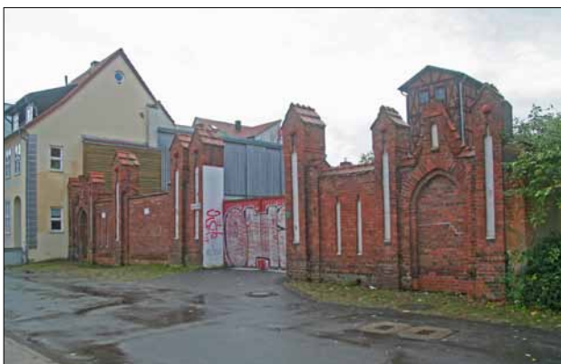
Abb. 30 Greifswald, Baderstraße/Domstraße. Nördliche Hofmauer der ehemaligen Feuerwehr und des Polizeigefängnisses. Hier die Seite zur Domstraße mit den Details der neogotischen Architekturgestaltung. Blick nach Südosten. Foto: D. Brandt (2017)
