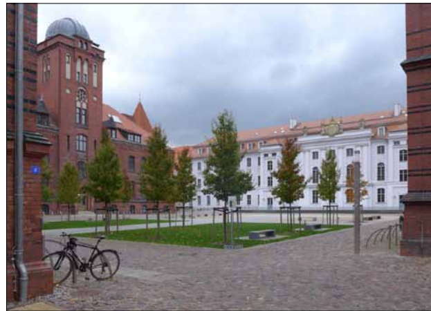
Abb. 2 Greifswald, Domstraße 11. Innenhof hinter dem barocken Kollegiengebäude nach der letzten Umgestaltung in den Jahren 2004/2005. Blick nach Nordwesten. Foto: T. Rütz (2013)
