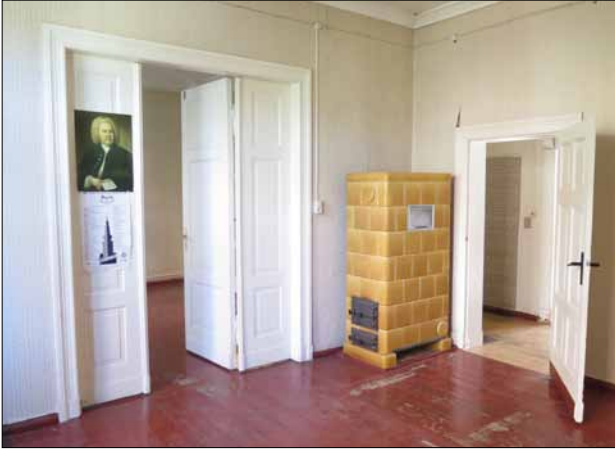
Abb. 21 Greifswald, Lutherhof. Südwestlicher Raum im rechten Obergeschoss des Wohngebäudes (ursprünglich Wohnzimmer, vgl. Abb. 15). Nördliche (links) und östliche Binnenwand mit den bauzeitlichen Türen zum Nachbarraum (links, ursprünglich Salon, vgl. Abb. 22) sowie in den Flur. Blick nach Nordosten. Foto: R. Neumann (2016)
