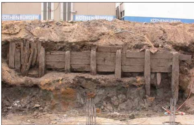
Abb. 16 Stralsund, Ozeaneum. Hafenbollwerk aus eingerammten Pfählen und landseitig angeschlagenen Bohlen. Die Uferbefestigung wurde laut Holzaltersbestimmung in den Jahren um 1772 errichtet. Blick nach Westen. Foto: J. Ansorge (2006)
