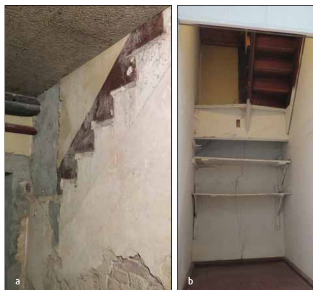
Abb. 25 Greifswald, Lutherhof. Rechte Seite des Wohngebäudes. Treppenabdruck im Kellergeschoss (a) und Rest einer Treppe im Obergeschoss (b). Beide Befunde veranschaulichen die Enge dieser Treppenanlagen, die einen nur wenig komfortablen Auf- und Abstieg ermöglichten. Blick nach Südwesten (a) und Süden (b). Fotos: R. Neumann (2016)
