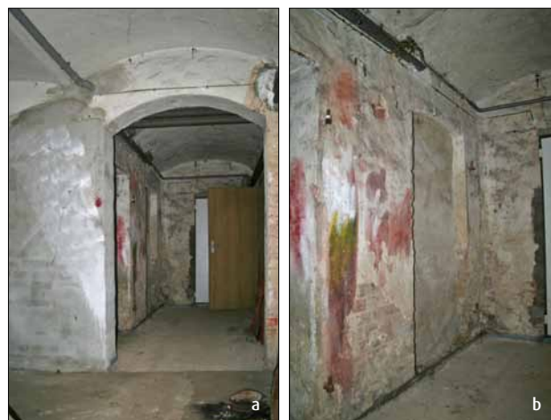
Abb. 16 Greifswald, Baderstraße 24. Kellergeschoss im südlichen Teil des ehemaligen Polizeigefängnisses (vgl. Abb. 17). Blick nach Süden von der Treppe in den Mittelgang (a) sowie nach Südosten auf den womöglich 1937/1938 zugesetzten Durchgang in die südöstlichen Kellerräume (b). Diese gehörten danach zur Feuerwache. Fotos: D. Brandt (2017)
