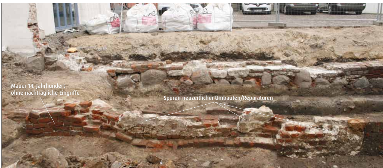
Abb. 10 Greifswald, Domstraße 43/44. Rest einer ost-west-ausgerichteten Mauer des 14. Jahrhunderts im Nordwesten der Grabungsfläche (Vordergrund, vgl. Abb. 4 und 5). Jüngere Veränderungen stehen womöglich im Zusammenhang mit der Errichtung der Ratsdienerbuden südlich des Zeughauses. Zeughaus und Budenzeile wurden vermutlich zeitgleich in den 1580er Jahren errichtet. In diesem Zeitraum könnte auch ein etwas nördlich parallel verlaufender Mauerzug entstanden sein (Bildmitte). Dieser setzte die Südfucht des Zeughauses (oben links) nach Osten fort. Blick nach Norden. Foto: P. Kaute (2016)
