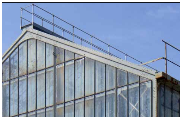
Abb. 27 Greifswald, Münsterstraße 2. Ostgiebel des zentralen Palmenhauses. Gut erkennbar sind die Nietungen der aus Puddelstahl hergestellten Konstruktion. Der Laufsteg auf dem Dachfirst gehört noch zum Bestand des 19. Jahrhunderts. Blick nach Südwesten. Foto: T. Rütz (2013)
