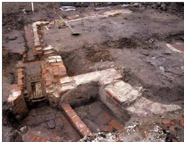
Abb. 12 Greifswald, Domstraße 11. Nördlicher Bereich des Kalthauses aus den 1820er Jahren (vgl. Abb. 10). Hinter Eisenrost und Aschefall ist der Heizkanal entlang der ehemaligen Außenwände erkennbar. Der Ofen wurde mindestens einmal erneuert und stammt in der freigelegten Form wohl erst aus der Mitte des 19. Jahrhunderts. Rechts die Fundamente einer der Wandnischen. Blick nach Osten. Foto: T. Rütz (2005)
