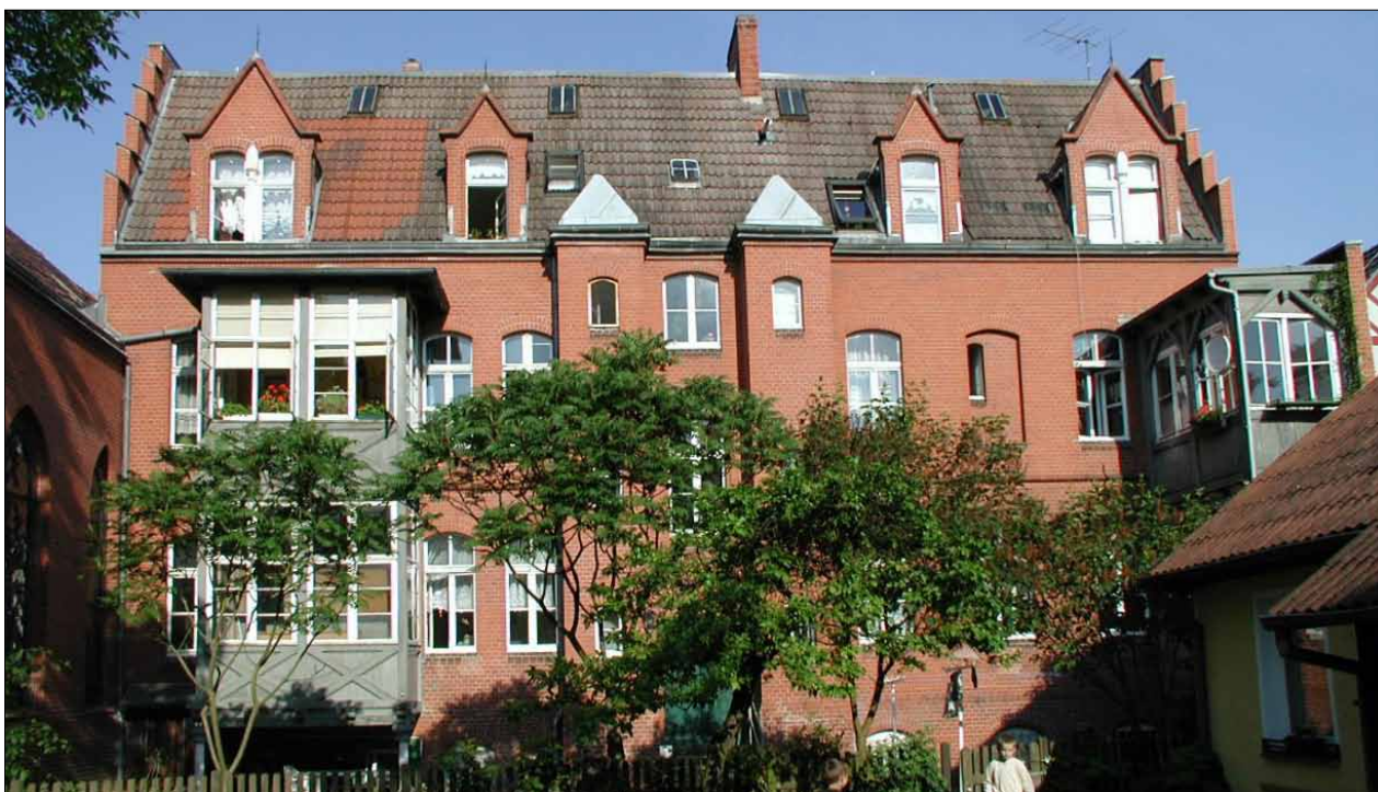
Abb. 24 Greifswald, Lutherhof. Rückfassade des Wohngebäudes. Die beiden Toilettenanbauten zuseiten der Mittelachse sind von den Zwischenpodesten des Treppenhauses und vom Kellergeschoss aus zugänglich. Die zweigeschossige Veranda in der Nordachse (rechts) gehört zum Bau von 1900/1901, der Standerker im südlichen Fassadenbereich (links) wurde wohl nachträglich errichtet. Blick nach Westen. Foto: R. Neumann (2002)
