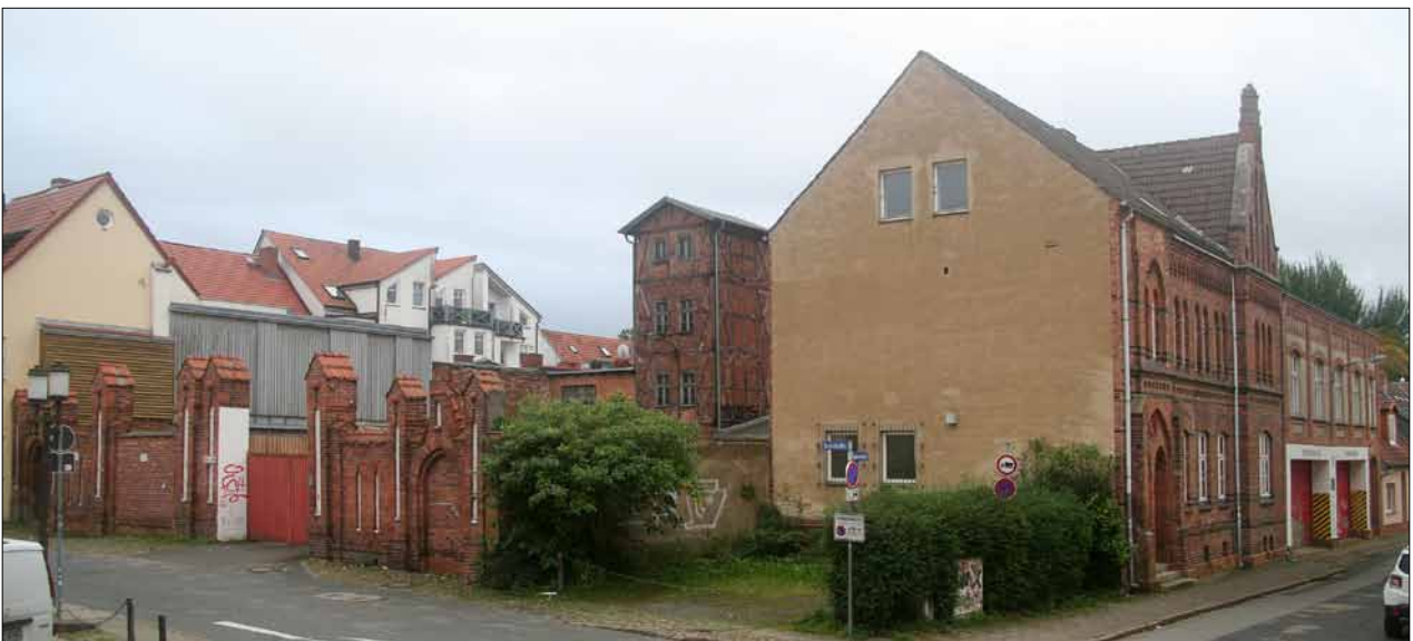
Abb. 1 Greifswald, Baderstraße 24. Heutige Bebauung an der südöstlichen Ecke Baderstraße/Domstraße. Das Gebäude des ehemaligen Polizeigefängnisses (rechts der Bildmitte) reichte ursprünglich bis an die Domstraße heran, der Nordteil wurde jedoch Anfang der 1960er Jahre abgebrochen. Blick nach Südosten. Foto: D. Brandt (2017)
