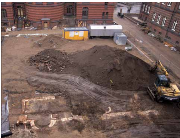
Abb. 10 Greifswald, Domstraße 11. Blick nach Osten auf freigelegte Mauerwerksbefunde des Kalthauses aus den 1820er Jahren. Die ehemals aufgehenden Umfassungsmauern wurden zur Steingewinnung ausgebrochen. Im Boden blieben Reste einer Binnenmauer mit großen Rundnischen und Teile einer Heizanlage erhalten. Nachgewiesen sind außerdem kleine Wasserbecken und ein Brunnen (vgl. Abb. 5). Foto: T. Rütz (2005)
