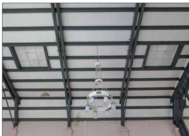
Abb. 13 Greifswald, Lutherhof. Saal von innen. Im Deckenbereich sind die quadratischen Öffnungen zweier ursprünglicher Lichtschächte zu erkennen. Ihre Funktion wurde bei der Sanierung 2016/2017 wiederhergestellt. Die holzverkleideten Schächte führen schräg durch den Dachraum zur südlichen Dachfläche. Blick nach Süden. Foto: R. Neumann (2016)
