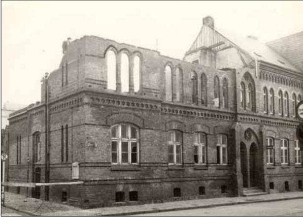
Abb. 24 Greifswald, Baderstraße 24. Blick nach Südosten auf das ehemalige Polizeigefängnis nach dem Teilabbruch 1959. Foto: A. Krabbe
