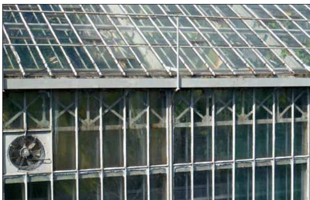
Abb. 25 Greifswald, Münsterstraße 2. Blick nach Nordosten auf die Südseite des zentralen Palmenhauses. Unter der Traufe sind die aussteifenden Andreaskreuze zu erkennen, darüber das in den 1980er Jahren erneuerte Geländer eines Laufstegs. Foto: T. Weiß (2013)
