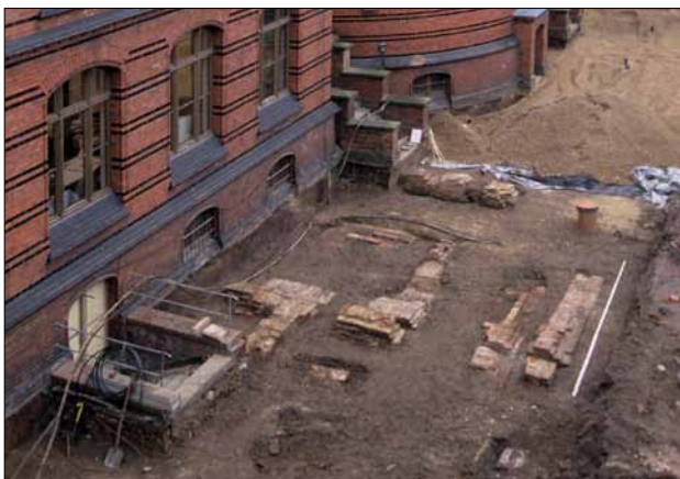
Abb. 11 Greifswald, Domstraße 11. Nordöstlicher Bereich der Grabungsfläche. Freigelegte Mauerwerksbefunde des hohen Warmhauses aus den 1820er Jahren (vgl. Abb. 5). Links im Bild das neue Auditorium maximum von 1886. Blick nach Südosten. Foto: T. Rütz (2004)
