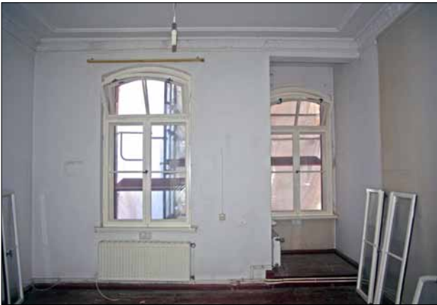
Abb. 22 Greifswald, Lutherhof. Nordwestlicher Raum im rechten Obergeschoss des Wohngebäudes (ursprünglich Salon, vgl. Abb. 15). Straßenseite mit dem Raumvorsprung in der südlichen Achse des Erkers. Stuckelemente, Fenster und Fußböden sind wahrscheinlich noch ursprünglich. Blick nach Westen. Foto: D. Brandt (2017)
