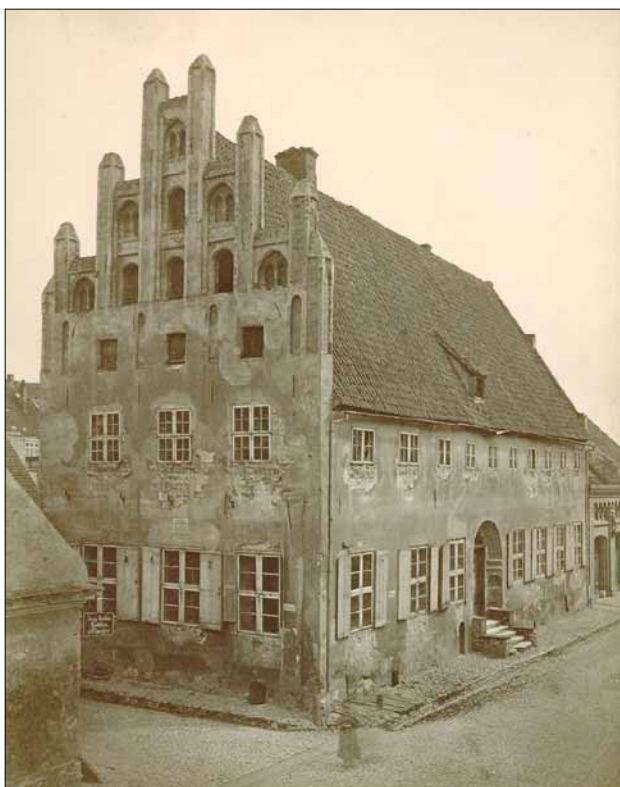
Abb. 2 Greifswald, Baderstraße 24. Ehemaliges „Syndikatsgebäude“ an der Südostecke Baderstraße/Domstraße. Das ältere Spritzenhaus im südlichen Anschluss steht bereits, die Aufnahme entstand demnach zwischen 1876 und 1879. Zu dieser Zeit befanden sich zumindest die Fassaden in einem stark renovierungsbedürftigen Zustand. Blick nach Südosten. Foto: StAG AIC 894
