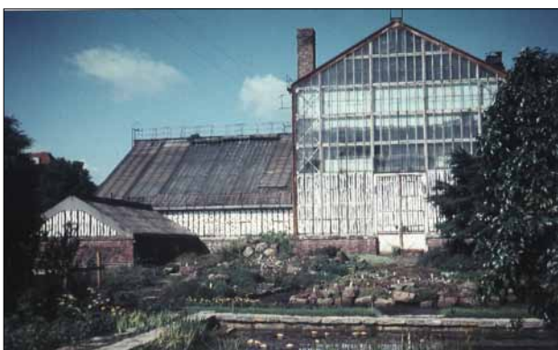
Abb. 23 Greifswald, Münterstraße 2. Zustand der Gewächshäuser während der 1950er Jahre. Zum Schutz vor übermäßiger Sonneneinstrahlung wurde die Verglasung der Wände in den Sommermonaten mit einer hellen Schattierfarbe bestrichen. Blick nach Südwesten. Foto: H. Borris, Universität Greifswald / Botanischer Garten / Bild-Archiv
