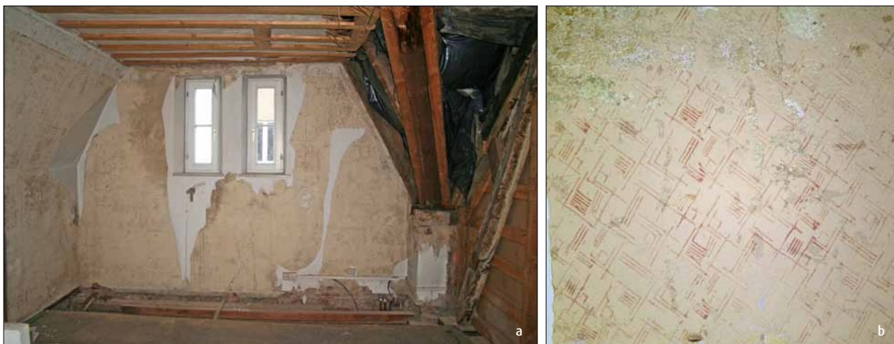
Abb. 19 Greifswald, Baderstraße 24. Blick nach Westen auf die straßenseitige Wand der 1905 in der südwestlichen Ecke des Dachgeschosses, hinter dem südlichen Seitenrisalit eingerichteten Bodenkammer (a, vgl. Abb. 18) und Detail der zeitlich vermutlich zugehörigen Wandgestaltung (hier die südliche Wandschräge, b). Der Raum entstand im Zusammenhang mit dem Umbau der Obergeschosswohnung (vgl. Abb. 13). Fotos: D. Brandt (2017)
