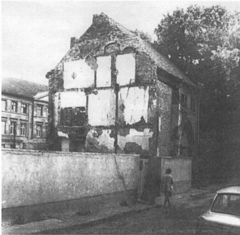
Bild 165 4/1 - Blick nach Südosten in der Rakower Straße (Zustand bis 1982)
