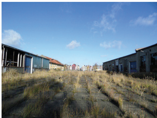
Zwischen Gebäude 1 und 2
