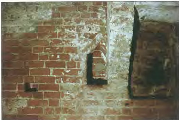
Abb. 29 Hansestadt Greifswald, Markt 14, Kellergeschoss. Die rund 21 m lange nördliche Brandmauer zeigte neben Nischengestaltungen mit dreiecksförmigen Abschlüssen (siehe auch Abb. 23-25 zu Schuhhagen 24) das typische Steinformat und die charakteristische Gründungstechnik der 1270er Jahre. Eine Besonderheit bildete die ursprüngliche Vorbereitung einer massiven (jedoch erst Anfang des 14. Jahrhunderts ausgeführten) Kellerunterteilung für den hinteren Gebäudebereich. Im Bildausschnitt rechts ist neben dem abgearbeiteten Balkenauflegebereich auch der drei Stein breite Maueranschluss für die ursprünglich vorgesehene Rückfassade erkennbar. Foto: A. Lutze
