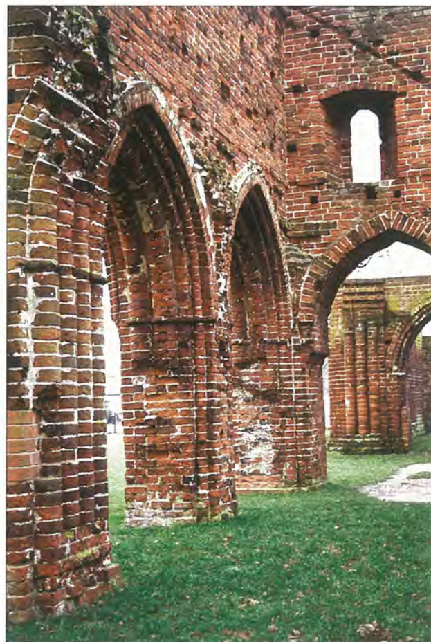
Abb. 11 Hansestadt Greifswald, Klostruine Eldena, ehemalige Klosterkirche. Der Bildausschnitt links zeigt den südöstlichen Vierungspfeiler mit den charakteristischen Dreiergruppierungen ein Stein breiter Halbsäulen, die auch für die Laibungen der nach Süden anschließenden und innerhalb der Südquerhausostmauer gelegenen Nebenkapellenzugänge rekonstruiert werden können (um 1210/15 bis 1225). Im Bild rechts sind die mit Halbsäulen und Dreiviertelrundstäben reich ausgestalteten Laibungen und Archivolten der südlichen Mittelschiffsarkade zu sehen (um 1240/45). Die von Schrägläubungen eingefasste Fensternische über dem Zugang vom Südquerhaus zum südlichen Seitenschiff weist als oberen Abschluss einem flachen Winkel- bzw. Dreieckssturz auf, einer noch für die Zeit um 1280 im Greifswalder Profanbau nachweisbaren Bogenform. Foto: A. Lütze
