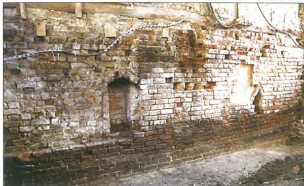
Abb. 23 Hansestadt Greifswald, Schuhhagen 24, Kellergeschoss, Grenzmauer zu Schuhhagen 25, Westseite. Von der mittelalterlichen Kelleranlage war die Ostmauer am besten erhalten: Eine Schranknische mit Dreieckssturz aus stehenden Bindern, eine kleine Nische mit Winkelsturz sowie der regelmäßige Wendische Mauerverband lassen zusammen mit der charakteristischen Gründungstechnik eine Datierung in die Zeit 1270/80 zu. Die oberhalb der Nischen vortretenden Steinlagen (zum Teil nachträglich abgearbeitet) verweisen auf eine geplante Holzbalkendecke. Foto: A. Lutze
