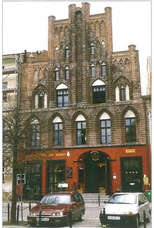
Abb. 34 Hansestadt Greifswald, Markt 13, marktseitige Fassade. Die ursprünglichen Teile der oberen Giebelmauer (Bereiche der dunkleren, dreiecksförmigen Fläche) konnten in die Zeit um 1289 (d) datiert werden. Bauhistorischen Untersuchungen haben gezeigt, dass die vordere Giebelebene nicht nur durch das Laibungsmauerwerk der hohen Mittelnische, sondern auch durch Pfeiler an den Giebelflanken, die auf vorkragenden Konsolen ruhten, gegliedert war. Die in den 1950er Jahren vorgenommene und 1994/1995 sanierte Teilrekonstruktion als Stufengiebel gibt damit nur ansatzweise die ursprünglich als Pfeiler-Blenden-Giebel angelegte Fassadengestalt wieder. Foto: A. Lutze
