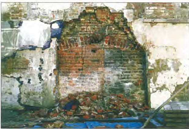
Abb. 42 Hansestadt Greifswald, Knopfstraße 15, Grenzmauer zu Markt 9, Erdgeschoss, Nordseite. Die ein Stein tiefe und mit einem flachen Dreieckssturz schließende Nische zeigte, dass mit der nördlichen Brandmauer des um 1280/90 errichteten Eckhauses eine Anschlussbebauung nach Norden erwartet wurde. Foto: A. Lutze
