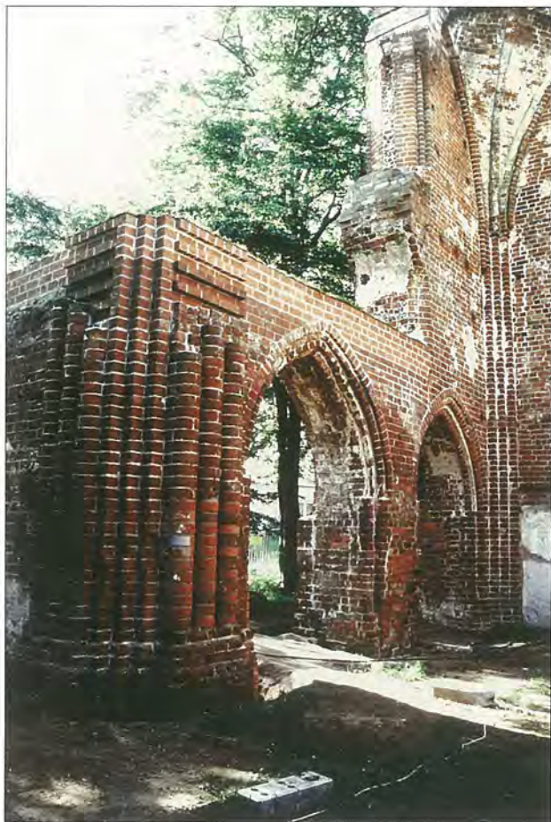
Abb. 11 Hansestadt Greifswald, Klostruine Eldena, ehemalige Klosterkirche. Der Bildausschnitt links zeigt den südöstlichen Vierungspfeiler mit den charakteristischen Dreiergruppierungen ein Stein breiter Halbsäulen, die auch für die Laibungen der nach Süden anschließenden und innerhalb der Südquerhausostmauer gelegenen Nebenkapellenzugänge rekonstruiert werden können (um 1210/15 bis 1225). Im Bild rechts sind die mit Halbsäulen und Dreiviertelrundstäben reich ausgestalteten Laibungen und Archivolten der südlichen Mittelschiffsarkade zu sehen (um 1240/45). Die von Schrägläubungen eingefasste Fensternische über dem Zugang vom Südquerhaus zum südlichen Seitenschiff weist als oberen Abschluss einem flachen Winkel- bzw. Dreieckssturz auf, einer noch für die Zeit um 1280 im Greifswalder Profanbau nachweisbaren Bogenform. Foto: A. Lütze
