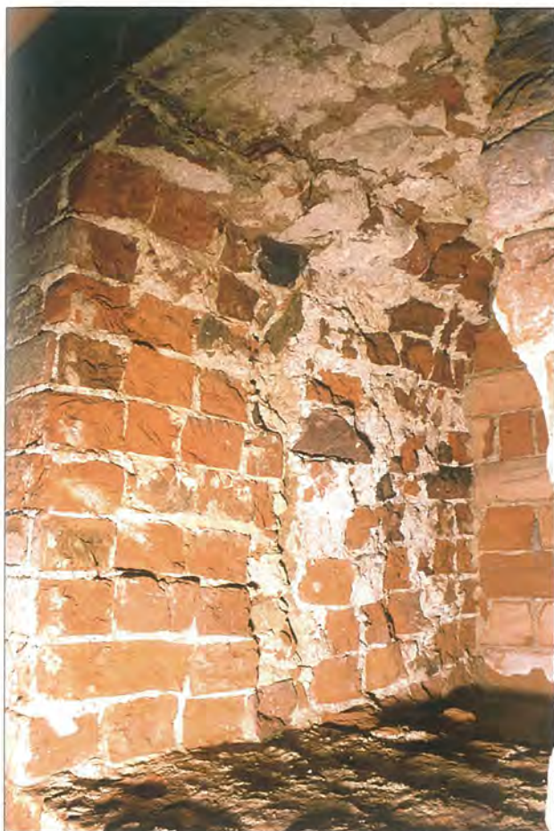
Abb. 8 Hansestadt Greifswald, Markt 23-25, Kellergeschoss. Beide Bildausschnitte zeigen die Besonderheit direkt gegeneinander gesetzter Mauerzüge und somit die Querschnitte von insgesamt vier Mauerzügen (Befunde erst durch nachträgliche Luftschutzdurchbrüche sichtbar geworden). Bei allen Baustrukturen ließ sich das schichtweise Aufführen des Mauerkerne mit den Mauerschalen sowie die Verwendung verschiedener Mörtel für Schalen- und Kernmauerwerk beobachten, links die Grenzmauer zwischen Markt 25/24 (um 1270/ um 1290), rechts jene zwischen Markt 23/24 (um 1280/85 und um 1290). Fotos: A. Lutze
