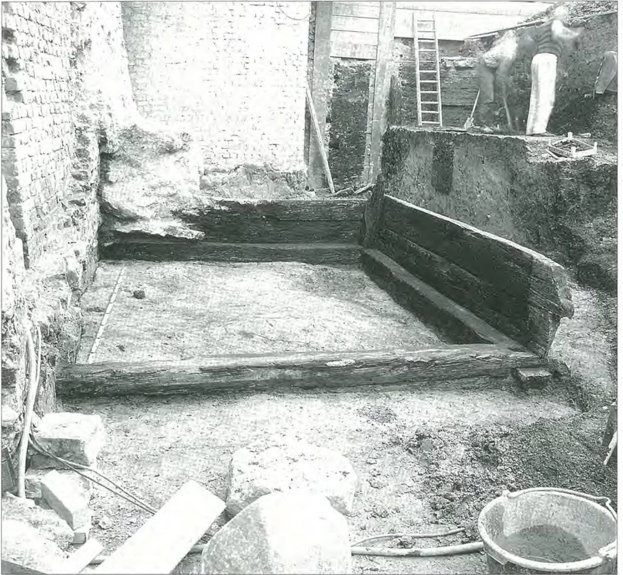
Anlage 4: Hansestadt Greifswald, Steinbeckerstraße 26b, Hofbereich. Im unmittelbaren Anschluss an das heutige Vordergebäude konnten 1993 die Überreste einer hölzernen Unterkellerung ergraben und in das Jahr 1253 datiert werden (Blick von Süden). Die erhaltenen Bauteile ermöglichten einen Einblick in den konstruktiven Aufbau solcher frühen Kelleranlagen. Das freigelegte Beispiel war als Ständerbau auf Schwellbalken und mit Wänden aus hochkant stehenden Bohlen ausgebildet (Abb. aus: H. Schäfer 2001, S.428).
