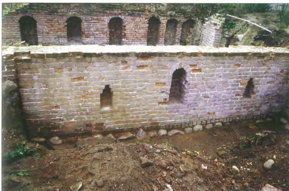
Abb. 20 Hansestadt Greifswald, Fleischerstraße, Bereich der ehemaligen Fleischertoranlage. Während der Neugestaltungsarbeiten im Jahre 2002 konnte ein Abschnitt des ältesten massiven Stadtmauerriuges dokumentiert werden. Dessen Südseite (im Bild) zeigte alle typischen bautechnischen Merkmale von Backsteinmauerwerk des letzten Drittels des 13. Jahrhunderts. Ob der Befund auch zu einem massiven Torturm oder größeren Toranlage gehörte, konnte vorerst nicht bestimmt werden. Foto: A. Lutze
