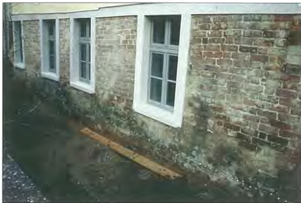
Abb. 21 Hansestadt Greifswald, Lange Straße 2 (ehemaliger Fettentorbereich). Im unteren Bereich der Westgiebelmauer haben sich Teile der ursprünglichen massiven Stadtbefestigung aus der Zeit 1275/80 erhalten. Im südlichsten der mit Putzfasschen eingefassten Fenster (im Bild ganz rechts) kann ein nach Norden mit einer Stehenden Zahnung abschließender älterer Mauerabschnitt unterschieden werden. Dieser Befund lässt darauf schließen, dass der (nicht mehr vorhandene) massive Torbereich offenbar zuerst, vermutlich bereits um 1270/75, errichtet wurde. Foto: A. Lutze
