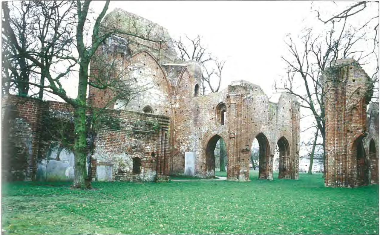
Abb. 10 Hansestadt Greifswald, Klostrerruine Eldena, ehemalige Kirchenostteile, Überblick über den Bestand aus der ersten Hälfte des 13. Jahrhunderts, von Nordosten. Links im Bild die unteren Partien der um 1210/15 entstandenen Chorsüdmauer, mittig und rechts die um 1240/45 fertig gestellten Teile des Südquerhauses und des östlichen Langhausjoches. Der erhaltene Giebelteil der Südquerhaus südmauer ist in den 1250er Jahren entstanden, dort bereits mit dem charakteristisch hohen Backsteinformat des zeitlich unmittelbar folgenden Ostflügels aufgeführt. Foto: A. Lutze
