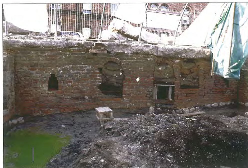
Abb. 45 Hansestadt Greifswald, Rotgerber-/ Ecke Loeffler-straße. Der bislang älteste bekannte Steinkeller der ehemaligen Neustadt datiert über die mit der Nordmauer ausgeführten Steinformate, die kleine Nischenform mit abgetrepptem Sturz sowie die rundbogigen Abschlüsse einer Schranknische und eines Kellerzuges (Bildmitte) in die späten 1280er Jahre. Foto: A. Lutze
