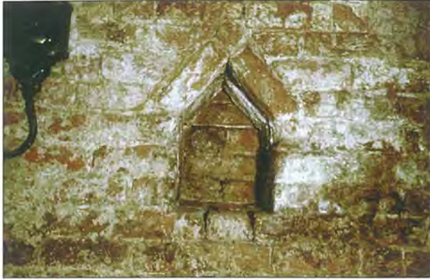
Abb. 32 Hansestadt Greifswald, Lange Straße 75, Kellergeschoss, Vorderfassade, Mauer Südseite. Neben den vier Steinlagen hohen und ein Stein tiefen Nischen (siehe auch Abb. 33) kommen gelegentlich noch kleinere Formen vor. Die hier abgebildete drei Steinschichten hohe und spitzwinklig schließende Nische gehört zum ursprünglichen, 1283 (d) entstandenen Mauerwerksbestand des Kellers. Foto: A. Lutze
