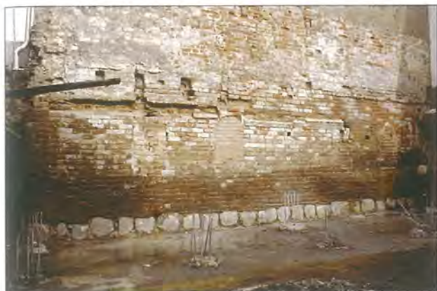
Abb. 30 Hansestadt Greifswald, Lange Straße 49, Westgabelmuer. Im unteren Bereich der Westwand (heutiges Kellergeschoss) ist Mauerwerk der Zeit 1270/80 erhalten geblieben (siehe auch Abb. 4). Diesen ältesten Bestand der Westmuer gliederten ursprünglich paarig angeordnete, jetzt zugesetzte (Fenster-?) Öffnungen in Richtung des ehemals Alt- und Neustadt trennenden wasserführenden Grabens. Foto: A. Lutze
