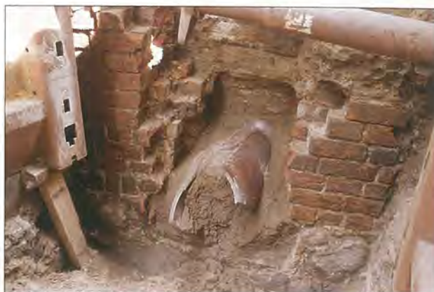
Abb. 20 Hansestadt Greifswald, Fleischerstraße, Bereich der ehemaligen Fleischertoranlage. Während der Neugestaltungsarbeiten im Jahre 2002 konnte ein Abschnitt des ältesten massiven Stadtmauerriuges dokumentiert werden. Dessen Südseite (im Bild) zeigte alle typischen bautechnischen Merkmale von Backsteinmauerwerk des letzten Drittels des 13. Jahrhunderts. Ob der Befund auch zu einem massiven Torturm oder größeren Toranlage gehörte, konnte vorerst nicht bestimmt werden. Foto: A. Lutze
