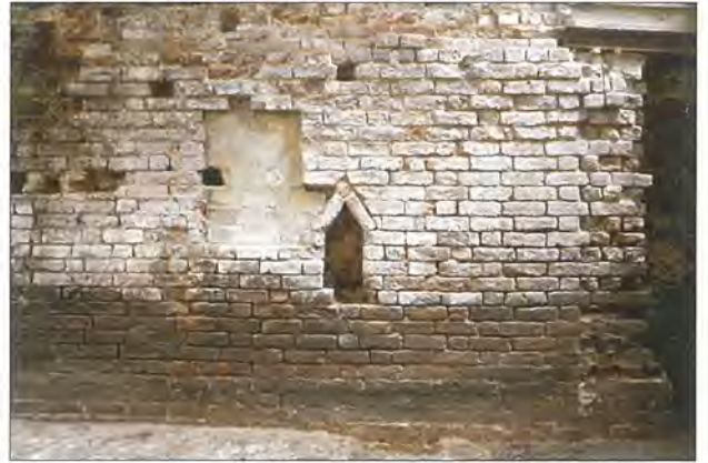
Abb. 25 Hansestadt Greifswald, Schuhhagen 24, Detail zu Abb. 23, südlicher Mauerabschnitt. Am südlichen Ende der Grenzmauer zu Nr. 25 wurde ein regelrechter Zahnungskopf mit Stehenden Zahnungen ausgebildet: Je eine nach Westen (im Bild rechts) und Osten zur Aufnahme von Rückfassadenmauerwerk, sowie eine weitere nach Süden, die auf eine geplante Mauerverlängerung in entsprechender Richtung schließen lässt. Foto: A. Lutze
