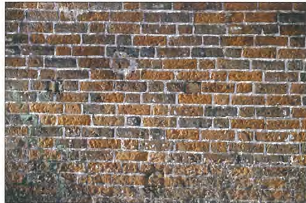
Abb. 6 Hansestadt Greifswald, Lange Straße 51, ehemalige Kirche des Heilig-Geist-Hospitals, Ostmauer (1285/90), nördlicher Abschnitt. Am Ende der 1280er Jahre wurden Mauerschalen, wie hier an der Kirchenostseite, noch in einem regelmäßigen Wendischen Verband aufgemauert. Danach (bis ca. 1320/30) treten vermehrt reine Läuferlagen in den Verbandsfolgen auf. Foto: A. Lutze
