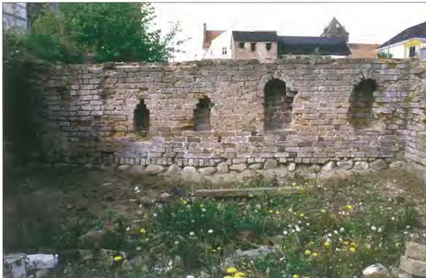
Abb. 18 Hansestadt Greifswald, Rakowerstraße 9 (Süd), Kellergeschoss, Nordmauer, Südseite. Neben der für das 13. Jahrhundert charakteristischen Gründungstechnik kann das Backsteinmauerwerk auch über den regelmäßigen Wendischen Verband und das hohe Steinformat in die Zeit um 1270 datiert werden. Ungewöhnlich ist die paarige Anordnung von zwei verschiedenen Nischenformen, die sich auf der Mauernordseite nicht wiederholt. Wie im frühen Backsteinkeller Fleischerstraße 17 war auch hier die gleichzeitig entstandene, jedoch nur halb bis eineinhalb Stein dicke Rückmauer (rechts im Bild deren Abbruchspur) unregelmäßig gegen die dahinter anstehenden anthropogenen Schichten gesetzt.
