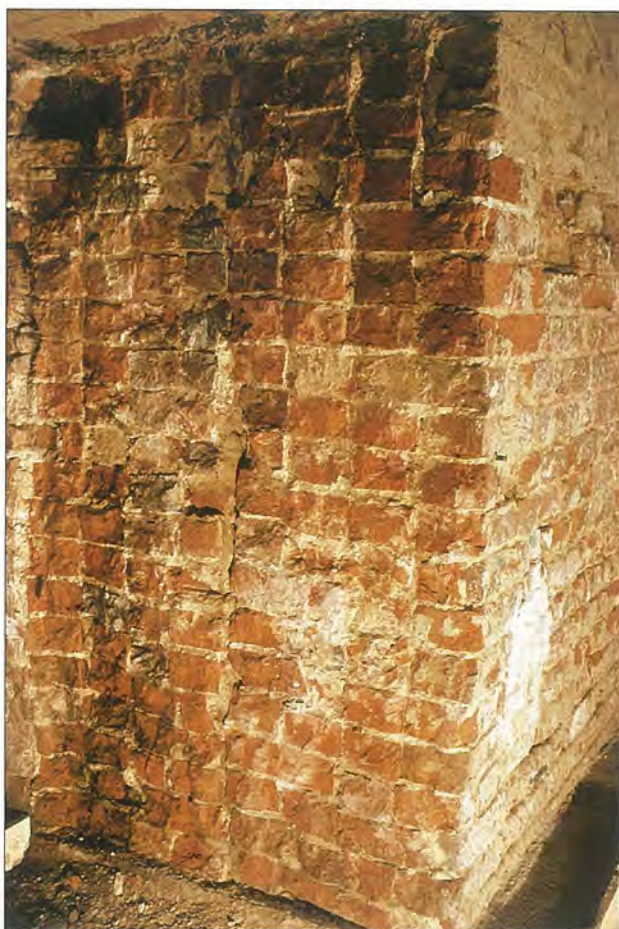
Abb. 8 Hansestadt Greifswald, Markt 23-25, Kellergeschoss. Beide Bildausschnitte zeigen die Besonderheit direkt gegeneinander gesetzter Mauerzüge und somit die Querschnitte von insgesamt vier Mauerzügen (Befunde erst durch nachträgliche Luftschutzdurchbrüche sichtbar geworden). Bei allen Baustrukturen ließ sich das schichtweise Aufführen des Mauerkerne mit den Mauerschalen sowie die Verwendung verschiedener Mörtel für Schalen- und Kernmauerwerk beobachten, links die Grenzmauer zwischen Markt 25/24 (um 1270/ um 1290), rechts jene zwischen Markt 23/24 (um 1280/85 und um 1290). Fotos: A. Lutze
