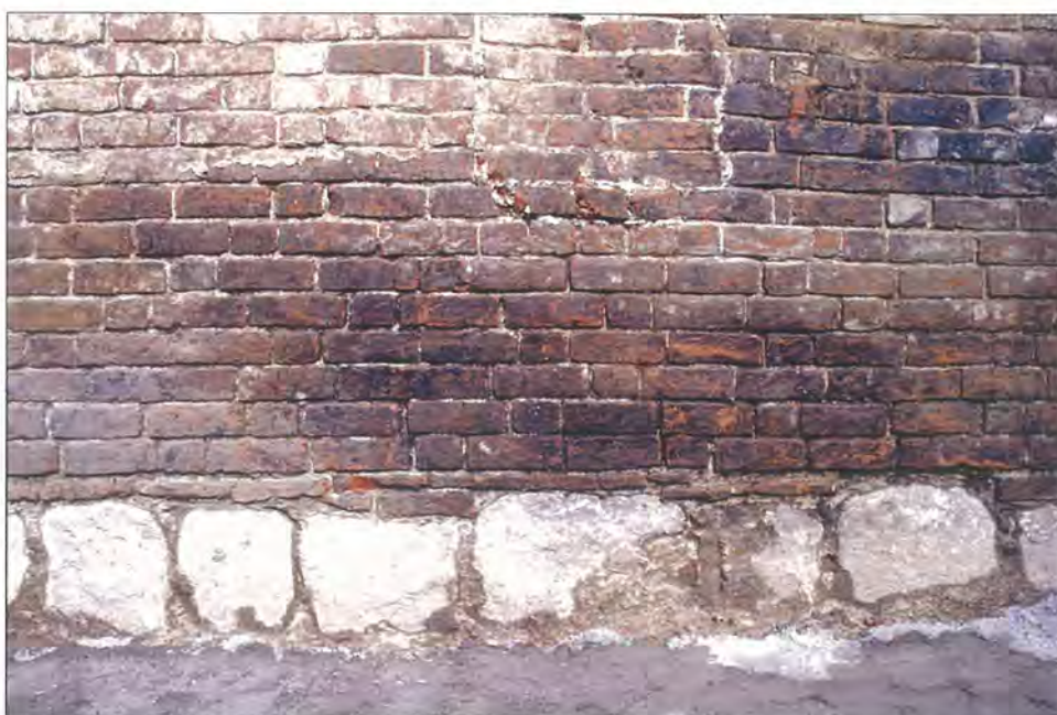
Abb. 3 Hansestadt Greifswald, Klostersruine Eldena, ehemaliger Ostflügel, Ostmauer, Ostseite, Sockelbereich unterhalb der Sakristeifenster. Im Zisterzienserkloster Eldena ist bereits um 1260 die für die ältesten Greifswalder Backsteinbauten typische Gründungstechnik voll ausgeprägt: Über einer Feldsteinlage ist die erste (Ausgleichs-) Schicht aus Backsteinen bereits in Mörtel verlegt, darüber folgt die nächste Lage bereits im Wendischen Verband (in Greifswald dann auch mit mehr als zwei Läufern hintereinander). Foto: A. Lutze
