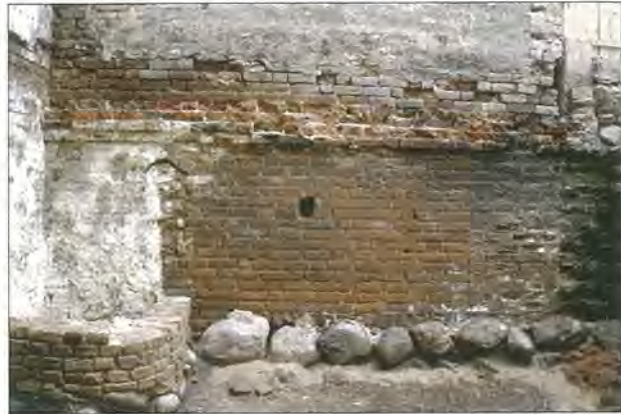
Abb. 29 Hansestadt Greifswald, Markt 14, Kellergeschoss. Die rund 21 m lange nördliche Brandmauer zeigte neben Nischengestaltungen mit dreiecksförmigen Abschlüssen (siehe auch Abb. 23-25 zu Schuhhagen 24) das typische Steinformat und die charakteristische Gründungstechnik der 1270er Jahre. Eine Besonderheit bildete die ursprüngliche Vorbereitung einer massiven (jedoch erst Anfang des 14. Jahrhunderts ausgeführten) Kellerunterteilung für den hinteren Gebäudebereich. Im Bildausschnitt rechts ist neben dem abgearbeiteten Balkenauflegebereich auch der drei Stein breite Maueranschluss für die ursprünglich vorgesehene Rückfassade erkennbar. Foto: A. Lutze
