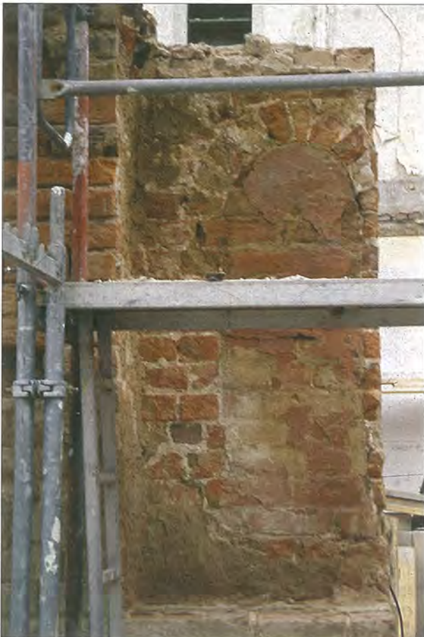
Abb. 38 Hansestadt Greifswald, Markt 28, Grenzmauer zu Nr. 29, Südseite. Neben Nischenformen mit geradem bzw. abgetrepptem Sturz (siehe Umschlagmotiv) konnten auch rundbogig schließende Schranknischen erfasst werden. Foto: A. Lutze
