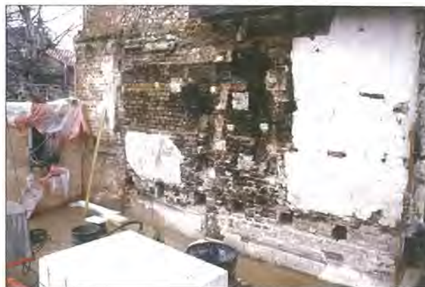
Abb. 17 Hansestadt Greifswald, Fleischerstraße 17, Brandmauer zu Fleischerstraße 16, Südseite. Innerhalb des aufgehenden ursprünglichen Mauerwerks der jüngeren Brandmauer (1330/40) konnten unterhalb (!) des vorbereiteten Dielenauflegers über den gesamten westlichen Mauerabschnitt die Negativabdrücke ummauerter schräg stehender Hölzer (Sparren?) erfasst werden. Diese Befunde lassen es möglich erscheinen, dass das über dem älteren Steinkeller gleichzeitig errichtete Gebäude giebelständig und deutlich tiefer war, als es der Kellergrundriss vermuten lässt. Foto: A. Lütze
