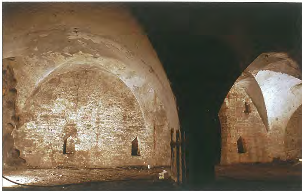
Abb. 27 Hansestadt Greifswald, Baderstraße 3, mittelalterliche Trennmauer im südlichen Kellerbereich, Überblick von Nordwesten. Der um 1270/80 entstandene Mauerzug (Einwölbung aus der zweiten Hälfte des 18. Jahrhunderts) zeigt eine regelmäßige, über die gesamte Wandfläche ausgeführte Verteilung dreier spitzwinklig geschlossener kleiner Nischen als alleiniges Gliederungsmotiv. Foto: A. Lutze
