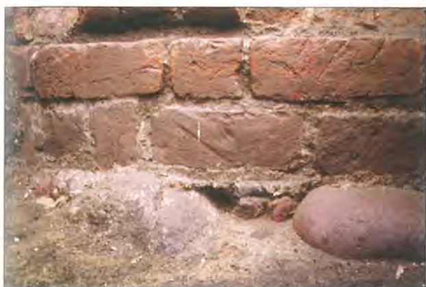
Abb. 3 Hansestadt Greifswald, Klostersruine Eldena, ehemaliger Ostflügel, Ostmauer, Ostseite, Sockelbereich unterhalb der Sakristeifenster. Im Zisterzienserkloster Eldena ist bereits um 1260 die für die ältesten Greifswalder Backsteinbauten typische Gründungstechnik voll ausgeprägt: Über einer Feldsteinlage ist die erste (Ausgleichs-) Schicht aus Backsteinen bereits in Mörtel verlegt, darüber folgt die nächste Lage bereits im Wendischen Verband (in Greifswald dann auch mit mehr als zwei Läufern hintereinander). Foto: A. Lutze
