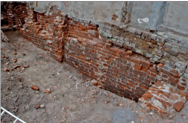
Abb. 3 Greifswald, Marienkirchplatz 1/2. Östliche Giebelmauer (Detail zu Abb. 2a). Die östliche Wandfläche der nachträglich unter die Grenzmauer zu Haus Nr. 2 gesetzten Unterfangung war durch zwei Lisenen gegliedert (die nördliche weitgehend abgearbeitet). Blick nach Südwesten. Foto: A. Lutz (1997)
