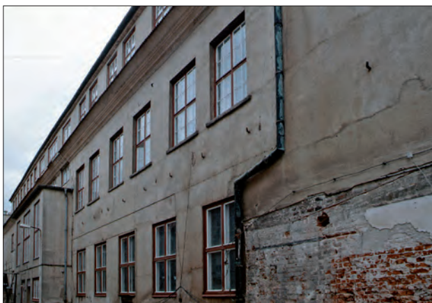
Abb. 18 Greifswald, Rathaus. Nordseite vor der Sanierung in den Jahren 1996/1997. Die Eisenhaken über dem Erdgeschoss dienen zur Befestigung des Pultdaches einer im Mittelalter hier angefügten Budenzeile. Blick nach Südosten. Foto: A. Lutze (1996)
