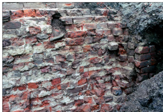
Abb. 8 Greifswald, Domstraße 50/51. Straßenseitige Kellermauer einer um 1270/1280 entstandenen Budenzeile (siehe Abb. 7). Das Kernmauerwerk ist lagenweise zusammen mit den Mauerchalen aufgeführt worden. Blick nach Südwesten. Foto: A. Lutze (2000)
