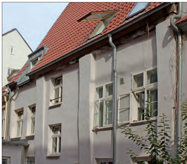
Abb. 21 Greifswald, Lange Straße 93. Von der Erneuerung der Budenzeile kurz nach der Mitte des 15. Jahrhunderts sind bis heute die geschossübergreifenden Pfeiler an der Rückfassade sowie Teile der Dachkonstruktion mit ihrer sehr steilen Neigung erhalten. Blick nach Nordwesten. Foto: A. Lutze (2013)
