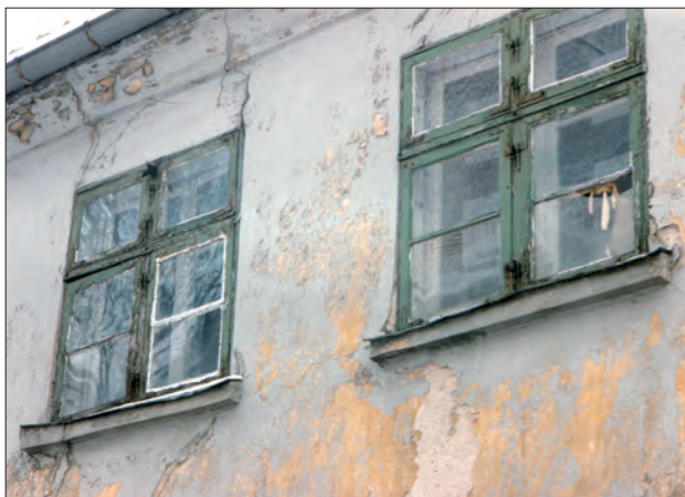
Abb. 13 Greifswald, Marienkirchplatz 1/2. Am Pfosten angeschlagene Fenster im Obergeschoss der Vorderfassade von Haus Nr. 1 (1848). Blick nach Südosten. Foto: J. Chr. Holst (1997)
