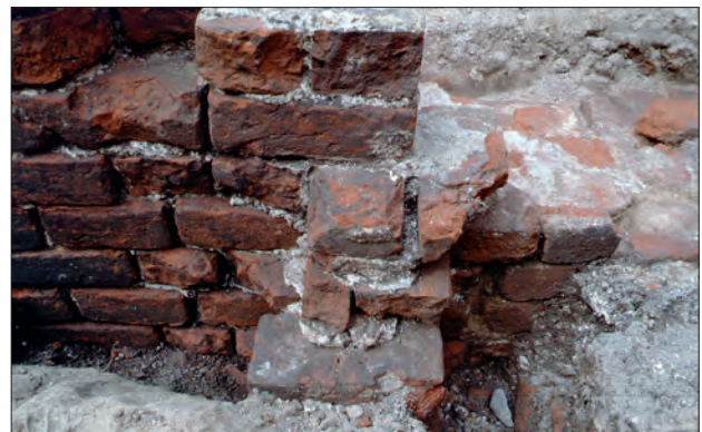
Abb. 14 Greifswald, Markt 20/21. Westmauer eines mittelalterlichen Kellers im hinteren Grundstücksbereich an der Fleischerstraße. Anschluss einer Binnenmauer. Blick nach Westen. Foto: A. Lutze (1997)
