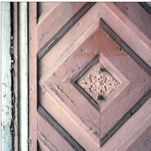
Abb. 18 Greifswald, Marienkirchplatz 1/2. Schild eines abgebrochenen Türklopfers an der wiederverwendeten Haustür von Haus Nr. 2 (wohl um 1700). Foto: J. Chr. Holst (1997)
