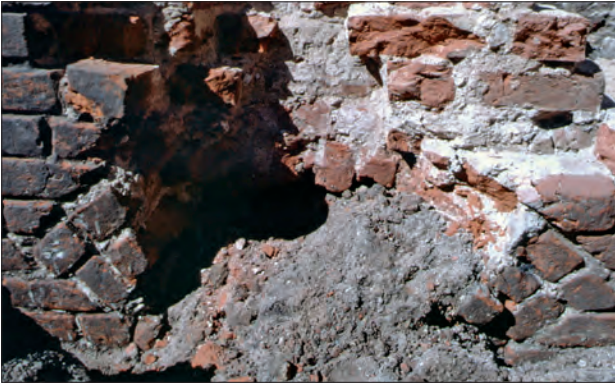
Abb. 11 Greifswald, Markt 20/21. Westmauer eines mittelalterlichen Kellers im rückwärtigen Grundstücksbereich an der Fleischerstraße. Die Segmentbögen der unterschiedlich breiten Nischen waren teilweise erhalten. Blick nach Westen. Foto: A. Lutze (1997)
