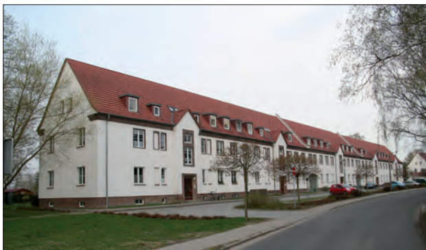
Abb. 12 Greifswald, Ortsteil Ladebow, Max-Reimann-Straße 11-19. Für die ehemalige „Offizierssiedlung“ der Luftwaffe wurden 1936-1938 insgesamt 14 zweigeschossige Reihen-Wohnhäuser errichtet. Grundsätzlich der Heimatschutz-Architektur verpflichtet, kommen auch sachliche-funktionale Züge deutlich zum Tragen. Blick nach Westen. Foto: D. Brandt (2013)
