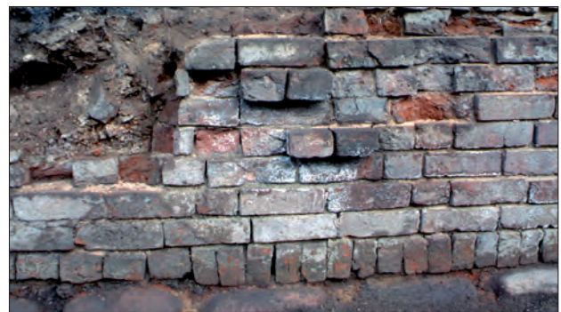
Abb. 4 Greifswald, Rakower Straße 9. Straßenseitige Kellermauer im mittleren Grundstücksbereich. Detail zu Abb. 3: Reste einer Anzahnung für eine Binnenmauer. Blick nach Westen. Foto: A. Lutze (2002)
