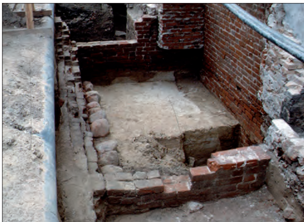
Abb. 17 Greifswald, Rathaus. Mauerreste eines mittelalterlichen Vorkellers auf der Südseite, unterhalb des heutigen Hauptzuganges. Blick nach Westen. Foto: A. Lutze (1996)
