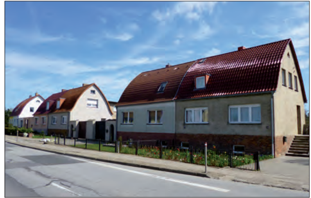
Abb. 5 Greifswald, Loitzer Landstraße 43-48. Eine kleine Gruppe typisierter Doppelhäuser, 1926-1928 gebaut im Auftrag der Wohnungsfürsorgegesellschaft Pommersche Heimstätte m.b.H. Da gebaute Bohlenbinder-Dächer die Einrichtung von Wohnraum im Dachbereich begünstigten, wurden mit ihnen bevorzugt auch Kleinhäuser versehen. Blick nach Nordosten. Foto: M. Lissok (2013)
