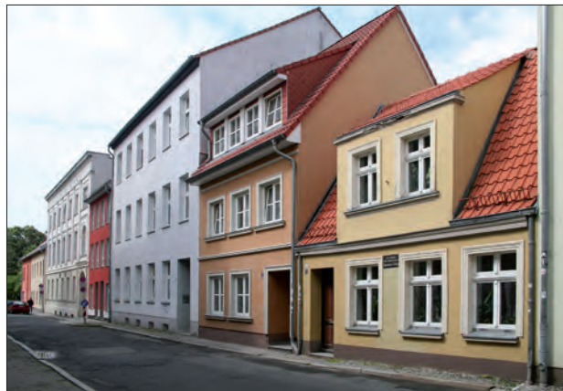
Abb. 2 Greifswald, Lutherstraße 2 (rechts). Rest einer Reihenhäuseranlage, die sich nach Süden bis zum heutigen Gebäude Martin-Luther-Straße 6 erstreckte. Verschiedene konstruktive Details des steilen Satteldachs zeugen von seiner Entstehung im 17. Jahrhundert. Blick nach Südwesten. Foto: D. Brandt (2013)
