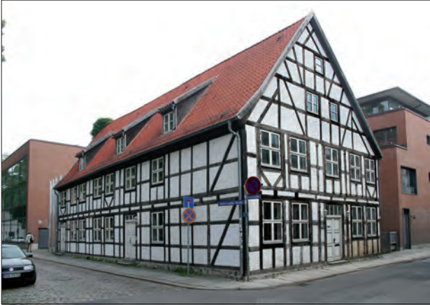
Abb. 6 Greifswald, Domstraße 52 / Lutherstraße 11/12. Die aufdringliche Farbfassung des 1727/1728 errichteten Reihenhauses mit schwarzen Balken und weißen Ausfachungen entspricht nicht der Gestaltung des 18. Jahrhunderts. Die ursprüngliche Farbgebung entsprach eher jener, die an den Fachwerkbuden auf dem Hof des Hospitals St. Spiritus wiederhergestellt wurde. Blick nach Nordosten. Foto: D. Brandt (2013)
