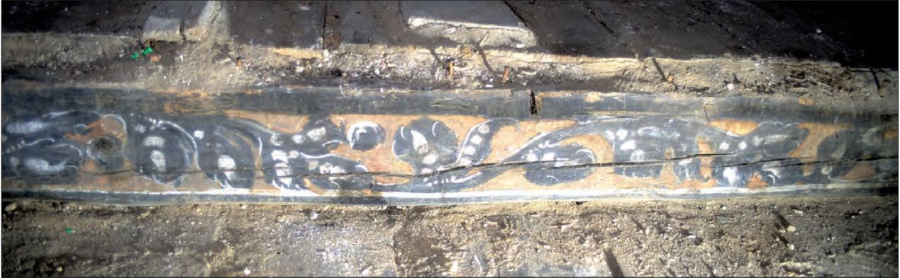
Abb. 11 Greifswald, Marienkirchplatz 1/2. Bemalter Balken über der „Stube“ im Obergeschoss von Haus Nr. 1 (wohl 1586). Foto: T. Rütz (1997)
