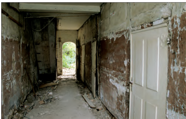
Abb. 5 Greifswald, Domstraße 15-19. Diele von Haus Nr. 17 während der Umbauarbeiten. Erkennbar ist die einheitliche Ausstattung an Innentüren und die einfache, in das Dachgeschoss führende Treppe. Blick nach Süden. Foto: T. Rütz (1994)
