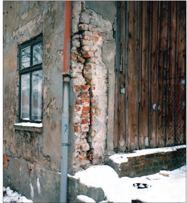
Abb. 4 Greifswald, Marienkirchplatz 1/2. Mauerwerk einer abgebrochenen älteren Bude an der Nordwestecke von Haus Nr. 1. Blick nach Südosten. Foto: J. Chr. Holst (1997)
