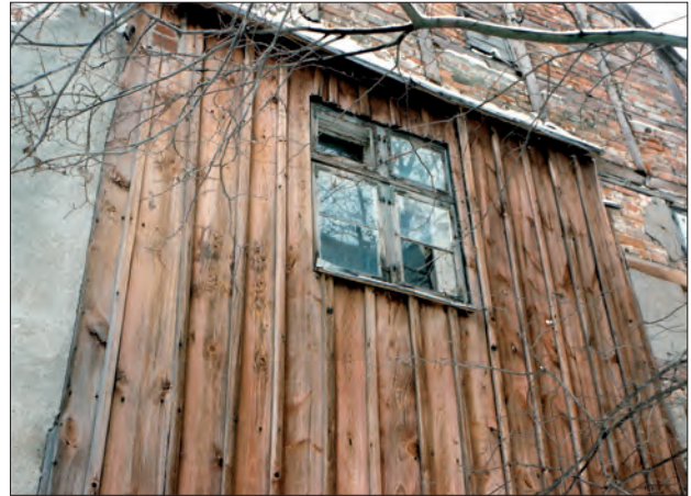
Abb. 16 Greifswald, Marienkirchplatz 1/2. Westliche Giebelseite mit einer Verbreiterung des Fachwerks zur Wärmedämmung der Stuben in Haus Nr. 1 (von 1848). Foto: J. Chr. Holst (1997)
