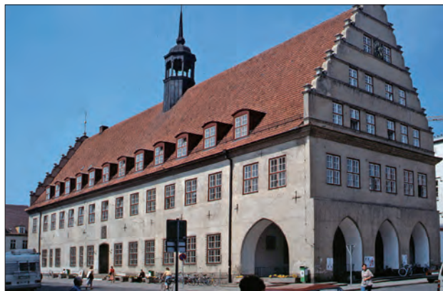
Abb. 15 Greifswald, Rathaus vor der Sanierung in den Jahren 1996/1997. Blick nach Nordwesten. Foto: A. Lutze (1990er Jahre)
