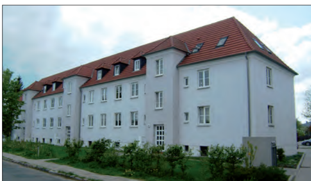
Abb. 13 Greifswald, Feldstraße 43-45. Der zweigeschossige Wohnblock wurde zusammen mit vier kleineren Mehrfamilienhäusern am Birnenweg während der Kriegsjahre 1941/1942 errichtet. Blick nach Südwesten. Foto: M. Lissok (2013)
