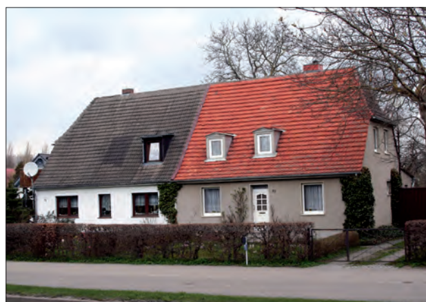
Abb. 4 Greifswald, Wolgaster Straße 72/73. In den Jahren 1920/1921 zusammen mit 9 anderen Siedlerhäusern nach einem Entwurf von Gustav Bastel errichtetes Heimstätten-Doppelhaus. Blick nach Norden. Foto: D. Brandt (2013)
