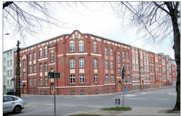
Abb. 2 Greifswald, Lange Reihe 39-42 / Neunmorgenstraße 21/22. Reihenhauskomplex des Greifswalder Spar- und Bauvereins (1905). Das Abschrägen der Hausecke erfolgte auch in Anpassung an den Verlauf der Kleinbahntrasse in Richtung Eldena/Wieck. Blick nach Nordwesten. Foto: D. Brandt (2013)
