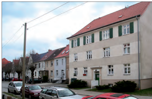
Abb. 6 Greifswald, Gebrüder-Witte-Straße. Dreigeschossiges Sechsfamilienhaus und zweigeschossige Einfamilienhaus-Reihe auf der Südseite, entworfen von Gustav Bastel (1919-1921). Hölzerne Fensterläden, wie hier im zweiten Obergeschoss des Mehrfamilienhauses (Rekonstruktion), gehörten zu den wichtigsten Gestaltungsmitteln im Wohnungsbau. Blick nach Südosten. Foto: D. Brandt (2013)
