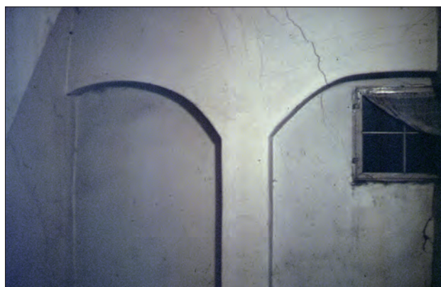
Abb. 6 Greifswald, Marienkirchplatz 1/2. Blendfelder auf der Innenseite der 1585/1586 neu errichteten Umfassungsmauern. Die auch als Sparnischen bezeichneten Mauervertiefungen sind im vorpommerschen Profanbau ein typisches renaissancezeitliches Architekturelement. Foto: A. Lutze (Anfang der 1990er Jahre)
