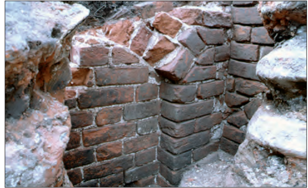
Abb. 13 Greifswald, Markt 20/21. Südmauer eines mittelalterlichen Kellers im rückwärtigen Grundstücksbereich an der Fleischerstraße mit etwa 15 cm tiefen Blendfenstern. Im Bild rechts die Verzahnung mit der Westmauer. Blick nach Südwesten. Foto: A. Lutze (1997)
