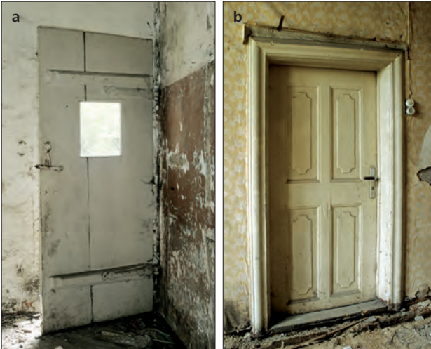
Abb. 6 Greifswald, Domstraße 15-19. Schlichte barocke Brettertür zum Hof aus der Zeit um 1736/1737 (a). Der überwiegende Teil der erhaltenen Innentüren war in der Form der Stubentür aus der zweiten Hälfte des 18. Jahrhunderts (b) gestaltet. Foto: T. Rütz (1994)
