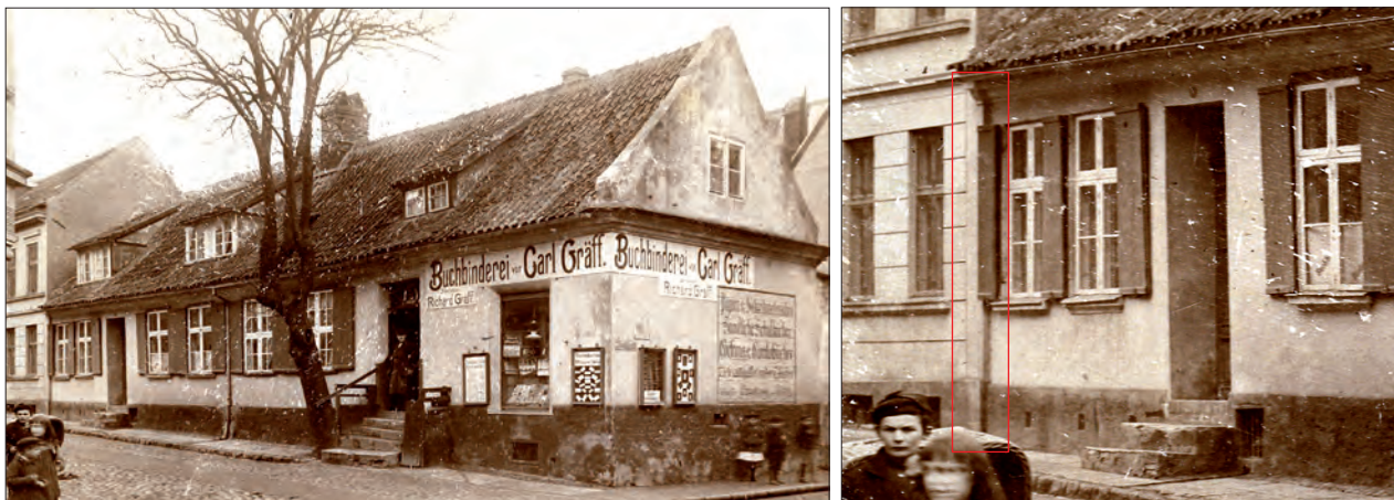
Abb. 10 Greifswald, Domstraße 43/44. Budenzeile auf der Nordseite der heutigen Domstraße zwischen Bader- und Fleischerstraße. Trotz vieler Veränderungen ist im Grenzbereich zum Haus Domstraße 45 der auf das 18. Jahrhundert zurückgehende Versprung der Bauflucht mit der Verkrüpfung des Traufgesimses erkennbar (Rahmen). Blick nach Nordwesten. Abbildung: StAG AIC Nr. 932 (Aufnahme kurz vor 1906)
