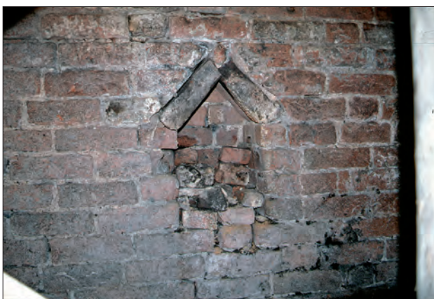
Abb. 20 Greifswald, Lange Straße 93. Spitzwinklig geschlossene Mauernische in der Südmauer der 1290/1310 entstandenen Kelleranlage. Foto: A. Lutze (1990er Jahre)
