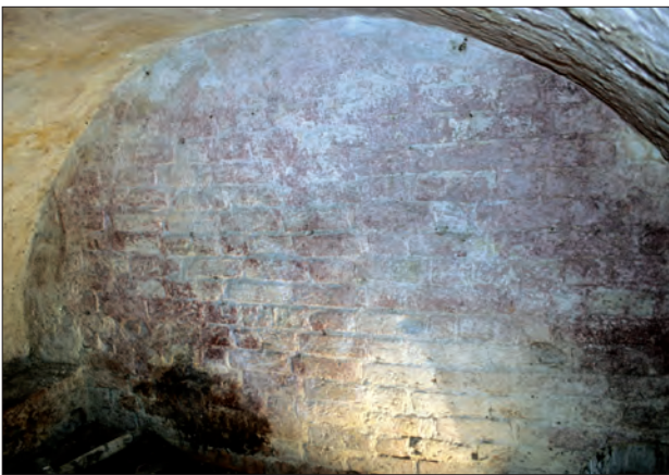
Abb. 2 Greifswald, Domstraße 15-19. Eine der erhaltenen mittelalterlichen Kellerwände in Hausnummer 16. Das Tonnengewölbe entstand im Zusammenhang mit dem Neubau von 1736/1737 und ersetzte eine Holzbalkendecke. Blick nach Südwesten. Foto: T. Rütz (1994)
