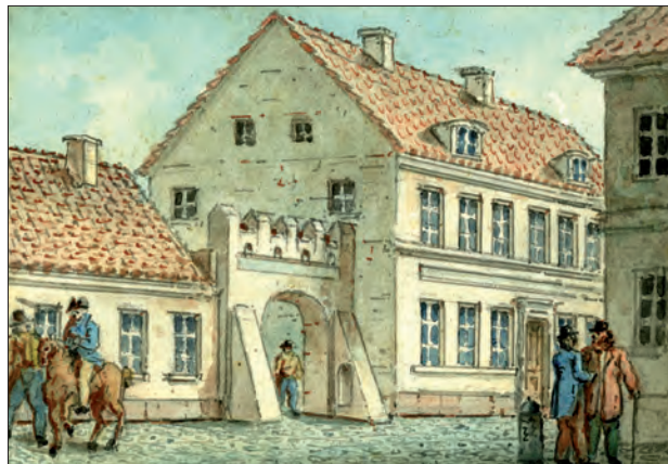
Abb. 1 Greifswald, Domstraße. Blick von Südwesten auf das im Jahr 1521 errichtete Tor der Hofanlage Domstraße 14. Links des Portals schließt die Budenzeile Domstraße 15-19, rechts davon das Pfarrhaus von St. Nikolai (Domstraße 13) an. Aquarell von Johann Martin Giehr (um 1840). Abbildung: Pommersches Landesmuseum K1/233
