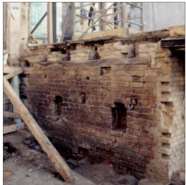
Abb. 3 Greifswald, Fleischerstraße 17. Südwand des Steinkellers (um 1270) mit zwei kleinen Lichnissen und der Mauerlatte als Auflage für die bis 1997 vorhandenen nord-süd-spannenden Deckenbalken von 1697. Blick nach Südosten. Foto: T. Rütz (1997)
