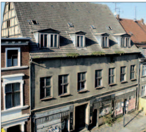
Abb. 1 Greifswald, Fleischerstraße 17. Straßenseitige Fassade vor der Sanierung. In der Grundsubstanz stammt die wohl in den 1960er Jahren geglättete Fassade von 1697. Die großen Fensteröffnungen im Obergeschoss entstanden erst durch den Umbau in den 1780er Jahren. Blick nach Nordwesten. Foto: T. Rütz (1993)
