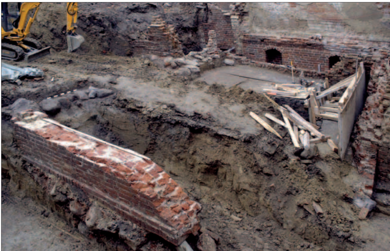
Abb. 10 Greifswald, Fleischerstraße 17. Blick über die Grabungsfläche nach Nordwesten. Der hofseitige Teil des um 1270 entstandenen Giebelhauses war nicht unterkellert und ursprünglich nur flach gegründet. Das nord-süd-laufende Feldsteinfundament links und hinten im Bild markierte die Lage der Giebelhausrückwand. Im Vordergrund die Mittelwand zwischen den beiden Teilgrundstücken (um 1400). Sie ersetzte vermutlich eine flach gegründete ältere Fundamentierung. Foto: T. Rütz (1997)
