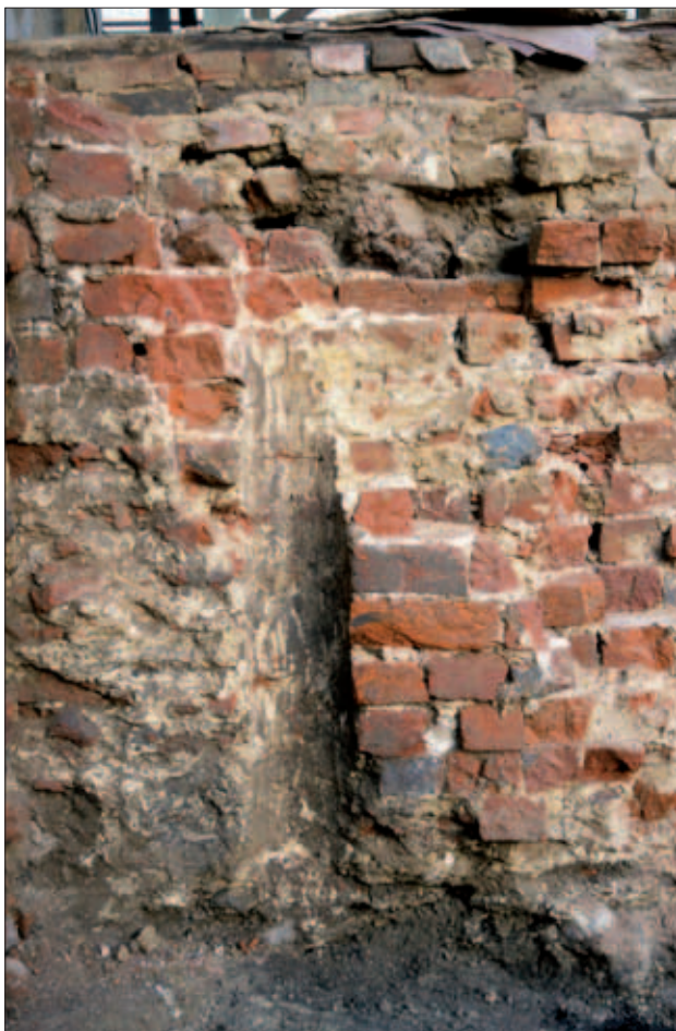
Abb. 4 Greifswald, Fleischerstraße 17. Rückwand (Westwand) des Steinkellers (um 1270). Die ursprünglich nicht sichtbare Außenseite wurde gegen anstehende Schichten gesetzt und deshalb nur unsauber gemauert und verfugt. Dabei ist auch ein Wandpfosten des zuvor verfüllten Holzkellers ummauert worden, dessen Abdruck erhalten blieb. Blick nach Osten. Foto: T. Rütz (1997)
