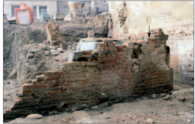
Abb. 2 Greifswald, Fleischerstraße 17. Rückwand (Westwand) des Steinkellers (um 1270) mit zugesetzter kleiner Lichnische (nördliches Drittel) und dem ehemaligen Kellerzugang von Westen (rechts daneben). Die Reste einer Binderreihe (Pfeil) markieren die Unterkante eines Rücksprungs, der als Auflager für die Deckenbalken diente. Blick nach Nordwesten. Foto: T. Rütz (1997)
