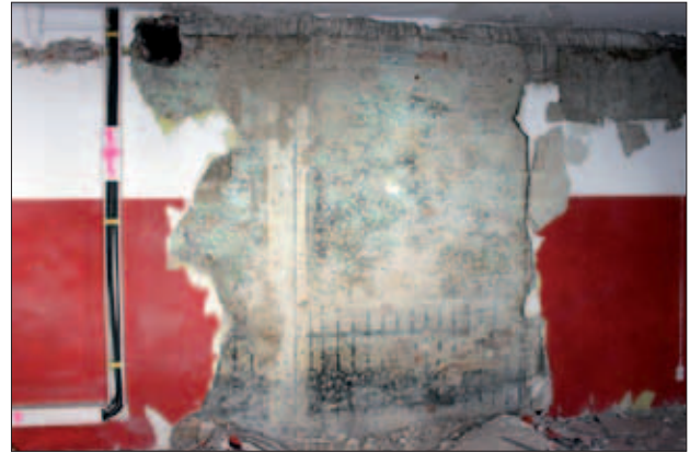
Abb. 19 Greifswald, Domstraße 12. Rare Überbleibsel einer großformatigen, wandfüllenden Ausmalung: Abschnitt eines Metallgitters. Foto: A. Lutze (2014)
