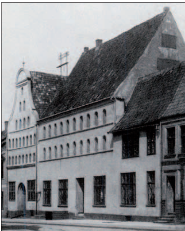
Abb. 4 Rostock, Burgwall 46/47. Die 1942 zerstörten Brauhäuser geben einen Eindruck vom äußeren Erscheinungsbild eines Brauhauses. Das Traufenhaus mit hoher Diele und darüber liegenden Speichergeschossen war Teil des Brauergrundstücks. Ähnlich dürfte auch die Fleischerstraße 17 um 1700 ausgesehen haben, allerdings mit nur einem Speichergeschoss. Abbildung: Konrad Reich Verlag, Rostock 1991 / Hinstorff Verlag, Rostock 2006, Abb. 84 (siehe Lorenz 1991)
