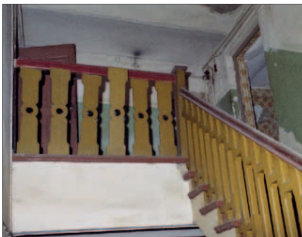
Abb. 8 Greifswald, Fleischerstraße 17. Treppenanlage im ersten Dachgeschoss. Im obersten Abschnitt der 1911 neu eingebauten Treppe waren ältere Brettdocken wiederverwendet. Sie dürften von der um 1780 entstandenen Treppenanlage stammen. Blick nach Norden. Foto: T. Rütz (1992)
