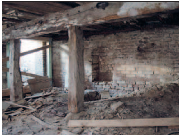
Abb. 2 Greifswald, Fleischerstraße 17. Der Kellerraum entstand bereits in den 1270er Jahren. Die Balkendecke mit Unterzug und Stützen gehörte zum Neubau von 1697. Die Brandwand mit Schranknische im Hintergrund wurde in der Zeit um 1330 errichtet. Blick nach Nordwesten. Foto: T. Rütz (1997)
