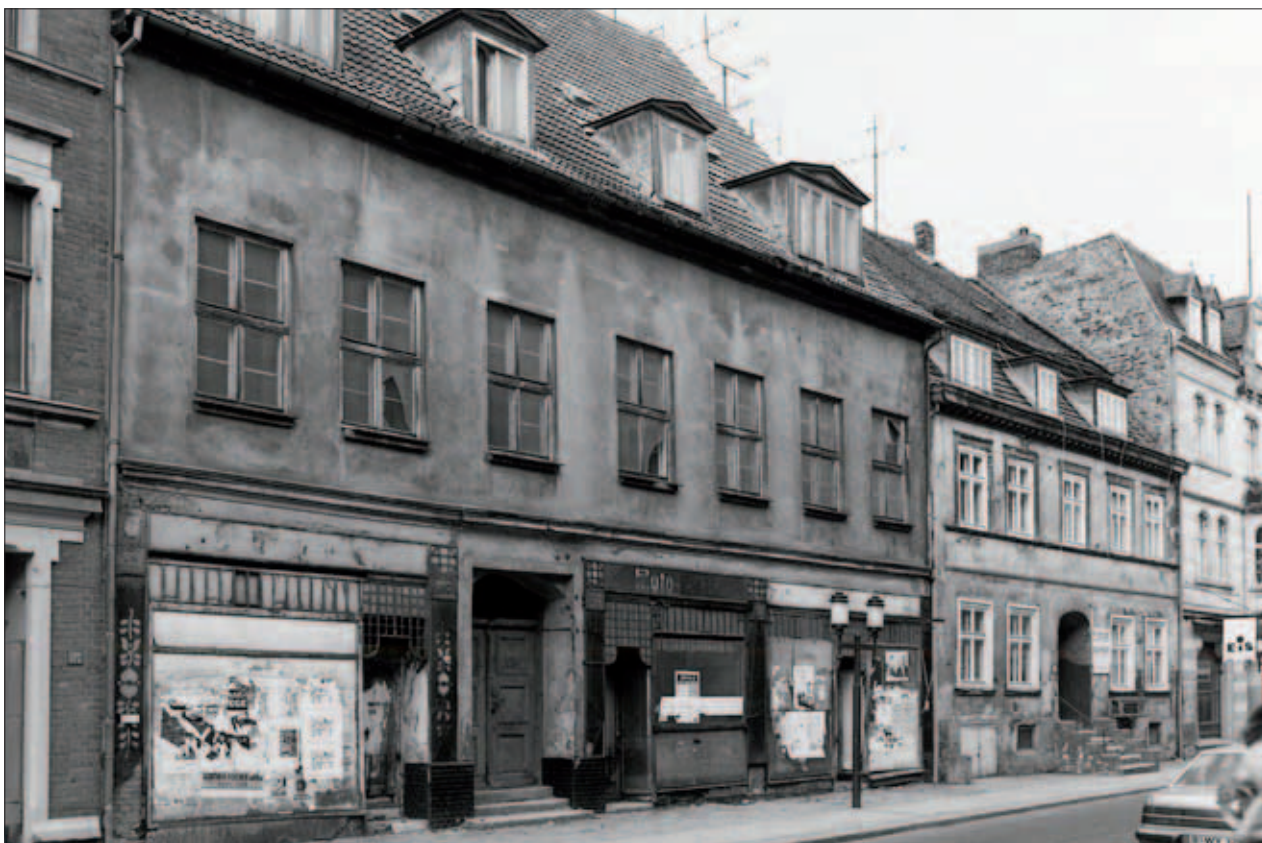
Abb. 1 Greifswald, Fleischersstraße 17. Ein auf mittelalterliche Ursprünge zurückgehendes Barockhaus mit wertvollen Ausstattungselementen des Rokoko und Klassizismus. Zum Zeitpunkt der Aufnahme wäre eine denkmalgerechte Sanierung möglich gewesen. Blick nach Nordwesten. Foto: Landesamt für Kultur und Denkmalpflege M-V / Landesdenkmalpflege / A. Bötöfür (1991)
