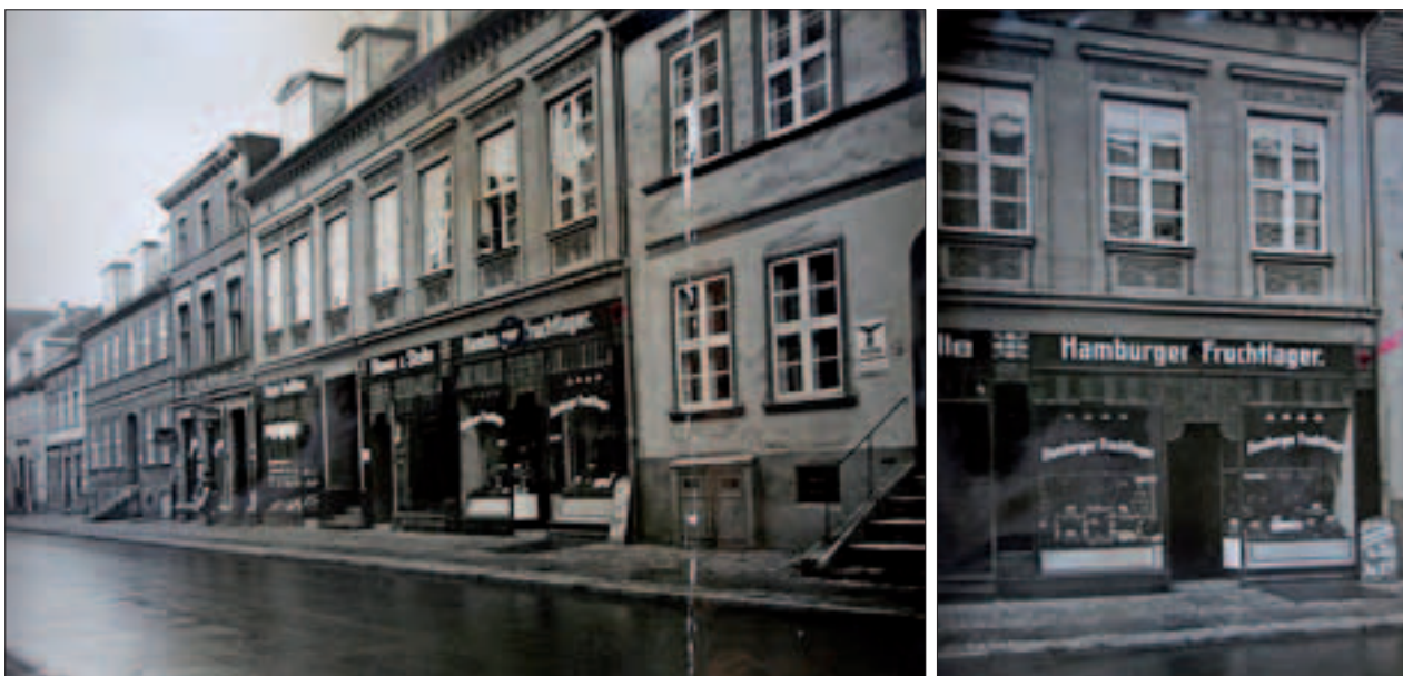
Abb. 3 und 4 Greifswald, Fleischerstraße 17. Während das Erdgeschoss durch die Ladeneinbauten von 1911 geprägt wurde, hatte sich im Bereich des Obergeschosses die wohl um 1860 entstandene, in spätklassizistischen Formen ausgeführte Putzgliederung erhalten. Blick nach Südwesten (links) und nach Westen (Detail). Abbildungen: Bauamtsakte, fol. 119 (Aufnahme im Herbst 1935)
