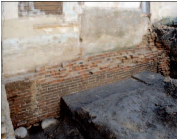
Abb. 6 Greifswald, Fleischerstraße 17. Brandwand zum südlichen Nachbargrundstück (um 1290). Erkennbar ist das Balkenaufleger (erhalten nur ganz links im Bild) und der Zahnungsblock für eine erwartete aber später nicht ausgeführte Kellerrückwand (ganz rechts). Blick nach Südwesten. Foto: T. Rütz (1997)
