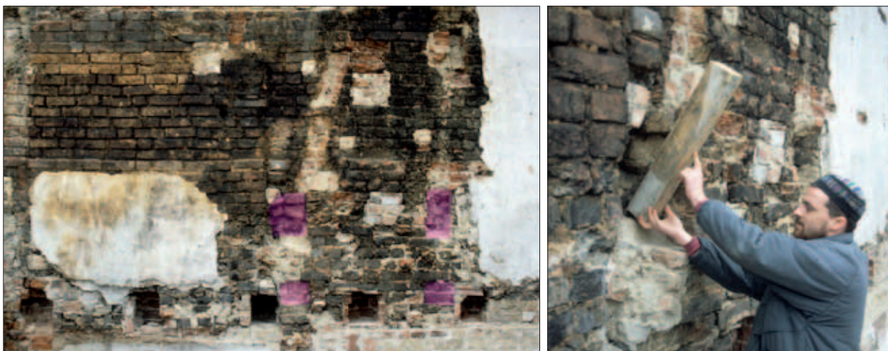
Abb. 7 und 8 Greifswald, Fleischerstraße 17. Brandwand zum nördlich angrenzenden Grundstück. In ca. 4 m Höhe konnten die Abdrücke von ummauerten Balkenköpfen freigelegt werden (violett hervorgehoben; unten = Deckenbalken, oben = Sparren/Aufschieblinge). Die eingestemmtten Balkenlöcher (ganz unten) stammen von der letzten, um 1780 eingebauten, Balkendecke über dem Erdgeschoss. Die starke Versot-tung ist u. a. auf die Lage der offenen Küche im barocken Brauhaus zurückzuführen. Blick nach Norden und Nordosten. Fotos: T. Rütz (1998)
