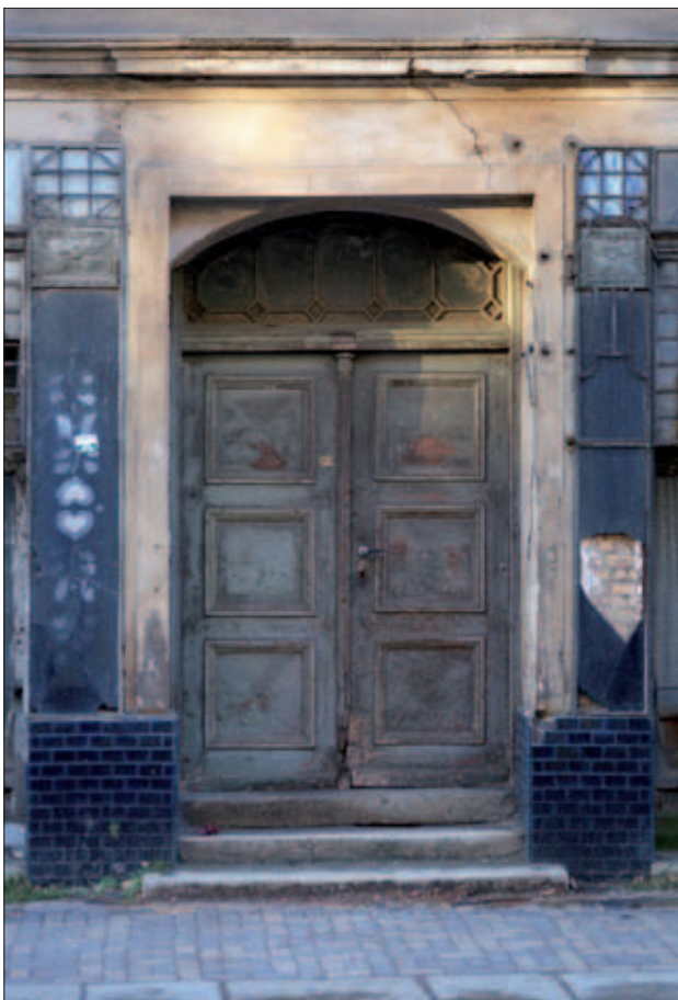
Abb. 11 Greifswald, Fleischerstraße 17. Kassetierte Haustür aus der Zeit um 1860. Sie wurde im Zusammenhang mit der spätklassizistischen Fassadenmodernisierung eingebaut. Foto: T. Rütz (1992)
