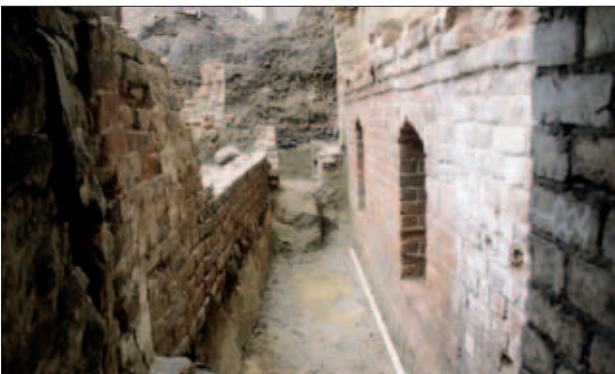
Abb. 12 Greifswald, Fleischerstraße 17. Wohl um 1697 hergestellter Verbindungsgang zwischen den Kellern von Vorderhaus und Seitenflügel. Der Fußboden des Ganges lag auf Höhe der Feldsteine der barocken Wand (links). Rechts im Bild die Brandwand zum nördlichen Nachbargrundstück mit Balkenaufleger und Schranknischen (M V, um 1330). Blick nach Westen. Foto: T. Rütz (1997)
