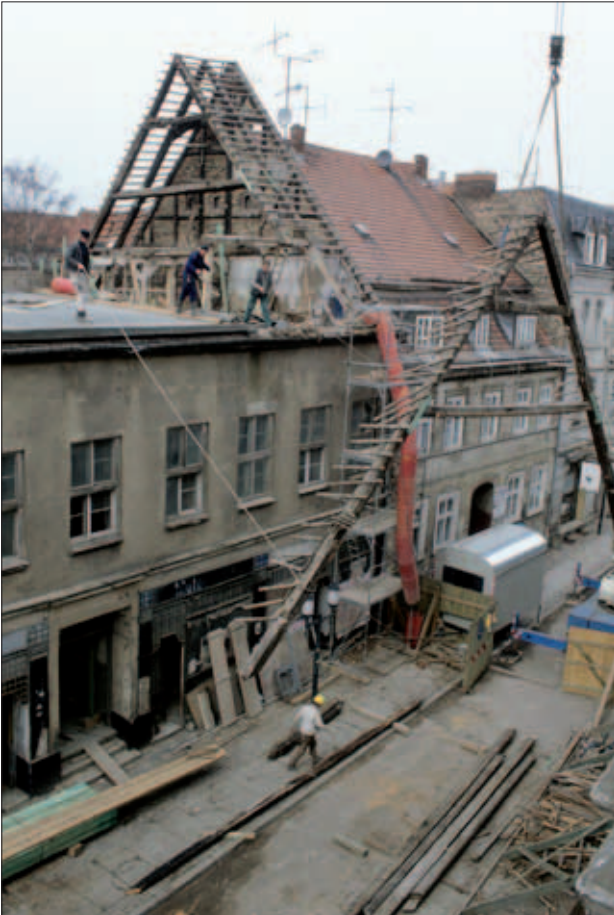
Abb. 14 Greifswald, Fleischerstraße 17. Straßenseite während des Abbaus der letzten Gebinde der Dachkonstruktion von 1697. Blick nach Nordwesten. Foto: T. Rütz (1994)
