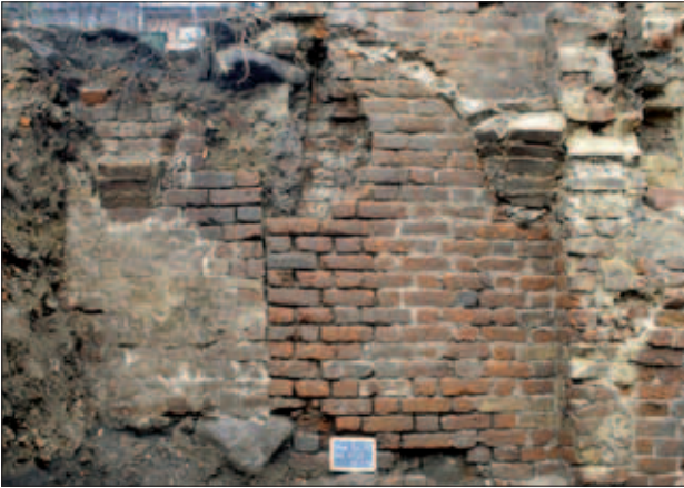
Abb. 11 Greifswald, Fleischerstraße 17. Nördliche Kellermauer im Seitenflügel. Vermutlich im Zusammenhang mit Bauarbeiten auf dem nördlichen Nachbargrundstück erhielt der Keller um 1500 eine neue Nordwand. Seine Einwölbung (siehe die Ansätze und die Gewölbepspur) erfolgte erst um 1697, etwa zeitgleich mit dem Bau des neuen Vorderhauses. Blick nach Norden. Foto: T. Rütz (1997)
