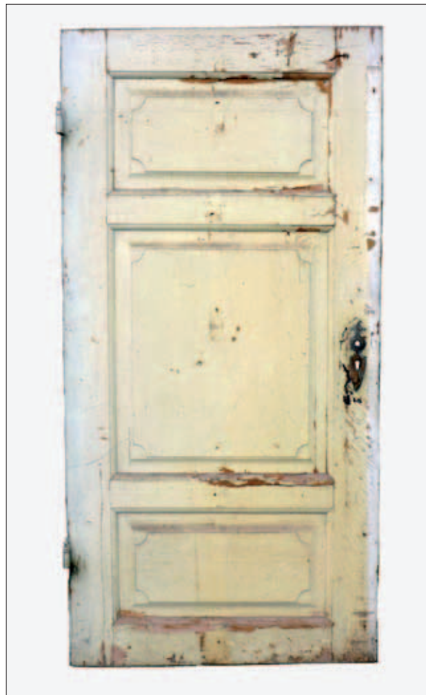
Abb. 9 Greifswald, Fleischerstraße 17. Die Dreifüllungtür gehörte zur Neuausstattung des Hauses in den 1780er Jahren. Erkennbar ist die ursprüngliche Altrosa-Fassung des Türblattes. Das als Abdruck erkennbare Schlüsselschild stammte erst aus der Mitte des 19. Jahrhunderts. Foto: T. Rütz (2014)
