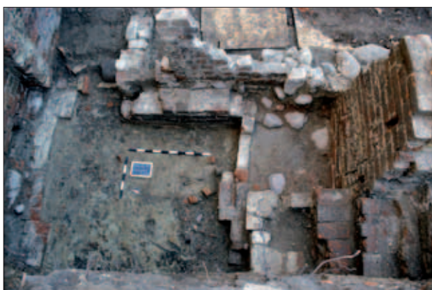
Abb. 9 Greifswald, Fleischerstraße 17. Reste des Seitenflügels. Im Fuß-boden des wohl um 1330 entstandenen Kellers konnte ein weiterer, tiefer reichender mittelalterlicher Einbau freigelegt werden. Rechts die später nochmals unterfangene Süd-wand des Kellers (um 1330). Unten rechts ein nachträglich in die Wand eingebrochener Zugang mit baro-cker Treppe. Blick nach Osten. Foto: T. Rütz (1997)
