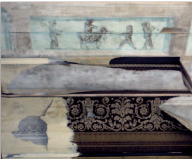
Abb. 14 Greifswald, Fischstraße 24. Freigelegtes Feld einer Deckenmalerei in der Art eines figürlichen Basreliefs. Über diesem hochklassizistischen Dekor wurden zudem Reste einer kostbaren gedruckten Tapete gefunden, die aus der Mitte des 19. Jahrhunderts stammte. Foto: T. Rütz (1995)
