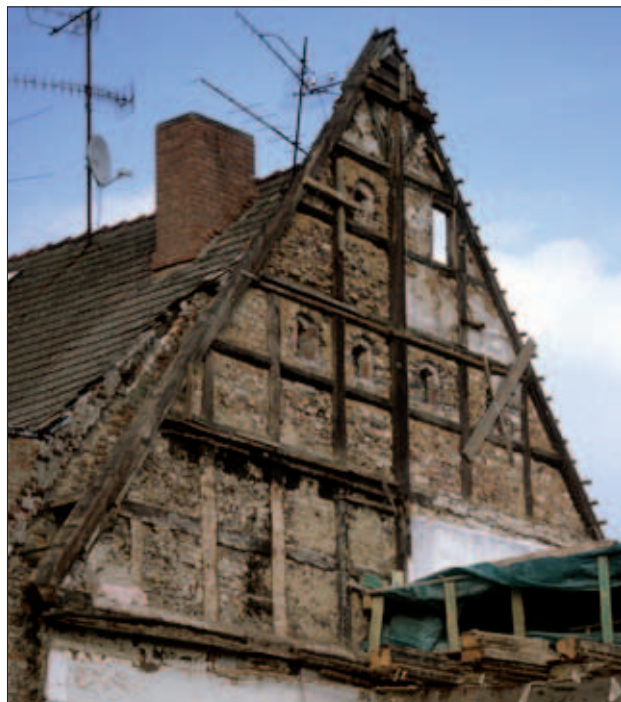
Abb. 5 Greifswald, Fleischerstraße 17. Innenseite des Nordgiebels. Typisch für die Giebelarchitektur aus Fachwerk sind im 17. Jahrhundert in Vorpommern die bis zum First durchlaufenden Mittelständer mit V-förmigen Verstrebungen in der Giebelspitze. Blick nach Nordosten. Foto: T. Rütz (1997)
