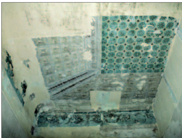
Abb. 2 Greifswald, Fleischerstraße 17. Beispiel für eine Scheinarchitektur: Der Plafond im Salon mit der gemalten Simulation einer hohen Gewölbekonstruktion. Foto: T. Rütz (1992)
