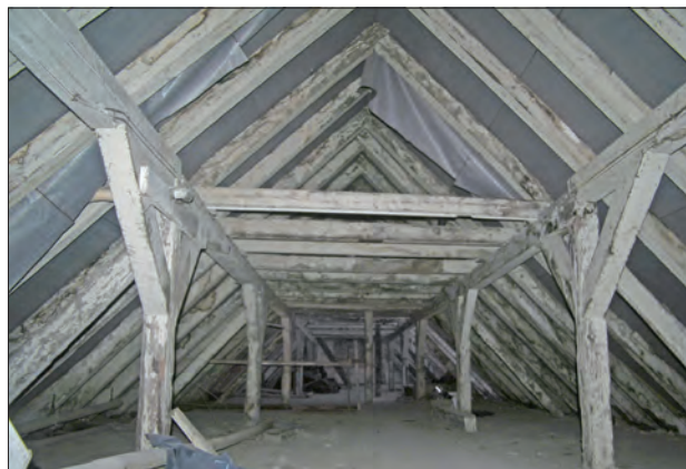
Abb. 16 Greifswald, Lange Straße 82. Oberdach des Seitenflügels. In diesem oberen Bereich des Dachs hat sich die 1788 oder 1789 entstandene Konstruktion mit ihrem doppelt stehenden Stuhl fast vollständig erhalten. Blick nach Süden. Foto: D. Brandt (2014)
