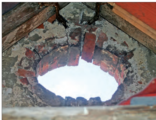
Abb. 17 Greifswald, Lange Straße 82. Oberdach des Seitenflügels von 1788/1789. Innenansicht der nördlichen Giebelspitze. Ähnlich wie in beiden Giebeln des älteren Vorderhauses gibt es auch hier ein quer liegendes Ochsenauge. Blick nach Norden. Foto: D. Brandt (2014)
