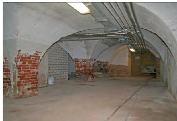
Abb. 18 Greifswald, Lange Straße 82. Keller des Seitenflügels. Im Zuge des von Carl Friedrich Pogge veranlassten Neubaus entstand hier eine zweischiffige, fünfjochige Kellerhalle. Die Gewölbe sind denen unter dem Vorderhaus ähnlich. Blick nach Norden. Foto: D. Brandt (2014)
