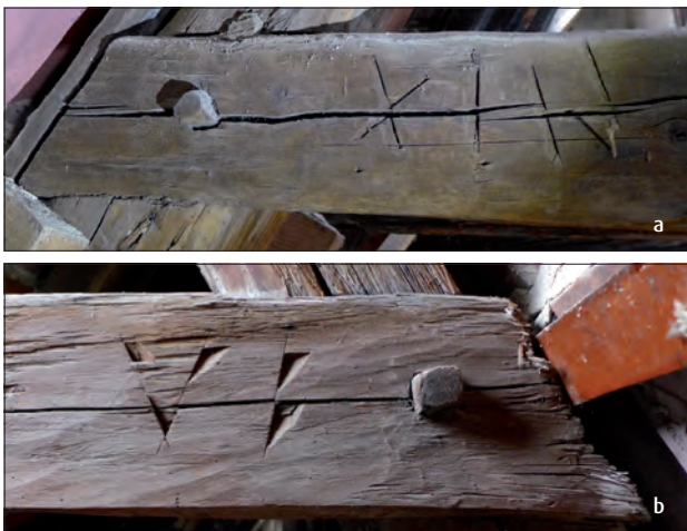
Abb. 5 Greifswald, Knopffstraße 20. Abbundmarkierungen im römischen System. Die Zählzeichen bestehen an der nördlichen Dachseite aus Kerben (a, Gebinde XIII), im Süden sind gehauene Linien und dreieckige Ausstiche („Fähnchen“) kombiniert (b, Gebinde VII). Fotos: T. Rütz (2015)
