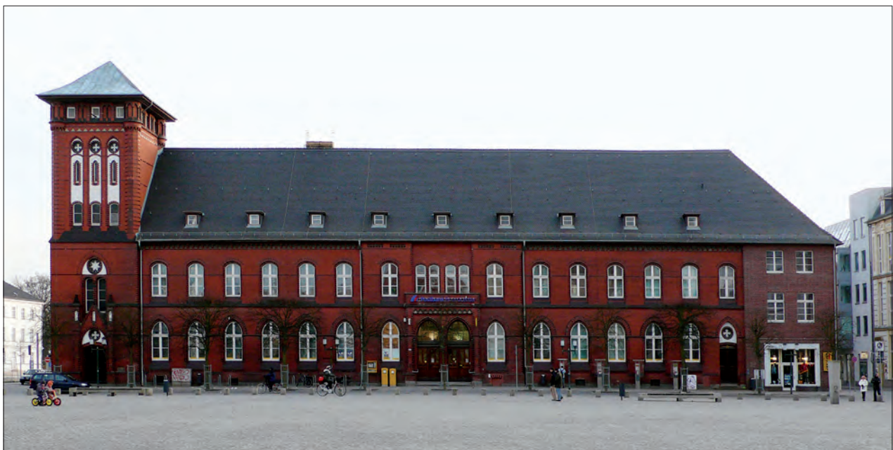
Abb. 1 Greifswald, Markt 15-19. Marktsüdseite mit dem ehemaligen Reichspostgebäude von 1894/1896. Die heutige, eher schlichte Fassadengestalt geht auf eine deutliche Zurücknahme der historistischen Architekturelemente im Jahr 1931 zurück. Blick nach Süden. Foto: T. Rütz (2007)
