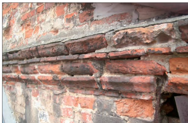
Abb. 15 Greifswald, Lange Straße 82. Ostgiebel des Vorderhauses. Blick nach Südwesten auf das Stockgesims. An der Außenseite ist das Fachwerk des Giebels massiv verblendet. Das kleinteilig profilierte Gesims betont die Grenze zwischen Unter- und Oberdach. Es wurde durchaus zeittypisch aus Formsteinen und Dachziegeln gemauert. Foto: D. Brandt (2014)
