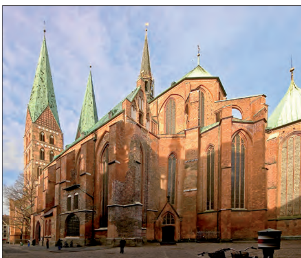
Abb. 2 Lübeck, St. Marien. Blick nach Nordwesten auf den Chor, das südliche Seitenschiff und die Bürgermeisterkapelle (großes vergittertes Fenster im Bild links). Foto: Thomas Berg (2007)
