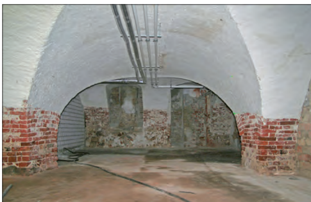
Abb. 7 Greifswald, Lange Straße 82. Mittlerer Bereich im Gewölbekeller des Vorderhauses. Unter dem Gebäude existieren hintereinander zwei von Osten nach Westen ausgerichtete Tonnen. Wegen der tief eingeschnittenen Kappen und da die trennende Mittelmauer auf kurze, pfeilerartige Abschnitte reduziert ist, wirken sie wie Kreuzgratgewölbe. Blick nach Süden. Foto: D. Brandt (2014)
