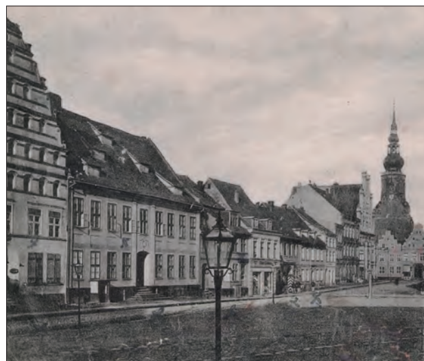
Abb. 5 Greifswald, Markt 15-19. Fotoaufnahme aus dem späten 19. Jahrhundert mit den Vorderhäusern der Grundstücke Markt 16-19. Zu dieser Zeit gab es auf der Südseite des Marktes überwiegend Traufenhäuser, einzig das Gebäude Nr. 16 war giebelständig. Blick nach Südwesten. Abbildung: Stadtarchiv Greifswald Rep. 59 B1, S. 120 (Ausschnitt)
