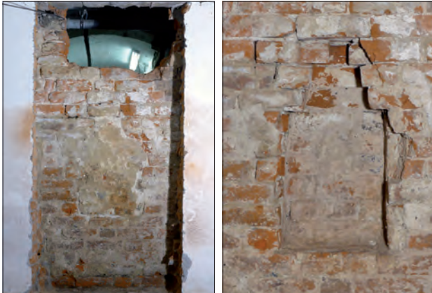
Abb. 15 Greifswald, Markt 15-19. Lichtnische mit abgetrepptem Sturz in der um 1300/1310 errichteten östlichen Brandmauer von Markt 19. Die Aufnahmen zeigen den Zustand vor und nach Entfernung einer nachträglichen Zusetzung. Blick nach Osten. Fotos: T. Rütz (2012)
