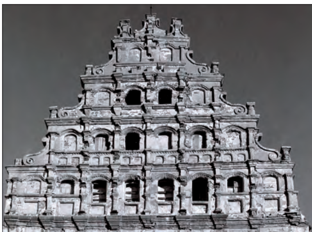
Abb. 6 Greifswald, Knopfstraße 20. Der Schaugiebel nach der statischen Grundsicherung (erkennbar sind die verschraubten Eisenplatten als Verbindung zum Betonfachwerk im Inneren). Die Sanierung der Oberflächen erfolgte Ende der 1980er Jahre. Blick nach Osten. Foto: T. Rütz (1986)
