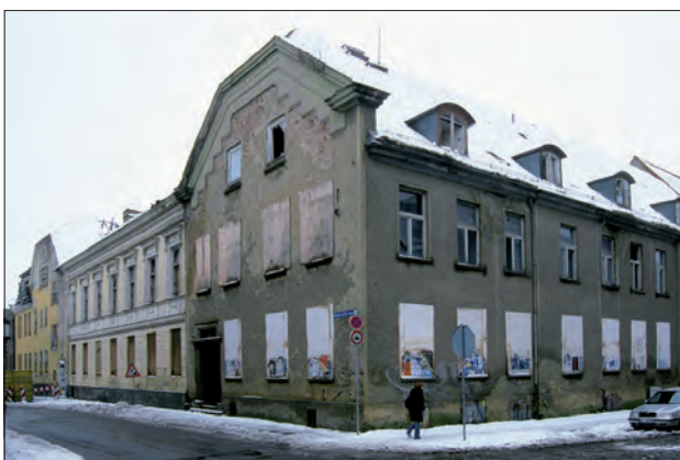
Abb. 1 Greifswald, Friedrich-Loeffler-Straße/Hunnenstraße. Straßenfront der Friedrich-Loeffler-Straße zwischen Steinbecker- und Hunnenstraße vor Abbruch der im Mittel- und Westabschnitt zuletzt vorhandenen Bebauung (links). Blick nach Nordwesten. Foto: T. Rütz (2005)
