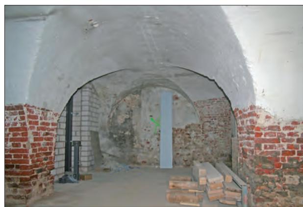
Abb. 19 Greifswald, Lange Straße 82. Keller des Seitenflügels. Massive Kellerwölbungen gehörten beim Neubau von Häusern in Greifswald während der zweiten Hälfte des 18. Jahrhunderts zum Standard. Die bis in das 17. Jahrhundert in der Stadt über den Kellern weithin üblichen Balkendecken sind zu dieser Zeit nur noch in wenigen Fällen entstanden. Blick nach Westen. Foto: D. Brandt (2014)
