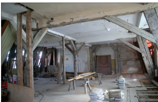
Abb. 10 Greifswald, Lange Straße 82. Unterdach des Vorderhauses. Trotz der im Zuge späterer Ausbauten erfolgten Veränderungen ist die ursprüngliche Dachkonstruktion zu großen Teilen erhalten geblieben. Der mittlere Stuhl und die seitlichen Kopfbänder zwischen Sparren und Kehlbalken sorgten dafür, dass die Hausböden große Lasten tragen konnten. Blick nach Nordosten. Foto: D. Brandt (2014)
