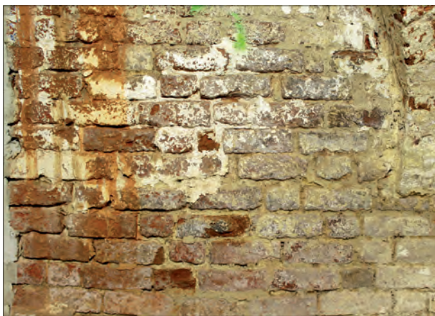
Abb. 4 Greifswald, Lange Straße 82. Nordmauer im Kellergeschoss des Haupthauses. Detail zu Abb. 3: Die mittelalterliche Mauerschale wurde in einem regelmäßigen Wendischen Verband aufgeführt, das Backsteinmaterial zeigt eine für die Zeit um 1280 typische, kräftig rote Brandfarbe. Blick nach Norden. Foto: A. Lutze (2016)
