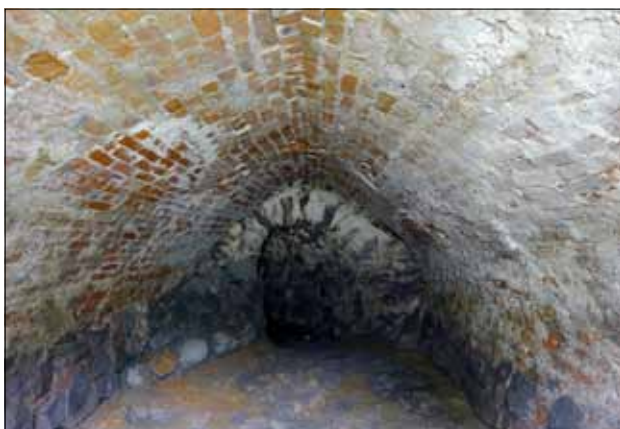
Abb. 17 Greifswald, Bereich Vettentor. Blick nach Norden in den überwölbten Kanal aus der zweiten Hälfte des 14. Jahrhunderts. Im Hintergrund der 1811 angeschlossene Kanal aus Feldsteinen. Foto: T. Rütz (2014)
