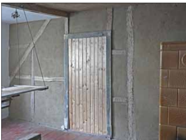
Abb. 9 Greifswald, Bahnhofstraße 6. Südöstlicher Eckraum im Dachgeschoss. Die Türbekleidung des ehemaligen Zugangs von Westen weist klassizistische Formen auf und stammt wie der Treppenaufgang womöglich aus der Errichtungszeit des Hauses (vgl. Abb. 8). In diesem Bereich des Dachgeschosses gab es wahrscheinlich von Beginn an eine beheizbare Kammer mit zwei Fenstern in einer Gaube zur Straßenseite (vgl. Abb. 7). Blick nach Südwesten. Foto: R. Neumann (2020)
