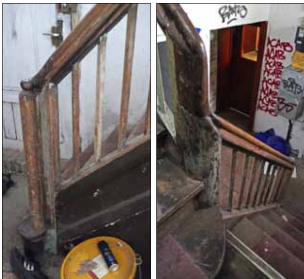
Abb. 8 Greifswald, Bahnhofstraße 6. Treppenaufgang vom Erd- ins Dachgeschoss. Die in der Nordwestecke des Hauses befindliche Treppenanlage lässt sich stilistisch in das erste Drittel des 19. Jahrhunderts datieren. Vermutlich gehörte sie zur Erstausrüstung des Gebäudes, welches nach Schriftquellenauswertung 1829 bereits existiert haben dürfte. Im Umbauplan von 1862 ist die Treppe als Bestand eingetragen (vgl. Abb. 7). Blick nach Südwesten (links) und nach Südosten. Fotos: R. Neumann (2020)
