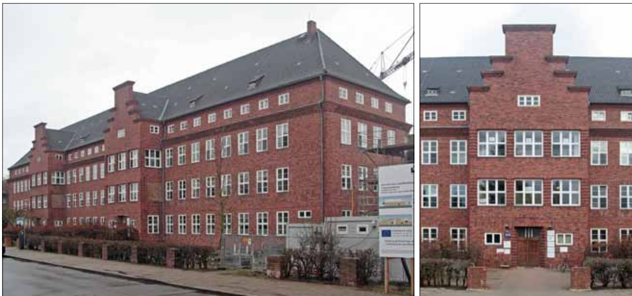
Abb. 17 Greifswald, Fleischmannstraße 42/44. Von 1927 bis 1929 entstand das Gebäude der Poliklinik und Klinik für Haut- und Geschlechtskrankheiten (heute Klinik und Poliklinik für Nuklearmedizin) als langgestreckter dreieinhalbgeschossiger Backsteinbau. Mit seiner Materialwirkung und den von Stufengiebeln bekrönten Risaliten wurden hier die Vorbilder der regionalen Gotik zitathaft aufgegriffen. Die von regelmäßigen Reihen einfacher Rechteckfenster untergliederten Wandflächen sind farblich durch in verschiedenen Rottönen changierende Hartbrandsteine gestaltet, welche in markanten Bereichen abstrakt-geometrische Formen ausbilden (vgl. Abb. 3). Blick nach Nordwesten (links) und nach Nordosten. Fotos: D. Brandt (2020)
