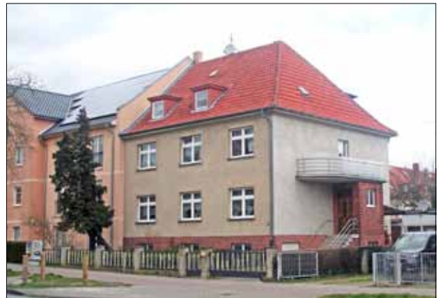
Abb. 7 Greifswald, Wolgaster Straße 108. Dem in den frühen 1930er Jahren mit schlichten Glattputzfassaden errichteten Gebäude ist seitlich ein backsteinsichtiger Vorbau angelagert. Der dort befindliche Eingangsbereich wird von einem vorkragenden Balkon mit gerundeter Stirnseite überdacht. Blick nach Nordwesten. Foto: D. Brandt (2020)
