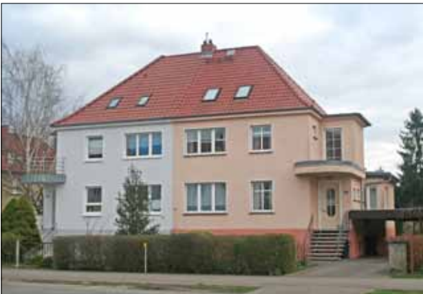
Abb. 6 Greifswald, Wolgaster Straße 59/60. Das Doppelwohnhaus entstand Anfang der 1930er Jahre. Die glatten Putzfassaden werden lediglich durch einfache Rechteckfenster gegliedert. Über den seitlichen Anbauten mit den Hauszugängen kragen Balkone mit gerundeten Stirnseiten aus der Fassadenflucht vor. Blick nach Südosten. Foto: D. Brandt (2020)
