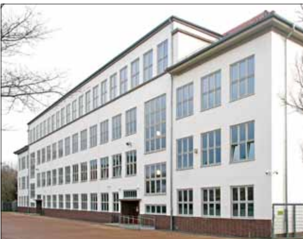
Abb. 13 Greifswald, Arndtstraße 37 (Ernst-Moritz-Arndt-Schule). Die hofseitige, durch verschieden große Rechteckfenster gegliederte Fassade wirkt insbesondere mit dem geradlinigen Abschluss des breiten und stark durchfensterten Dachausbaus besonders kompakt und „geometrisch modern“. Blick nach Nordosten. Foto: D. Brandt (2020)
