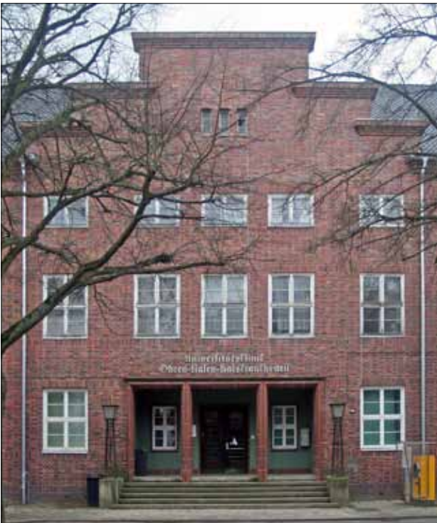
Abb. 19 Greifswald, Walther-Rathenau-Straße 43-45. Nordostflügel der ehemaligen Klinik für Hals-, Nasen- und Ohrenkrankheiten. Der gestufte Giebel über dem Mittelteil mit dem Hauptzugang kontrastiert als Motiv einer traditionsbezogenen Backsteinarchitektur mit dem modern-funktionalen Inneren des Klinikgebäudes und den expressionistisch akzentuierten Oberflächentexturen der verklinternten Fassaden (vgl. Abb. 18). Blick nach Südwesten. Foto: D. Brandt (2020)
