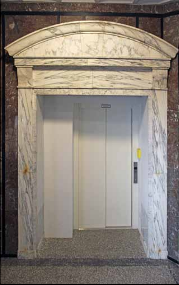
Abb. 13 Greifswald, Lange Straße 82. Treppenhaus im südwestlichen Bereich des Seitenflügels an der Fischstraße. Im Erd- und Obergeschoss wurde der jeweilige Zugang vom Treppenhaus in den Ladenbereich durch eine aus Marmor bestehende Portalrahmung (hier Erdgeschoss) erheblich aufgewertet. Passend zur Stilistik des Hauses gab man diesen Rahmungen eine neobarocke Form. Blick nach Norden. Foto: A. Lutze (2014)
