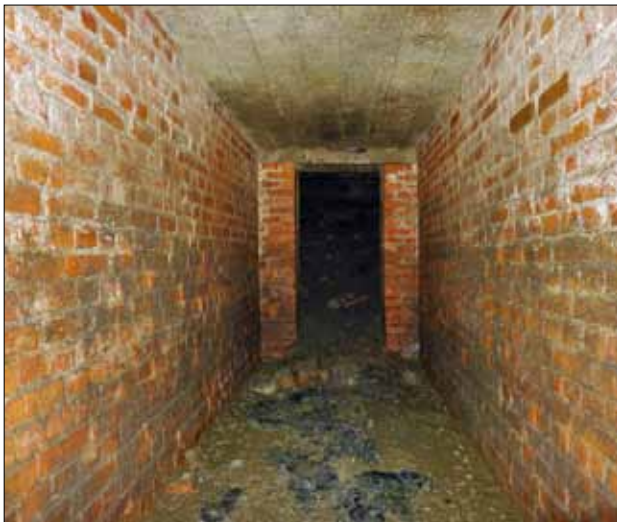
Abb. 19 Greifswald, Bereich Vettentor. Blick nach Süden in einen wohl während der 1940er Jahre errichteten Schleusenraum mit Betondecke. Dieser wurde als Eingangsbereich südlich des zum Schutzraum umfunktionierten mittelalterlichen Brückengewölbes genutzt. Foto: T. Rütz (2014)
