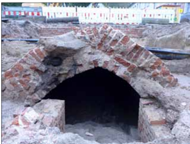
Abb. 16 Greifswald, Bereich Vettentor. Blick nach Norden auf den Schnitt durch den Brückenbogen. Oben das eineinhalb Stein dicke Mauerwerk der mittelalterlichen Spitztonnen (hier in frühneuzeitlichem Reparaturmauerwerk dokumentiert), darunter die frühneuzeitliche zumeist halb Stein dicke Unterfangung. Foto: T. Rütz (2014)
