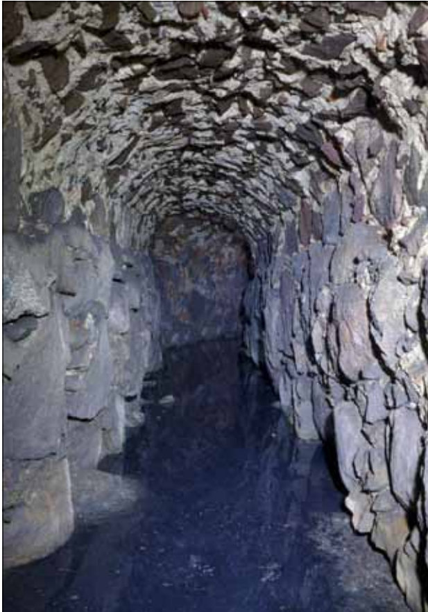
Abb. 18 Greifswald, Bereich Vettentor. Blick nach Südosten in den 1811 aus Feldsteinen gesetzten Kanal. Durch ihn wurde im Zusammenhang mit der geplanten Einebnung des Walls an der westlichen Stadtmauer ein Wasserlauf umgeleitet. Foto: T. Rütz (2014)
