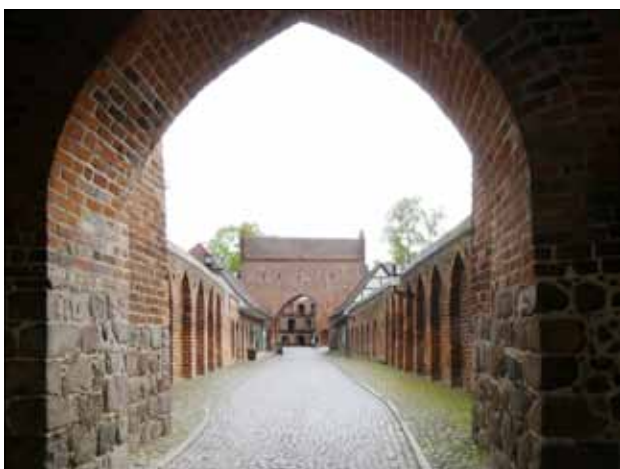
Abb. 11 Neubrandenburg, Friedländer Tor. Blick nach Nordosten durch das Haupttor in Richtung des Vortores und eines jüngeren Rondells zum Schutz der Feldseite. Zwischen Haupttor (Anfang 14. Jahrhundert) und Vortor (1328 d) sind die Zwingermauern erhalten, die in Greifswald nur noch in den Fundamenten existieren. Foto: G. Schindler (2017)
