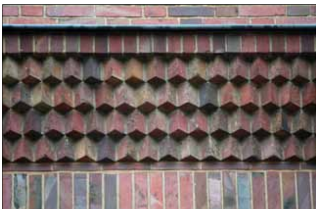
Abb. 3 Greifswald, Fleischmannstraße 42/44. Das als Poliklinik und Klinik für Haut- und Geschlechtskrankheiten errichtete Gebäude entstand von 1927 bis 1929. Sein Hauptgesims ist vierlagig abtappend aus im Zickzack-Verband verlegten Backsteinen zusammengesetzt. Detail an der Straßenseite (vgl. Abb. 17). Blick nach Nordosten. Foto: D. Brandt (2020)
