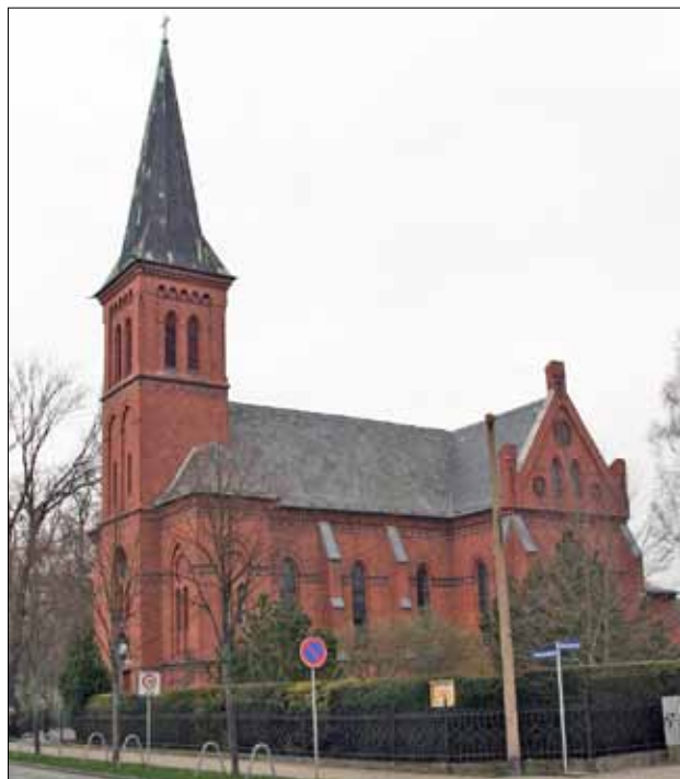
Abb. 10 Greifswald, Bahnhofstraße 14. Von 1869 bis 1871 wurde für die katholische Gemeinde ein neues Gotteshaus errichtet. St. Joseph (zunächst Pius-Kirche genannt) entstand als Backsteinbau in Formen der Neogotik. Die westlich am Gebäude vorbeiführende Rubenowstraße entstand erst im Jahr 1876, wodurch die Parzelle zu einem Eckgrundstück wurde. Blick nach Nordosten. Foto: R. Neumann (2005)
