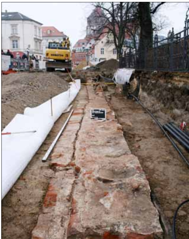
Abb. 10 Greifswald, Bereich Mühlentor. Nördliche Zwingermauer aus dem 14. Jahrhundert und der frühen Neuzeit, mit Abdrücken von Feldsteinen auf der Mauerkrone. Blick nach Nordwesten. Foto: G. Schindler (2013)
