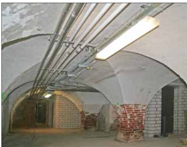
Abb. 2 Greifswald, Lange Straße 82. Blick nach Südwesten durch den Gewölbekeller des Seitenflügels. Unter den Gebäuden des Anwesens existiert eines der großen Kellergewölbensysteme der Greifswalder Altstadt. Gerade für die versteckte Lagerung geschmuggelter Waren boten die weitläufigen Räume optimale Möglichkeiten. Foto: D. Brandt (2014)
