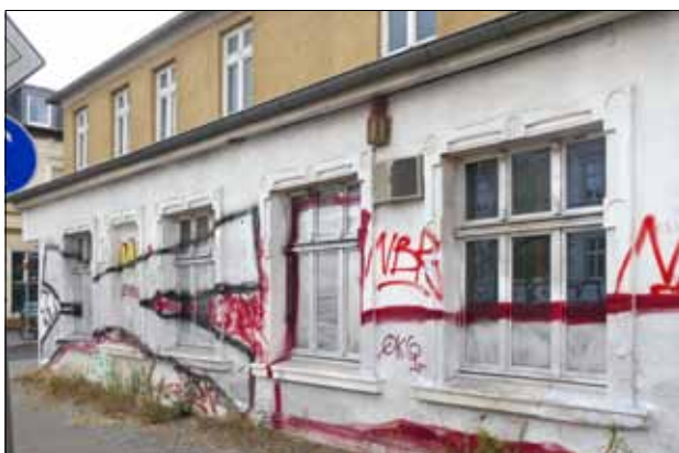
Abb. 15 Greifswald, Bahnhofstraße 6. Eine grundlegende Veränderung der Putzgestaltung erfolgte offenbar nach 1903 (vgl. Abb. 14). Oben: Planungszeichnung für eine 1928 bereits wieder notwendig gewordene Überarbeitung der Hauptfassaden. Die Putzflächen wurden erneuert; die vorhandenen Rahmungen der Fenster blieben dabei erhalten, wurden aber farblich neu gefasst. Als Blick nach Nordosten. Abbildung: Bauamtsakte: Bahnhofstraße 6, fol. sine (Ausschnitt). Unten: Aktueller Zustand der Fassade zur Bahnhofstraße mit den Fensterrahmungen aus der Zeit nach 1903. Blick nach Nordwesten. Foto: R. Neumann (2020)
