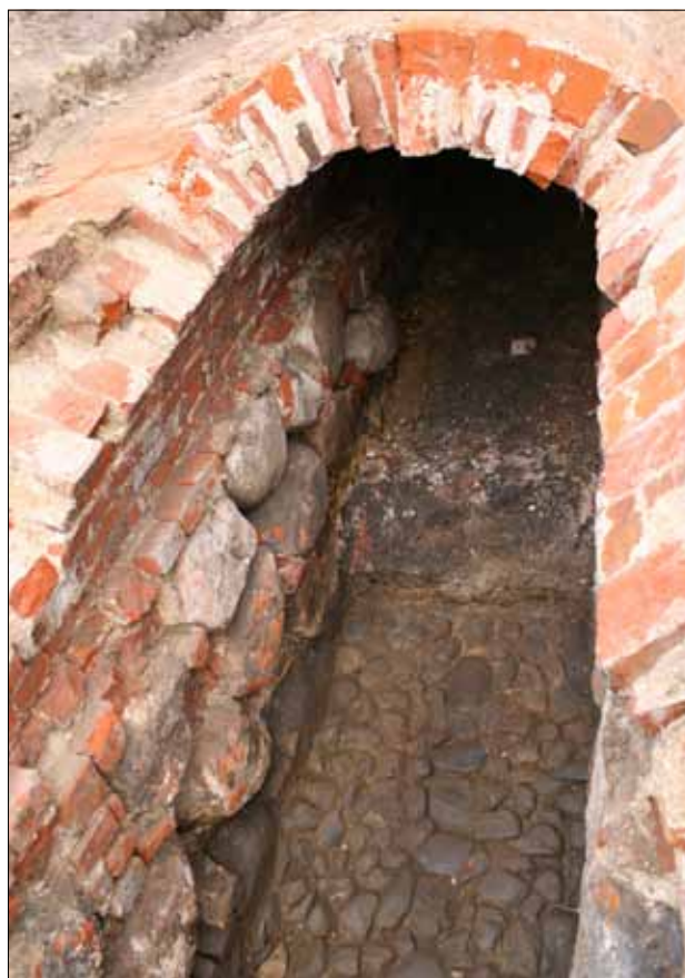
Abb. 9 Greifswald, Bereich Mühlentor. Inneres des um 1800/1810 östlich des Tores errichteten Kanals, mit gepflastertem Boden und Kappengewölbe versehen. Blick nach Nordosten. Foto: G. Schindler (2014)
