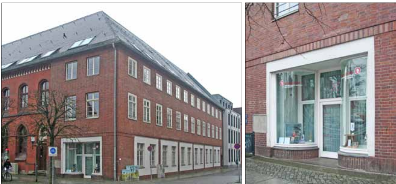
Abb. 9 Greifswald, Am Markt 15 („Stadthaus“). In den Jahren 1931/1932 entstand im westlichen Anschluss an das 1896 fertiggestellte Postgebäude der Annexbau für ein Telefon- und Fernmeldeamt. Die ästhetische Qualität des insgesamt äußerst zurückhaltend gestalteten Backsteinbaus zeigt sich vor allem in der Materialwirkung der farblich nuancierten, akkurat vermauerten Hartbrandsteine. Lediglich im Erdgeschoss wurden die Fassaden durch rechteckige Putzfelder differenzierter gegliedert. Zum Markt hin sind innerhalb eines solchen Feldes die Schaufenster-Vitrinen eines Ladens angelegt (rechts), mit gerundeten Glaselementen zuseiten des nischenartigen Eingangsbereichs. Blick jeweils nach Südosten. Fotos: D. Brandt (2020)
