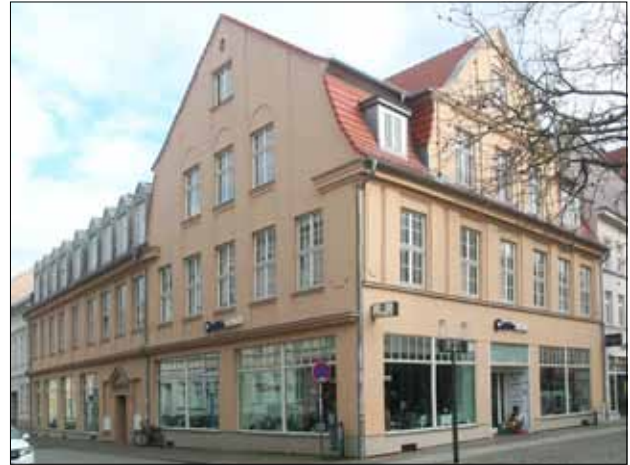
Abb. 1 Greifswald, Lange Straße 82. Das Vorderhaus und der Seitenflügel zeichnen sich durch große Breite, Mehrgeschossigkeit, massive Bauweise und repräsentative Mansarddächer aus. Ihre Fassaden prägen das Bild des Fischmarktes und des südlichen Teils der Fischstraße erheblich mit. Blick nach Nordosten. Foto: D. Brandt (2020)
