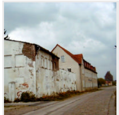
Abb. 3.1-2: Desolate Gewerbebrachen am Ryck in Fußwegentfernung zur Innenstadt
