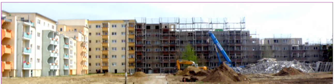
Vor dem Umbau, Planung und während des Umbaus des Ostseeviertels-Parkseite
