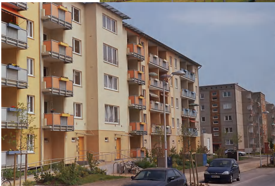
Das A4-Quartier zu Beginn des Rückbaus 2004 und nach der Fertigstellung
