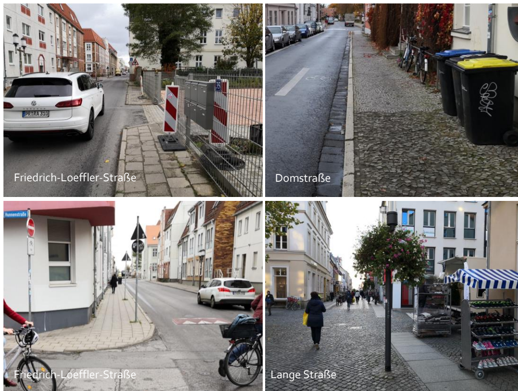
Abbildung 13: Mängel in Gehwegbreite und Oberfläche
