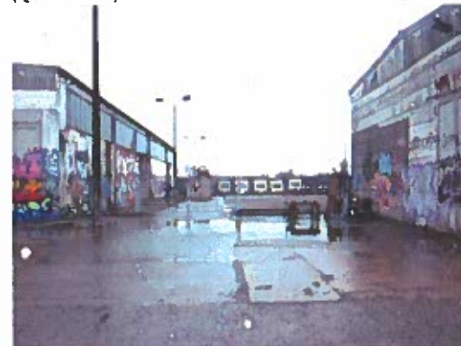
Abb. 10: Ungenutzte Hallen/Brachflächen (Quelle: IPO)
