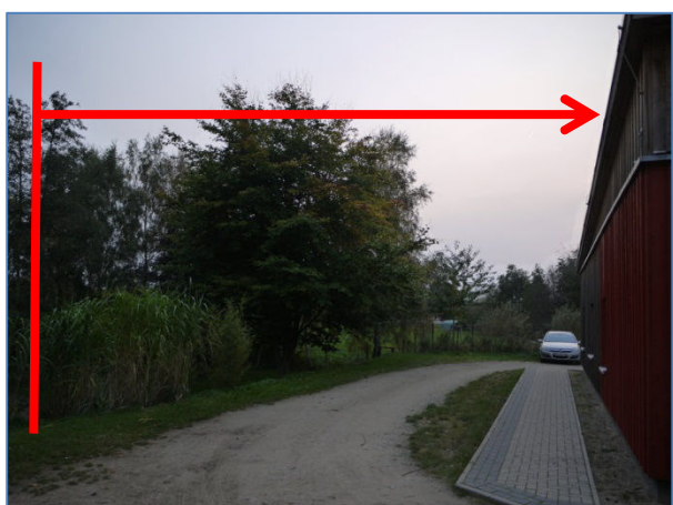
Abb. 6 Bereich mit überragender Aufstockung.
