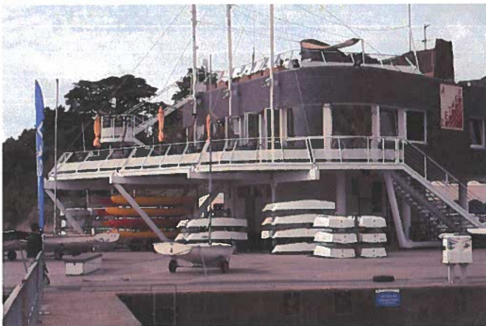
Beispiel: Multifunktionsgebäude in La Trinité sur Mer (Frankreich) maritim gestaltet
