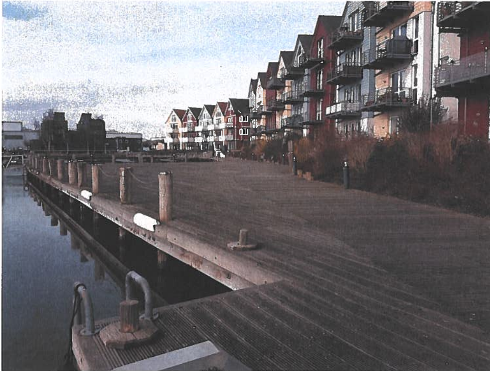
Abb. 3: Mittlerer Teil des Steges
