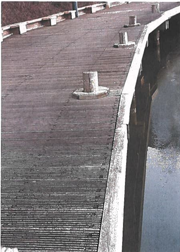
Abb. 6: Westlicher Abschnitt mit sanierten Pfahlköpfen
