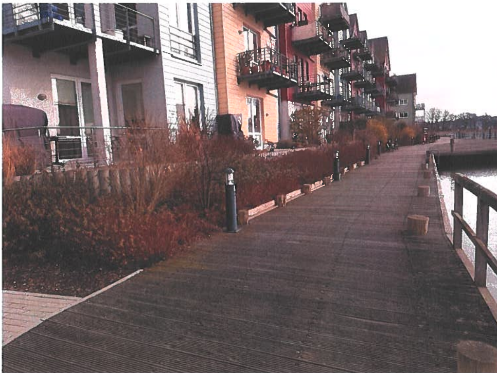
Abb. 2: Blick vom westlichen Ende Richtung Westen
