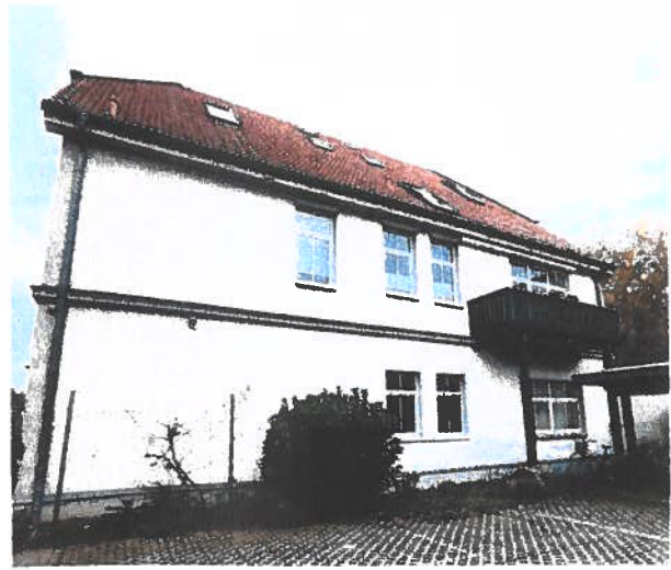
Hofansicht (Lage im Erdgeschoss)
