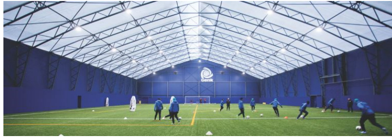
Abbildung 68: Beispiele für eine realisierte Spielfeldüberdachung in Genk Belgien.
