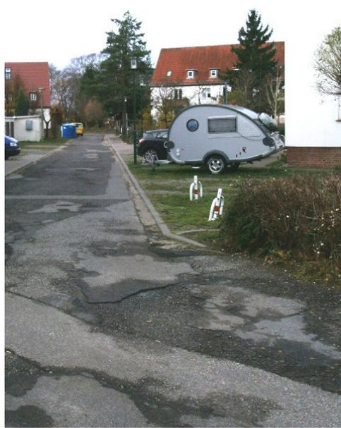
Abb. 47: Asphaltschäden
