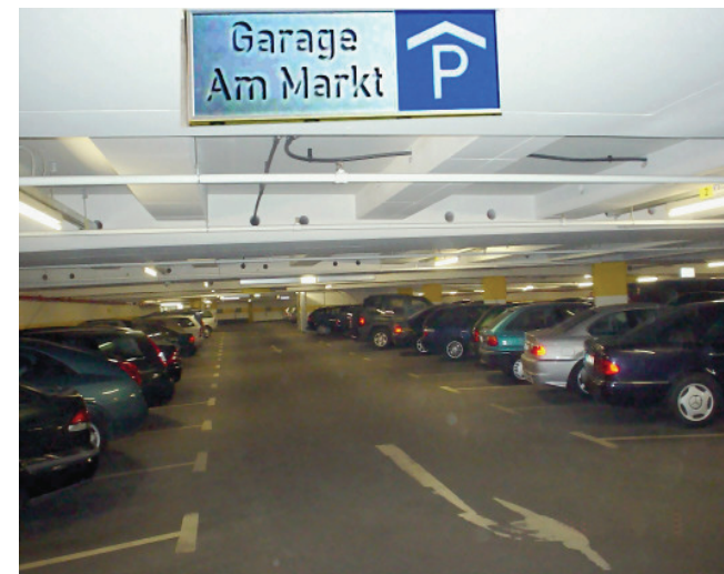
Eröffnung der stützenfreien benutzerfreundlichen Tiefgarage Am Markt mit 273 Stellplätzen am 30.10.2003
