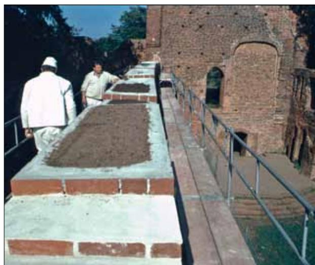
**Abb. 26** Greifswald, Klosterruine Eldena. Westliche Längsmauer des Ostflügels unmittelbar nach Erneuerung der stufen- und muldenförmig ausgebildeten, zum Teil bereits mit Erdschicht gefüllten Mauerkronen. Südlich vor der Querhaussüdmauer (rechts) ist der Tribüneneinbau von 1969 zu sehen. Blick nach Norden. Foto: A. Lutze (1996)
