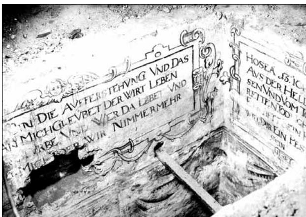
**Abb. 8** Wismar, St. Marien. Blick nach Nordosten in die Gruft des 1654 gestorbenen Bürgermeisters und Syndicus Arnold Böddeker. In die Längsmauern eingefügte Querholme ermöglichten eine Belegung in Ebenen. Die Innenwände waren im oberen Bereich mit Bibelziten in Beschlag- und Rollwerkrahmung und darunter mit (Stoff)Draperien ausgestattet. Foto: Stadtarchiv Wismar, Fotosammlung A VII, 19 (Aufnahme 1941)
