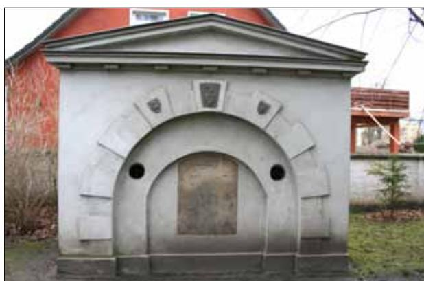
**Abb. 9** Greifswald, Alter Friedhof. Grabgebäude der Familien von Vahl und Gesterding, errichtet im Jahr 1823. Die Schaufassade entspricht auch in Details dem Entwurf Friedrich Gillys (vgl. Abb. 8). Bis zur Sanierung 1995 waren noch einige der Rosetten um den ehemaligen Zugang erhalten. Die Zumauerung des Einganges wurde bereits 1925 veranlasst. Blick nach Nordwesten bzw. Westen. Fotos: T. Rütz (1992) / A. Kretschmer (2008)
