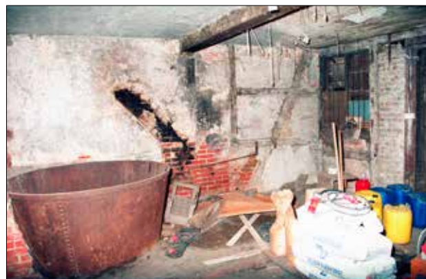
Abb. 10 Greifswald, Lange Straße 57. Das Werkstattgebäude von 1844 im Erdgeschoss. Der Raum mit Siedekessel vor Sanierung und Umbau war ursprünglich nicht mit den benachbarten Räumen des Erdgeschosses verbunden und besaß eine eigene Treppe in das Kellergeschoss. Blick nach Westen. Foto: T. Rütz (1992)
