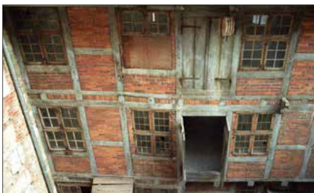
Abb. 7 Greifswald, Lange Straße 57. Blick auf die nördliche Hoffassade des Werkstattgebäudes mit Ladeluken und Aufzugsrolle. Die Fensterzargen und -flügel stammen wohl weitgehend aus dem 18. und frühen 19. Jahrhundert und wurden am Gebäude wiederverwendet. Blick nach Süden. Foto: T. Rütz (1992)
