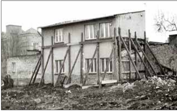
Abb. 28 Greifswald, Rotgerberstraße 8 („Stomatologische Universitätsklinik“). Anbau westlich des Gebäudes der ehemaligen Kegelbahn, Ansicht vom westlichen Nachbargrundstück. Eine Abstützung verhinderte den Einsturz des Gebäudes (1960). Foto: S. Hänsch, Sammlung Th. Klink
