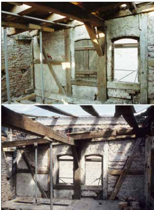
Abb. 9 Greifswald, Lange Straße 57. Das Werkstattgebäude von 1844 im zweiten Obergeschoss. Erkennbar sind die dreiseitig ummauerten Fachwerkhölzer sowie Spuren älterer Erstverwendungen (Zapfen- und Stakenlöcher) an einigen Hölzern. Blick nach Osten. Fotos: T. Rütz (1992)
