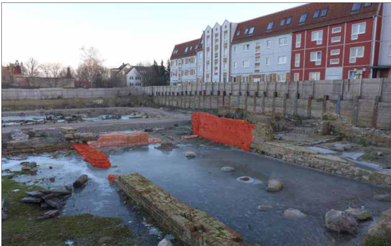
Abb. 11 Greifswald, Brüggestraße 48/Nord. Freigelegte Kellermauern des Kernbaus aus der Zeit um 1270/80. Östlich dahinter die Mauern der späteren Verlängerung zum Vollkeller um 1300 (farbig hervorgehoben). Blick nach Südosten. Foto: T. Rütz (2016)
