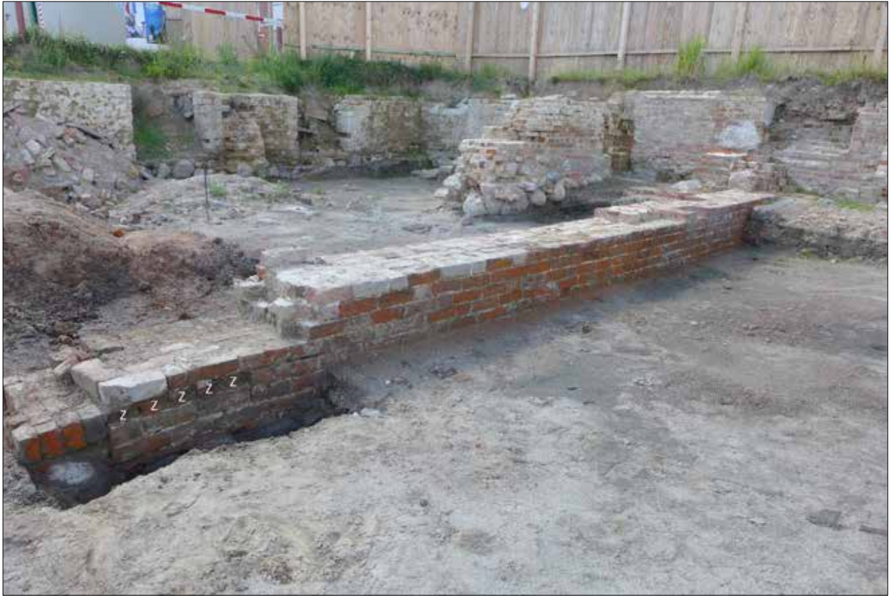
Abb. 10 Greifswald, Brüggestraße 49. Brandwand (um 1280) nach Süden. Mit „Z“ gekennzeichnet die abgearbeiteten Binder für die vorbereitete Ein-zahlung der (Keller-)Rückwand. Dahinter die Reste der Verlängerung der Brandwand (um 1300) für die Vollunterkellerung des Giebelhauses. Blick nach Südwesten. Foto: T. Rütz (2014)
