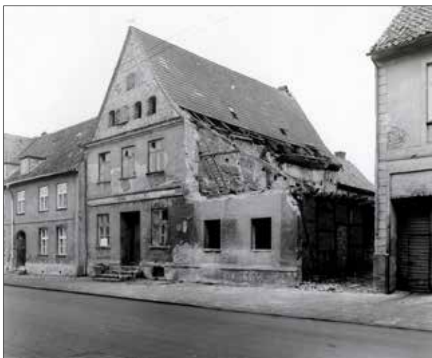
Abb. 18 Greifswald; Fischstraße 37. Erkennbar die südliche Brandwand mit einem hinteren Teil aus Fachwerk. Vielleicht sind in dieser Form auch die frühen teilunterkellerten Giebelhäuser rekonstruierbar. Blick nach Nordosten. Foto: Stadtarchiv Greifswald, Fotosammlung AIC954 (während des Abbruchs in den 1970er-Jahren)
