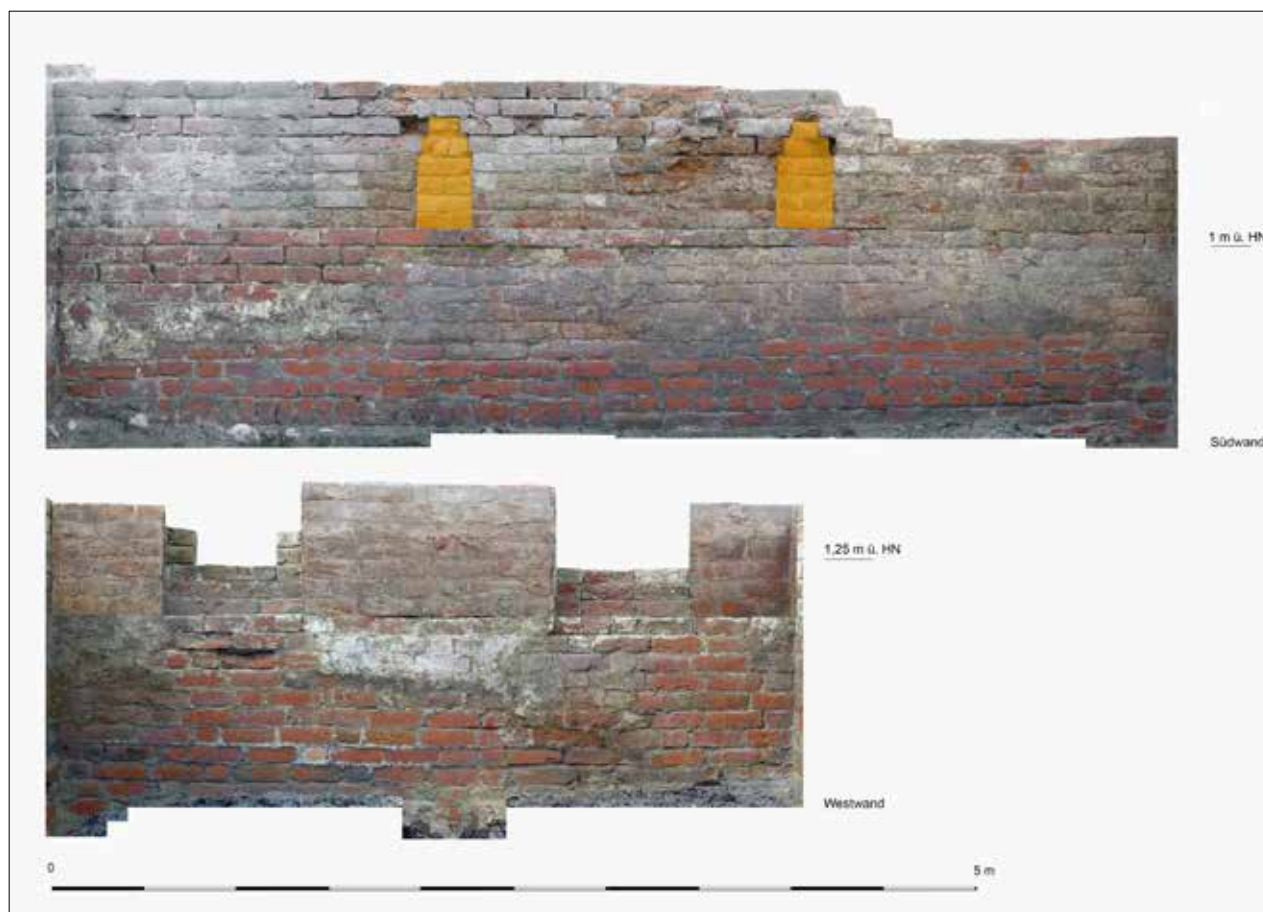
Abb. 13 Greifswald, Kuhstraße 3/Süd. Messbilder von Süd- und Westwand des Steinwerkes. In der Südwand kleine Nischen mit Treppensturz, in der Westwand zwei Fensterischen. Fotos: T. Rütz (2017)
