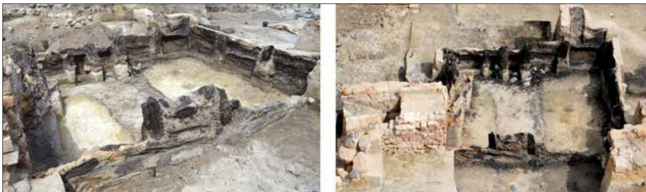
Abb. 34 Greifswald, Quartier A 11, Grundstück Brüggestraße 48 Süd. Vollständig abgebrannter, unterkellertes Seitenflügel. Links Blick nach Nordosten, rechts Blick nach Norden. Foto: R. Samariter (2015)
