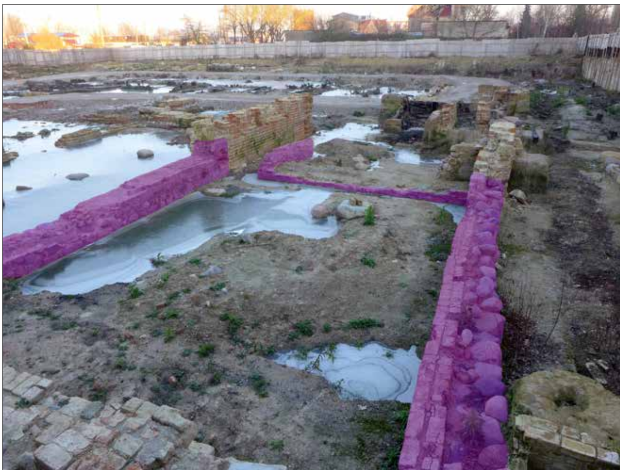
Abb. 5 Greifswald, Brüggestraße 48/Süd. Freigelegte Kellermauern des Kernbaus aus der Zeit um 1270 (farbig hervorgehoben). Die südliche Mauer (rechts) besteht rückseitig aus Feldsteinen. An dieser Seite grenzte die Mauer nicht an ein Nachbarhaus, sondern an eine Straße. Blick nach Osten. Foto: T. Rütz (2016)
