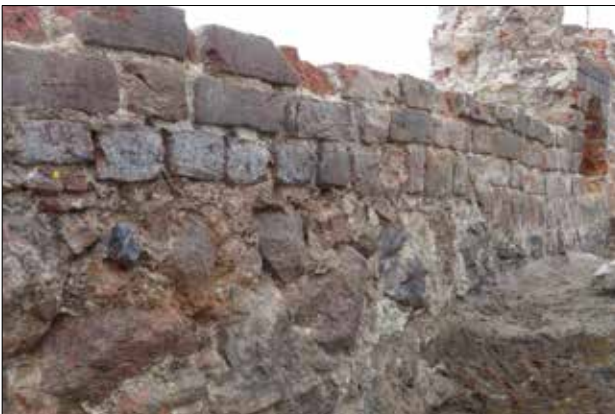
Abb. 4 Greifswald, Brüggstraße 48/Süd. Freigelegte Nordwand der Zeit um 1270. Ein Kennzeichen früher Backsteinmauern: Sowohl die obere Feldsteinlage als auch die erste Backsteinlage sind in Kalkmörtel gebettet. Später liegt zwischen der Oberkante der Feldsteine und der ersten Backsteinlage eine Sandschicht als Ausgleich. Blick nach Nordosten. Foto: T. Rütz (2014)
