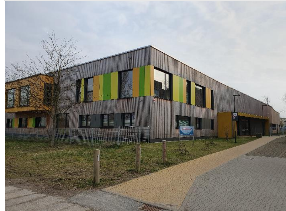
Foto 5 Neubau Kita „Zwergenland“ im Ostseeviertel-Ryckseite
