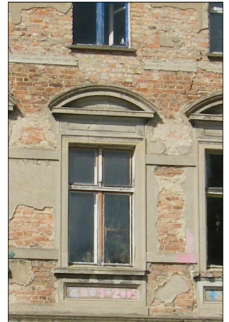
Abb. 20: Leerstandsgebäude, Potenzial für Dienstleistungsentwicklung
