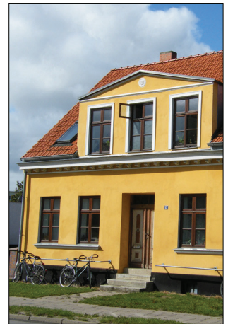
Abb. 4: Gründerzeitbebauung Loitzer Straße
