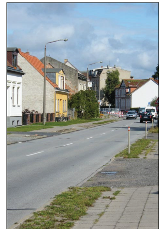
Abb.17: Loitzer Str. mit baulichen Mängeln, fehlender Radweg
