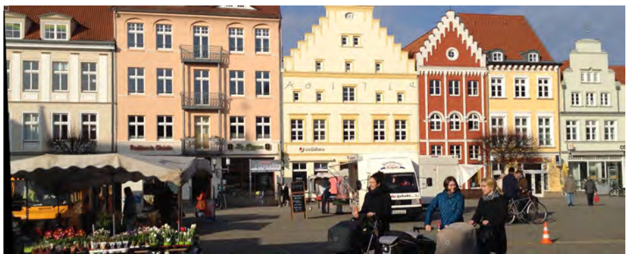
Abb. 1.27: Besondere Sanierungserfolge: Marktplatz und Museumshafen
