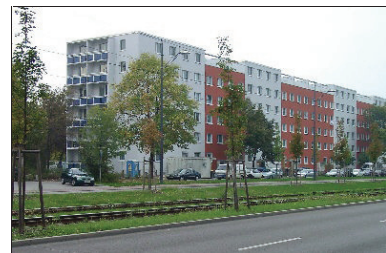
Saniertes Wohngebäude in Halle-Neustadt - einfache, seriell geprägte Gestaltung, keine „Fassadendekoration“
