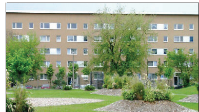
Erheblicher Leerstand in der fünften Etage eines sanierten Wohngebäudes in Leinefelde
