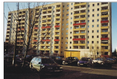
„Wildes“ Parken (Hochhäuser südlich der Einsteinstraße)
