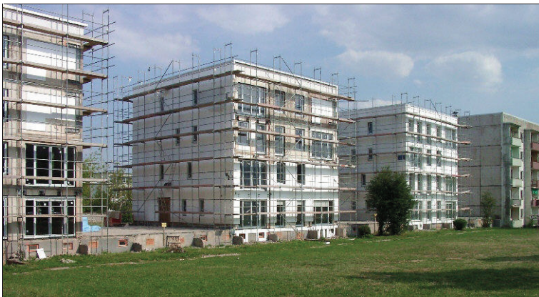
Umbau eines Fünfgeschossers zu Stadtvillen in Leinefelde – ein Geschoss und jeder zweite Aufgang wurden abgetragen, das Kellergeschoss belassen
