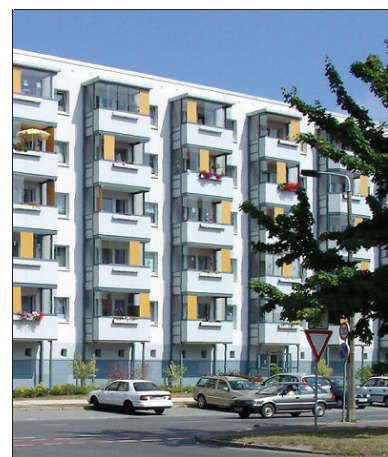
Saniertes Wohnhaus mit freundlichem Erscheinungsbild
