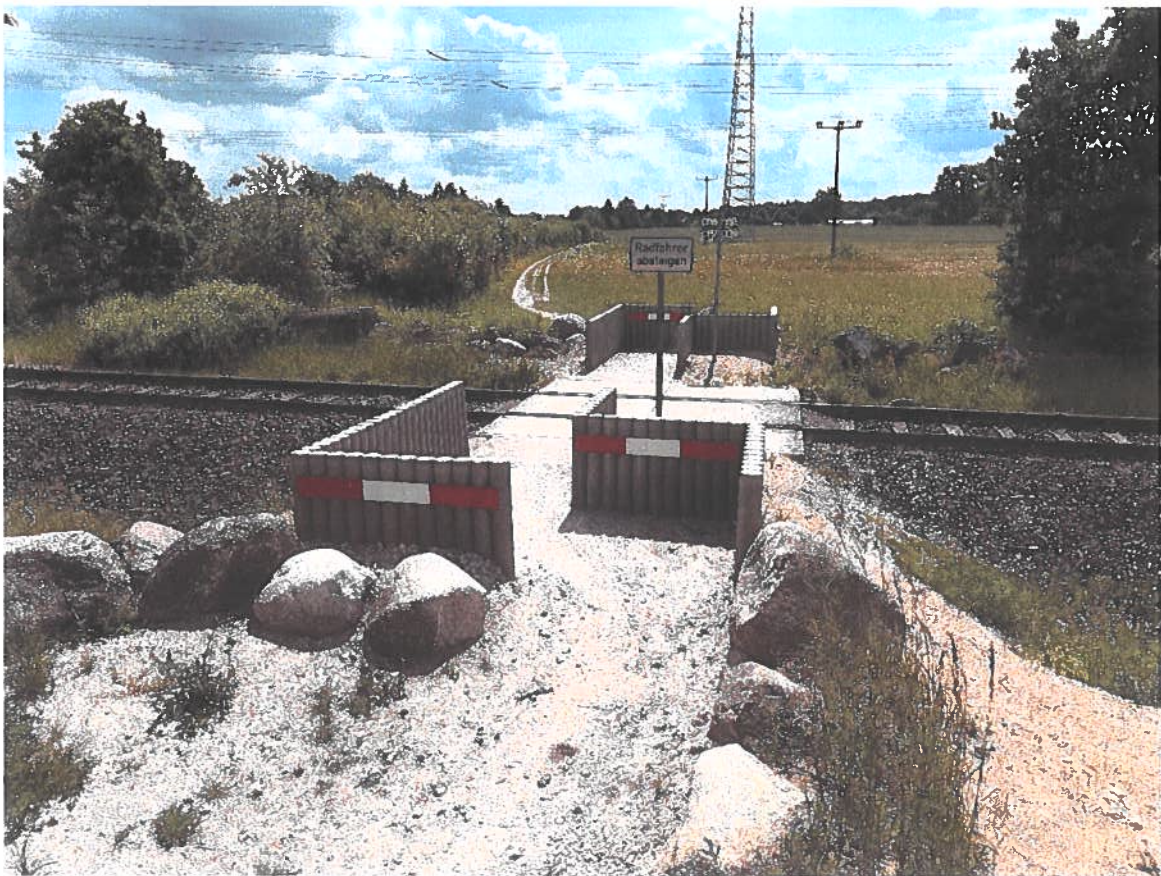
Bild 2: Guest Gleisübergang (offiziell)
