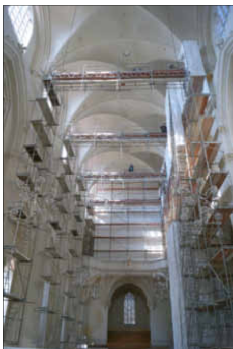
Gerüstbrücken unterhalb des Deckengewölbes des Doms ermöglichen den Spezialisten den Zugang. Foto: PEK/Sebastian Kühl
