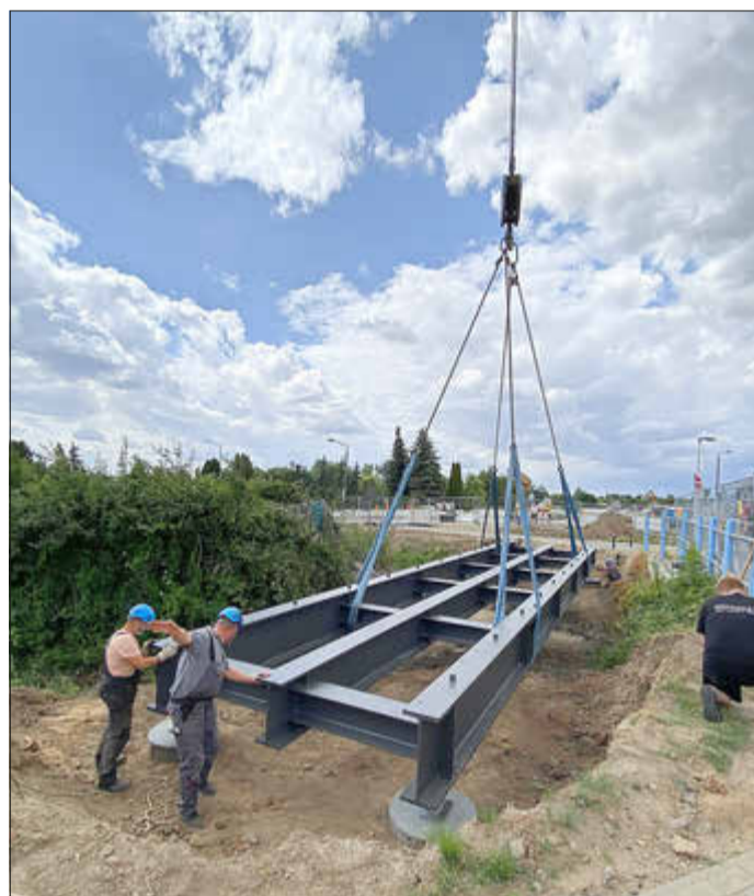
Die neue Stahlkonstruktion wurde mit Hilfe eines Krans montiert.
