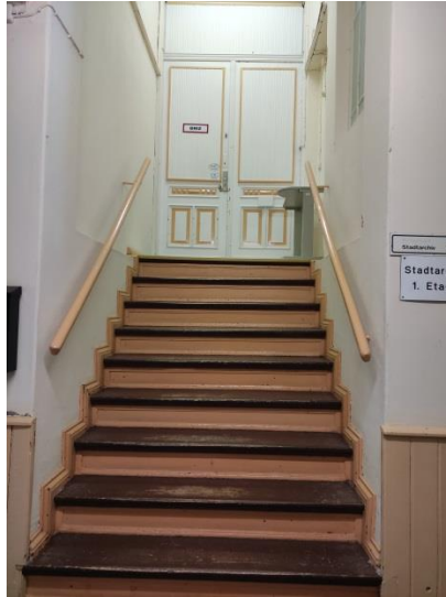
(7) Hausflur – Treppe zum ersten Geschoß
