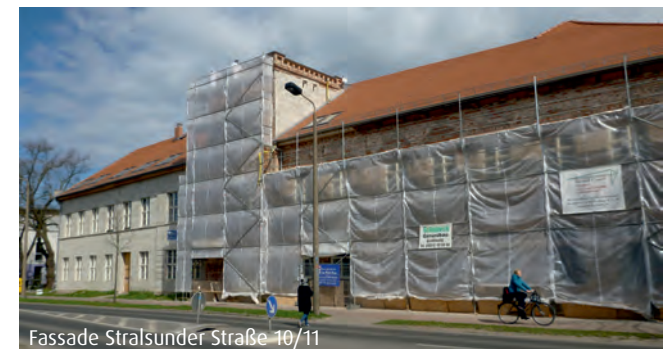
Fassade Stralsunder Straße 10/11
