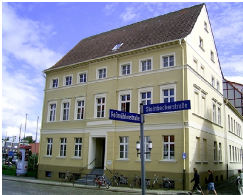
Musikschulgebäude in der Steinbeckerstraße 45, Haupteingang
