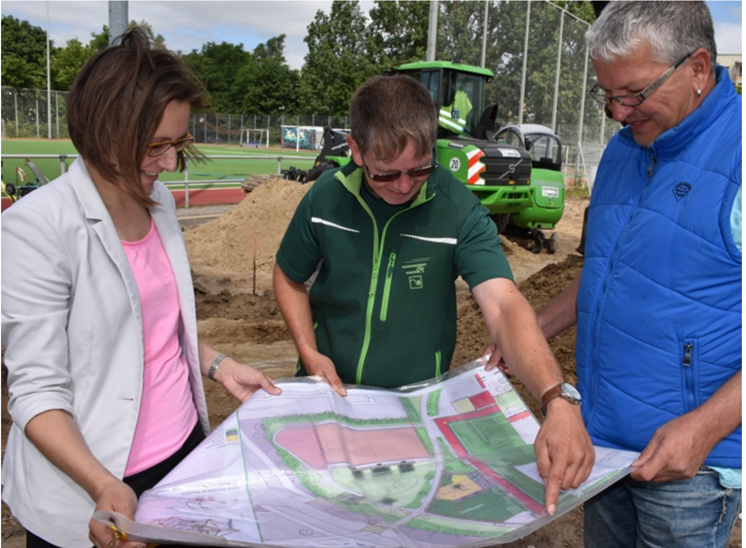
Frank Wagner, Vorarbeiter bei der Firma Gartenprofi Wuttig und Mirko Hille vom Immobilienverwaltungsamt erläutern Bausenatorin Jeannette von Busse den Plan, Foto: Pressestelle
