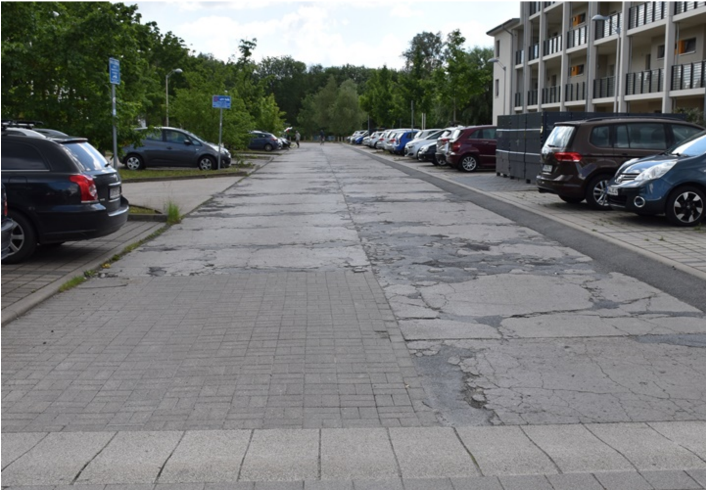
Der Gedser Ring wird in diesem Jahr saniert. Foto: Pressestelle
